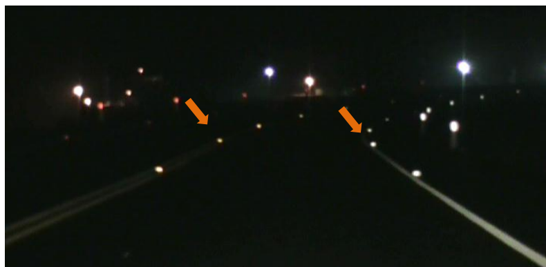
Foto 2.3: Tachas delineadoras en centro y borde de la vía
