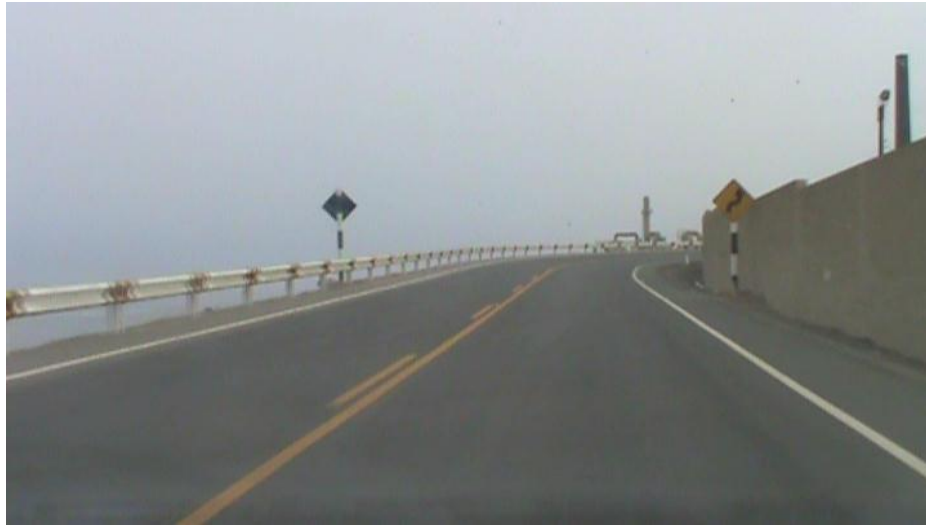
Foto 5.33:Km. 77+800 Inicio de curva: Baja visibilidad debido al muro (lado derecho) delimitador de la Fundición
