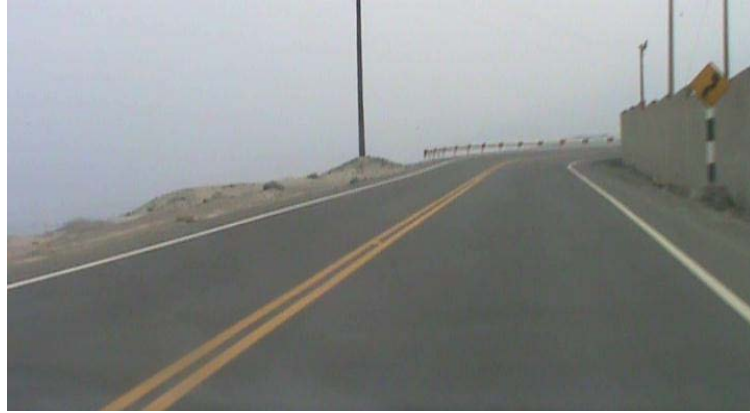
Foto 5.39: 76+500 Km. Baja visibilidad debido al muro de delimitador de la Fundación
