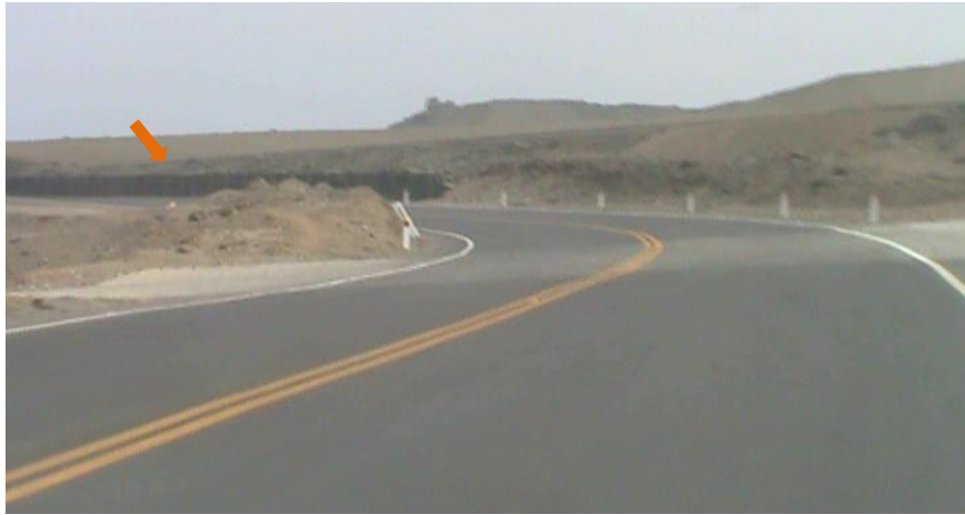
Foto 5.28: Km.80+200, Se observa curva en elevación, disminuye visibilidad.
