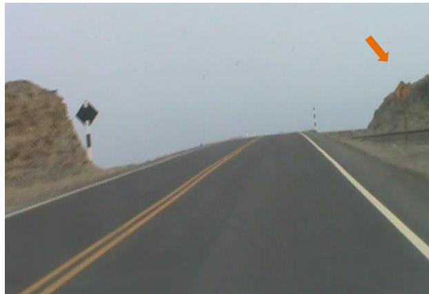
Foto 5.28: Km.80+200, Se observa curva en elevación, disminuye visibilidad.
