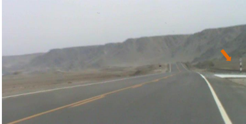
Foto 5.19 Km. 85+900 Unión de vía auxiliar por el lado derecho a la Vía principal
