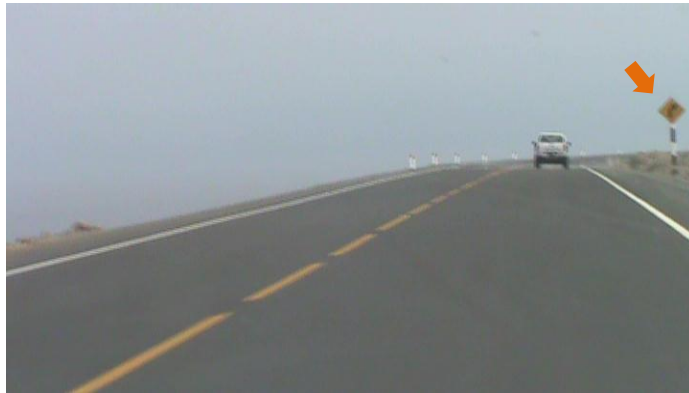
Foto 5.13: Siguiendo la trayectoria se observa la presencia de otra curva.
