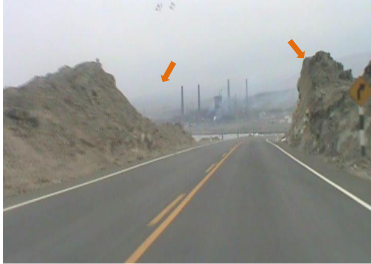
Obs20: Presencia de montículos rocosos en ambos bordes de la vía ingresando a una zona de curva
