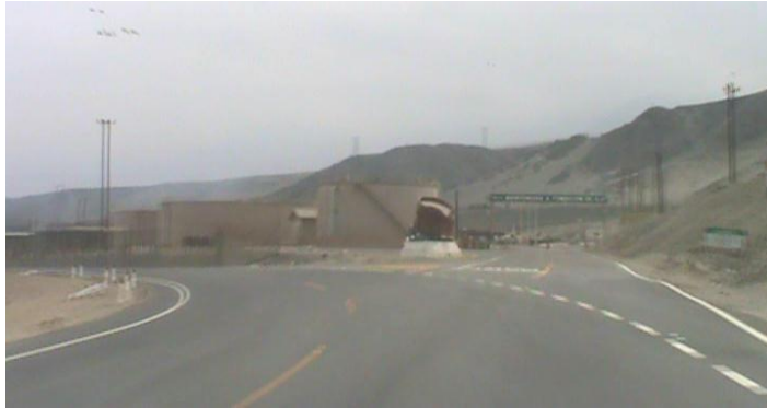
Foto 5.31: Km. 78+400, La carretera costanera continúa su trayectoria desviando a la izquierda. En trayectoria recta se ingresa a la Fundación de SPCC.
