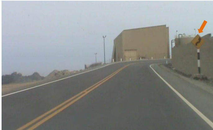
Foto 5.38: Curva Km.76+900. Baja visibilidad debido al muro de delimitador de la Fundición, En el lado izquierdo de la vía se encuentra instalación de SPCC (Planta IDE).
