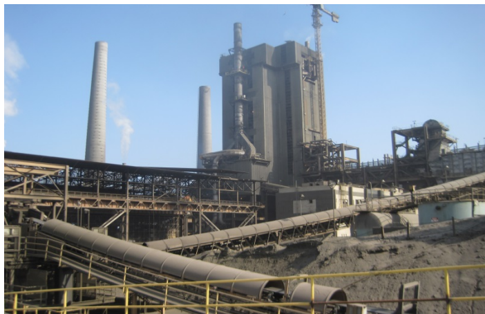
Foto 3.1: Edificio ISAsmelt Fundición de ILO
