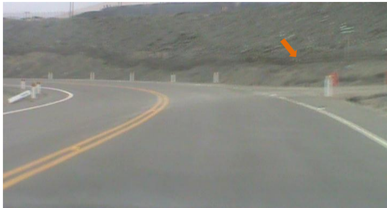
Foto 5.40: Km. 76+350 Fin de tramo de estudio - Entrada lado norte a Fundación SPCC
