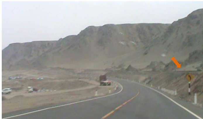
Foto 5.20: Ingreso a una curva de radio grande
