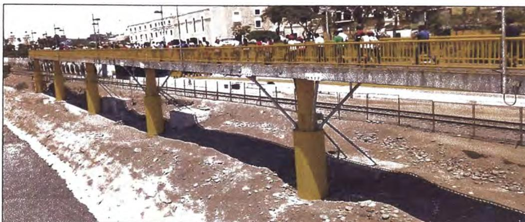
Figura 45 Puente Rayito de Sol con rigidizadores.
