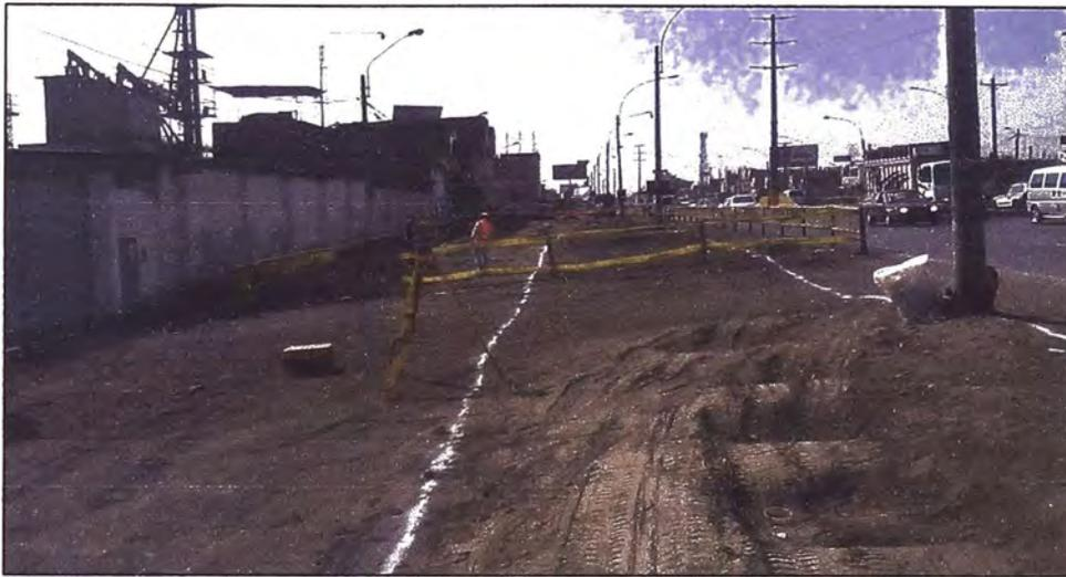
Figura 81 Interferencia de postes de alumbrado en proyección de zapata de puente
