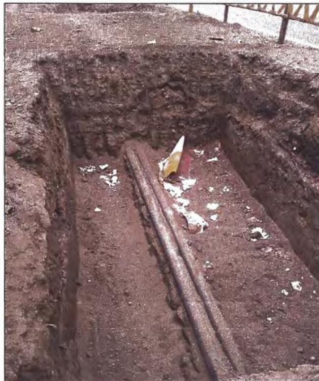
Figura 80 Interferencia de línea de telefonía en excavación de zapata de puente.
