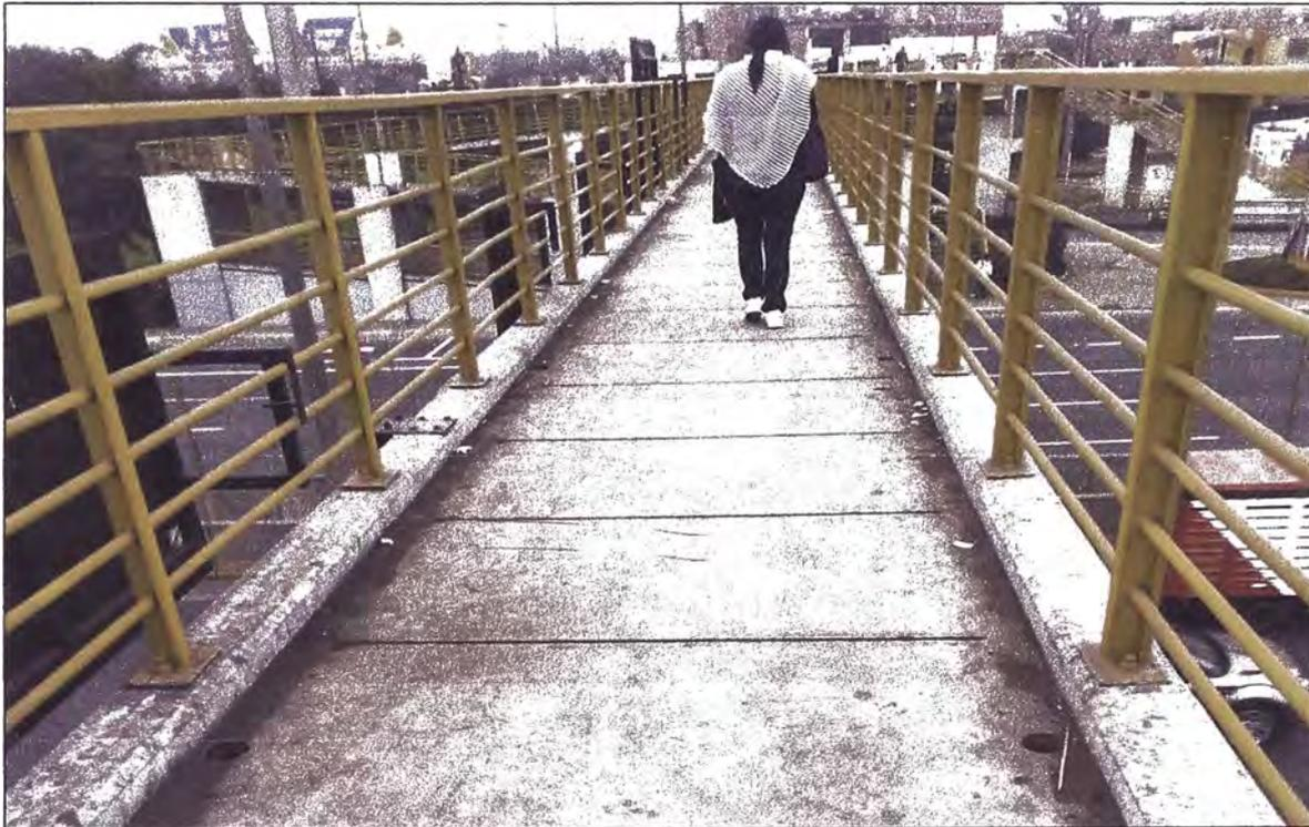
Figura 53 Puente con drenaje adecuado
