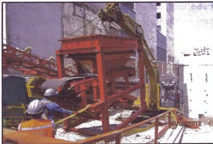
Figura 4.34. Instalación de la tolva de carga, obra "Edificio de Oficinas Reducto".
