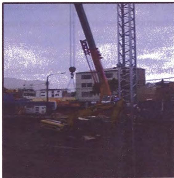
Figura 4.38. Procedimiento de Extracción de excavadora de llantas con una grúa móvil.
