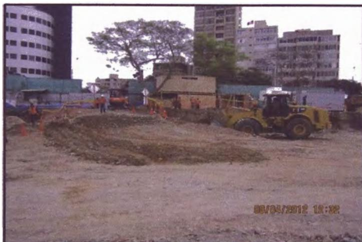
Figura 4.25. Cargador Frontal armando la rampa de acceso, obra "Edificio de Oficinas Pardo y Aliaga".
