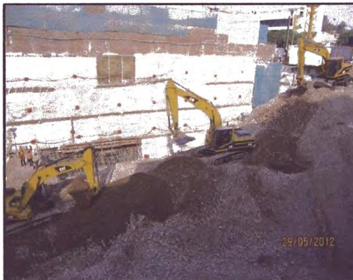
Figura 4.32. Vista de Corte y eliminación de rampa de acceso con tres excavadoras, obra "Edificio de Oficinas Clínica Internacional San Borja".
