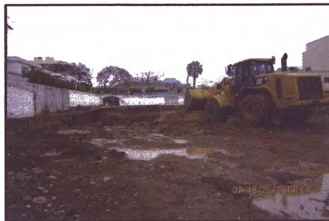
Figura 4.10. Fase de Maniobra de un cargador frontal Caterpillar 966H, obra “Edificio de Oficinas Pardo y Aliaga”.
