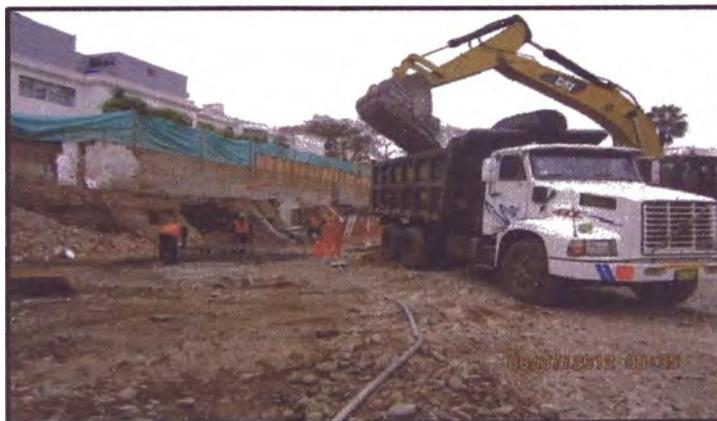
Figura 4.17. Fase C de una Excavadora Hidráulica sobre Cadenas Caterpillar 330D tipo retro, obra "Edificio de Oficinas Pardo y Aliaga".
