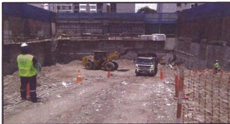
Figura 5.3. Eliminación con camiones volquete VOLVO FMX y Cargador Frontal CATERPILLAR 966H en la obra CENTRO EMPRESARIAL LABOK.
