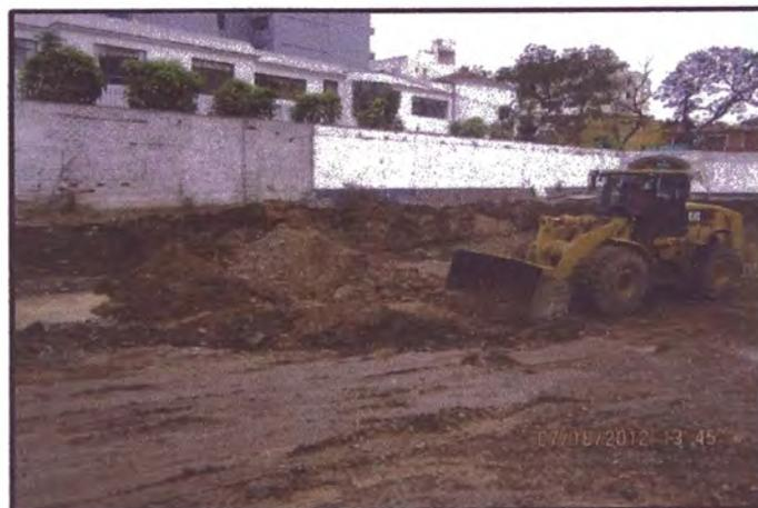
Figura 4.24. Cargador Frontal sobre llantas cortando el terreno para el primer sótano, obra "Edificio de Oficinas Pardo y Aliaga".
