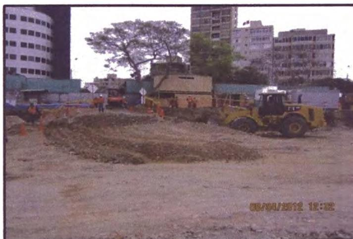
Figura 4.8. Fase de Acarreo de un cargador frontal Caterpillar 966H, obra “Edificio de Oficinas Pardo y Aliaga”.
