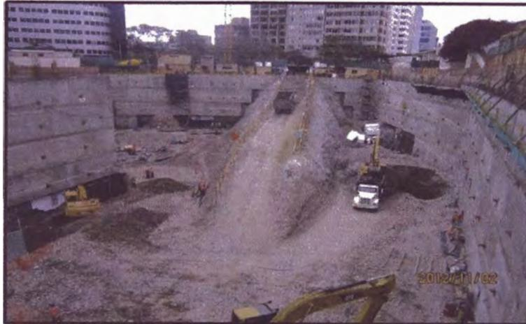
Figura 4.30. Sótanos excavados por el procedimiento de excavación por anillos, obra “Edificio de Oficinas Pardo y Aliaga”.
