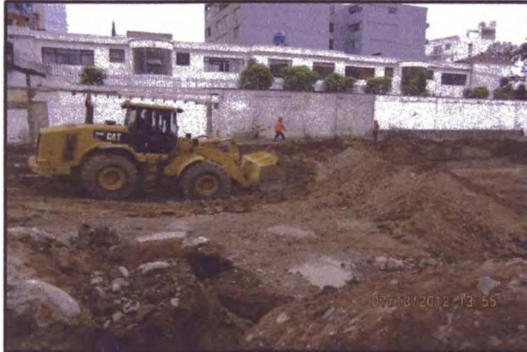
Figura 4.7. Fase de Carga de un cargador frontal Caterpillar 966H, obra “Edificio de Oficinas Pardo y Aliaga”.
