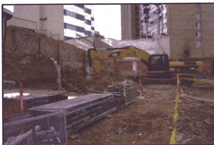
Figura 4.29. Corte de la banqueta para la construcción de muros anclados, obra "Edificio de Oficinas Pardo y Aliaga".
