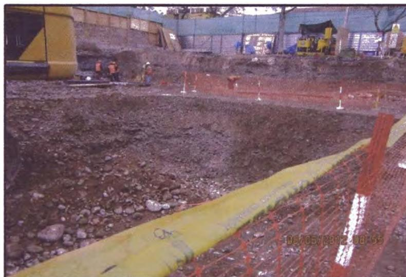
Figura 4.2. Cerco del área de trabajo de la excavadora, obra "Edificio de Oficinas Pardo y Aliaga".
