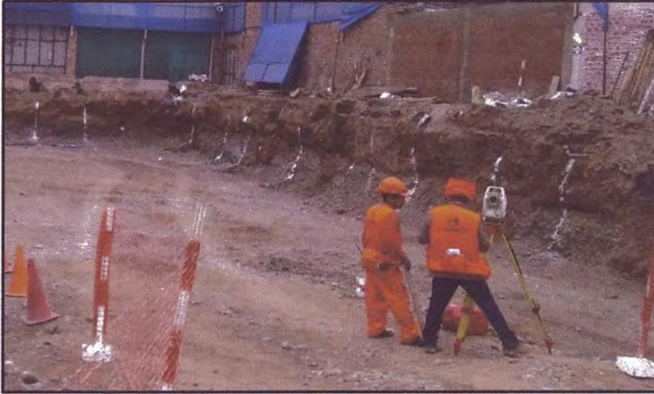
Figura 3.1. Verificación de niveles de planos de sótanos con estación total en la obra CENTRO EMPRESARIAL LABOK.
