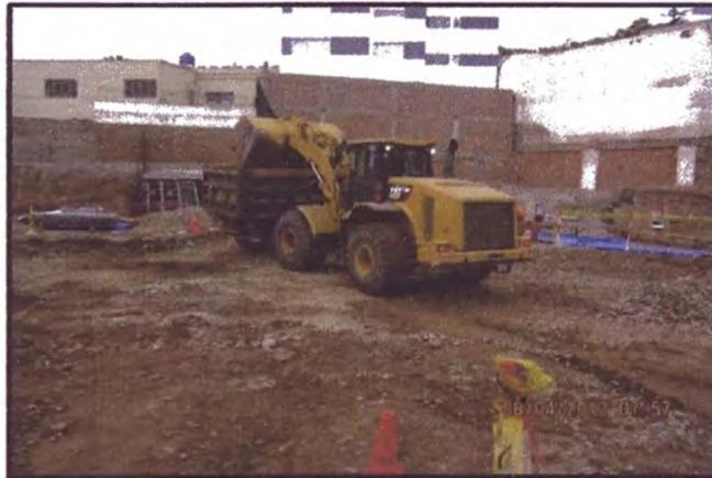
Figura 4.9. Fase de Descarga de un cargador frontal Caterpillar 966H, obra “Edificio de Oficinas Pardo y Aliaga”.
