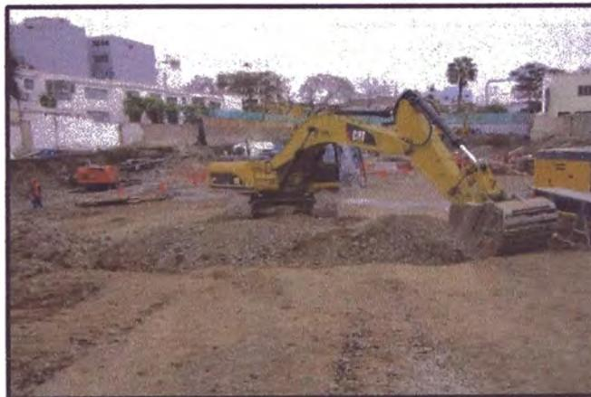
Figura 4.15. Fase A de una Excavadora Hidráulica sobre Cadenas Caterpillar 330D tipo retro, obra "Edificio de Oficinas Pardo y Aliaga".
