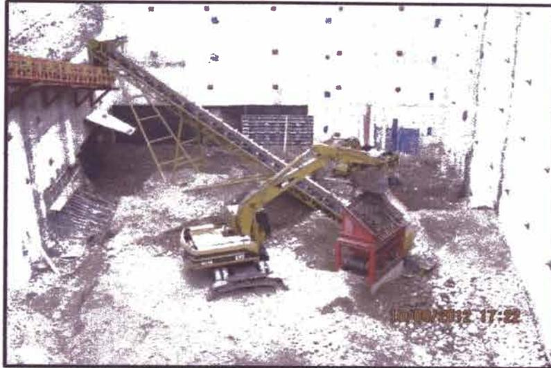
Figura 4.35. Operación de carga en la tolva de carga de la Faja Transportadora, obra “Edificio de Oficinas Reducto”.
