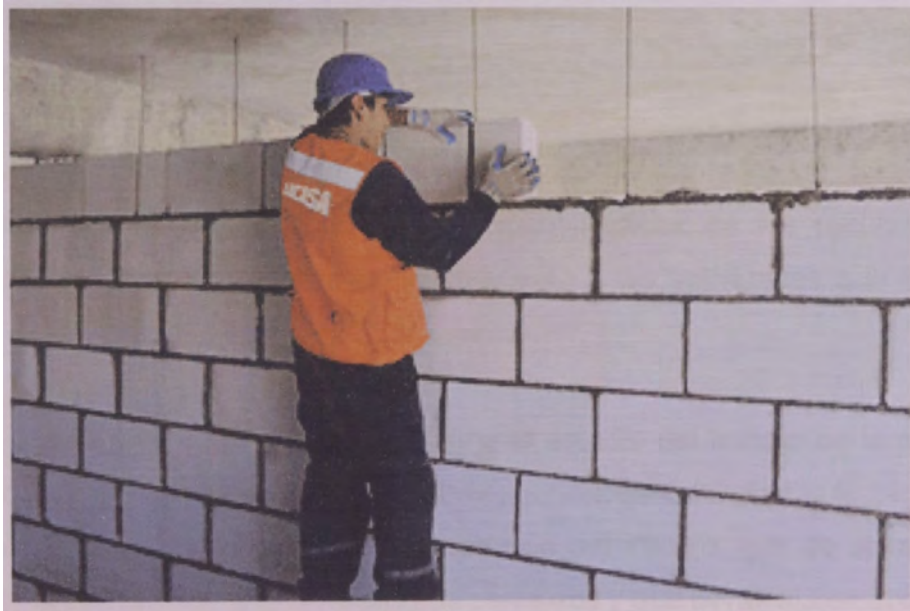
Figura 2.4. Armado de muros con placas sílico calcáreas (Fuente: www.mineraluren.com )
