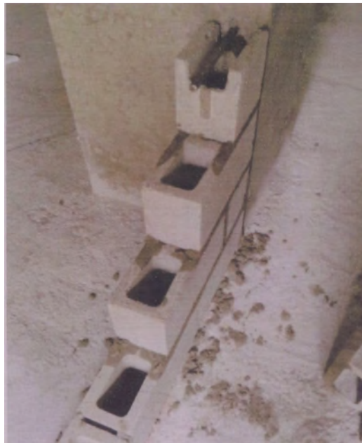
Figura 2.3: Proceso de asentamiento de bloquetas de concreto, obra de la Videna (Fuente: Elaboración propia)
