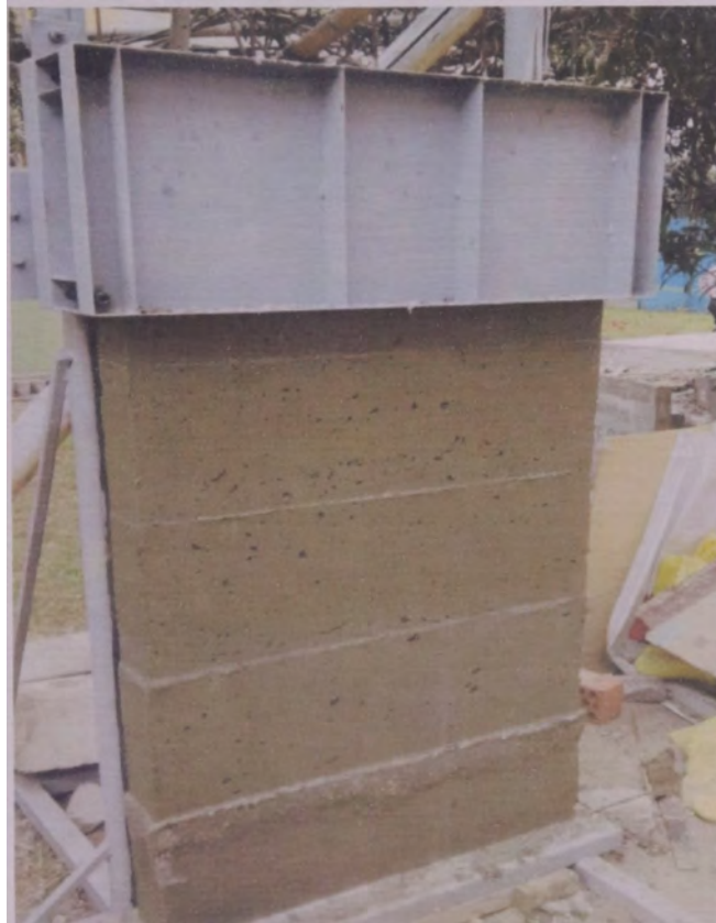
Figura 5.19: Proceso de desenformado del 5to vaciado
