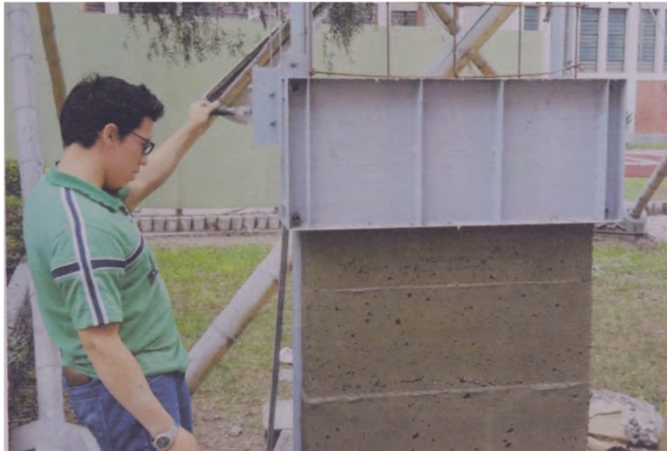
Figura 5.17: Proceso de desencofrado del 4to vaciado por elevación
