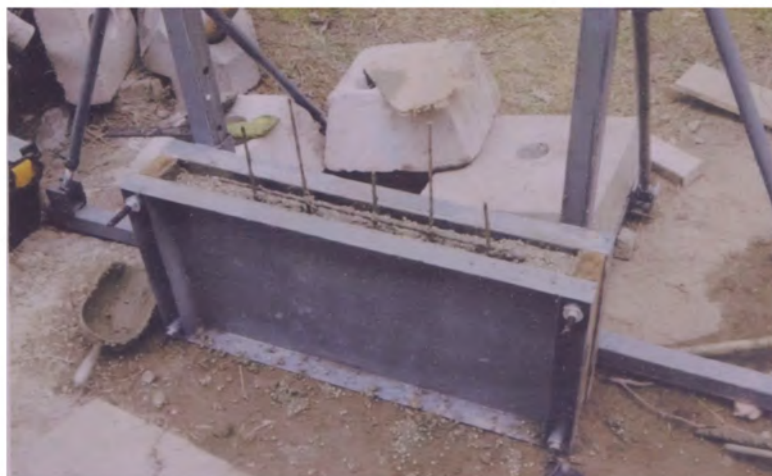
Figura 4.11: Concreto vaciado en el encofrado
