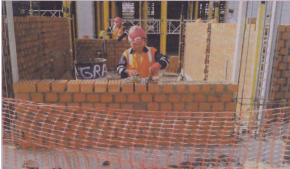
Figura 2.2: Asentado de ladrillos King Kong 18 huecos Fuente: Elaboración propia.
