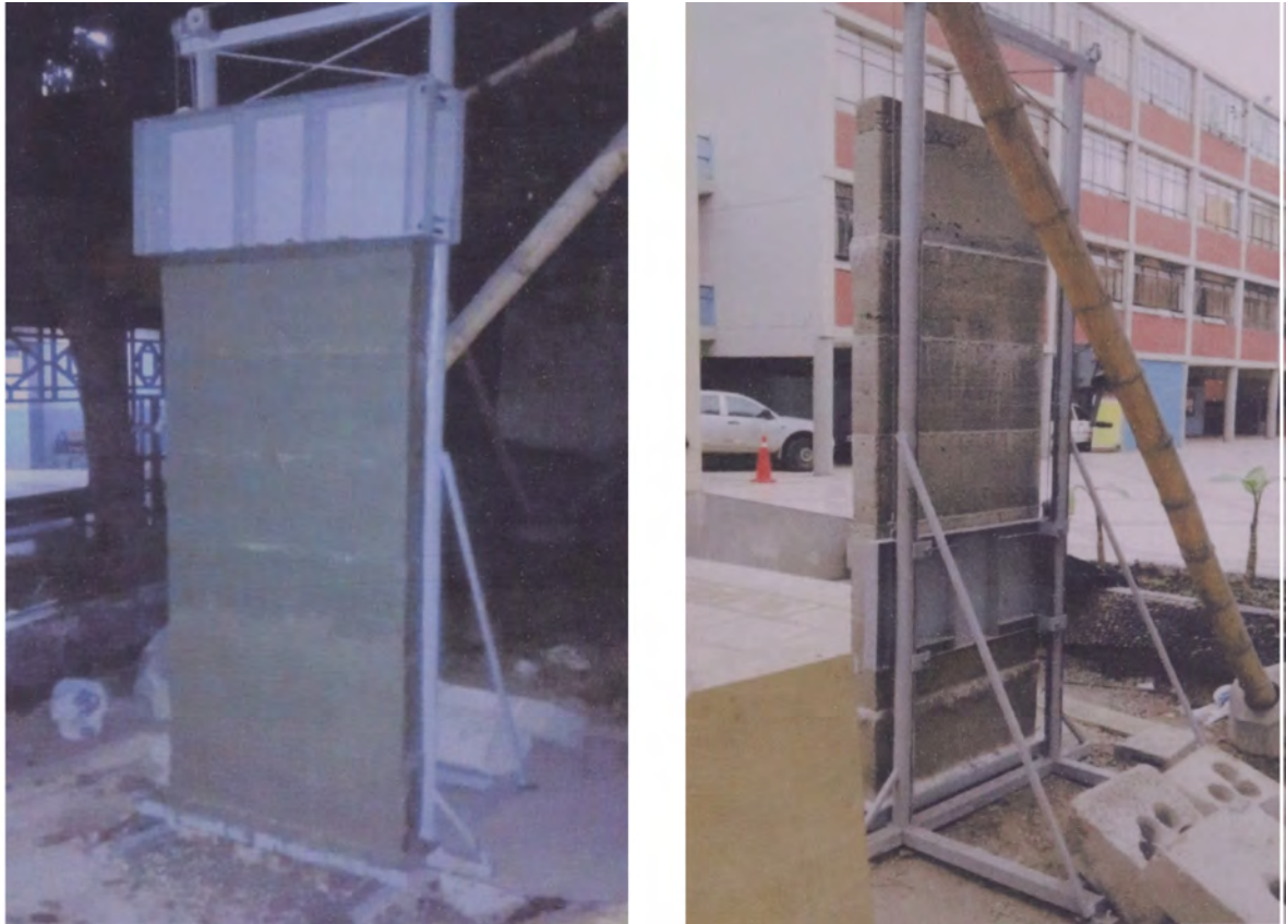
Figura 5.20: Procesos de vaciado y desencofrado del 7mo vaciado
