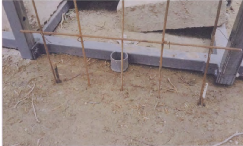
Figura 4.10: Vista de la malla de acero de refuerzo de 1/4"
