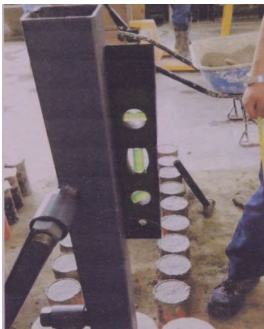
Figura 4.9: Nivelación y aplome del encofrado
