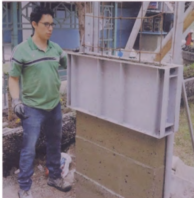
Figura 5.15: Desencofrado del 3er vaciado
