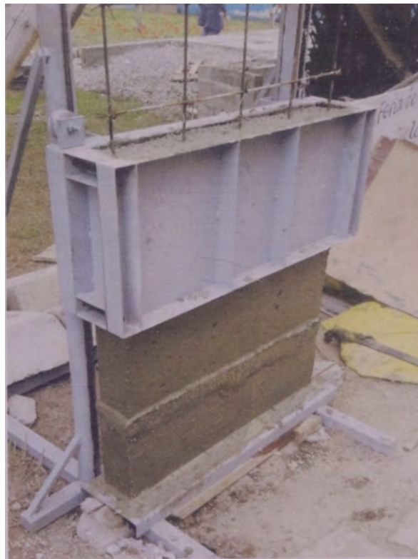
Figura 5.14: Término de 3er vaciado de muro
