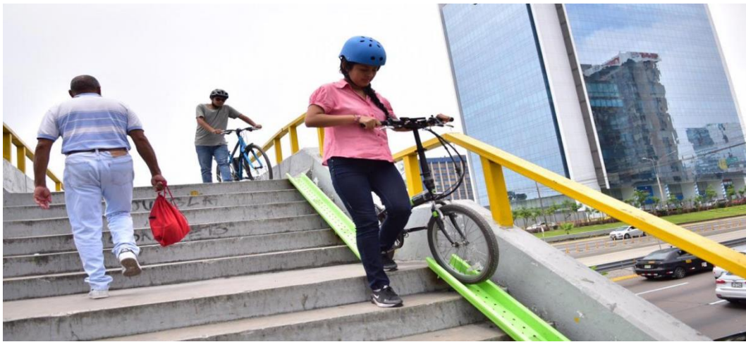
Figura N°38: Canaletas para bicicletas en una escalera en San Isidro, Lima (El comercio, 2018)
