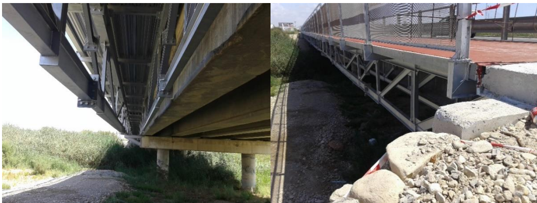
Figura N°39: Soluciones de ampliación de tablero de un puente para ofrecer espacio adicional a peatones y ciclistas (Foto Propia)
