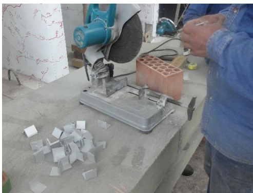
Figura N° 3.21 Habilitación de los ángulos de aluminio.
