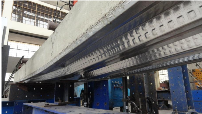
Figura A.10 Estado final de la placa colaborante (AD-730) después del ensayo a flexión.
