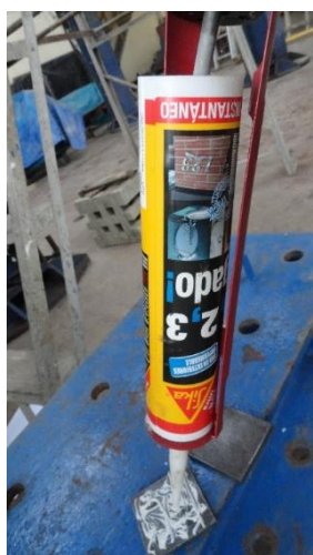
Figura N° 3.23 Aplicación del pegamento en la plancha metálica.
