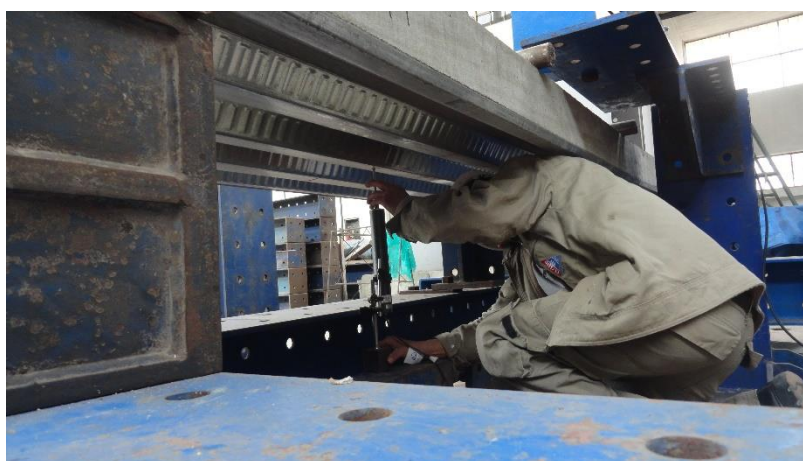
Figura A.8 Ubicación de los transductores para medir las deflexiones de la losa.
