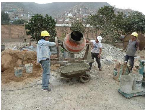
Figura N° 3.7 Preparación del concreto.
