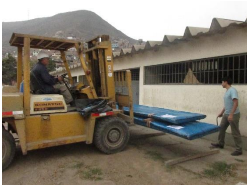
Figura N° 3.3 Almacenamiento de la placa colaborante.
