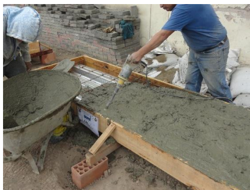
Figura N° 3.8 Vaciado del concreto.
