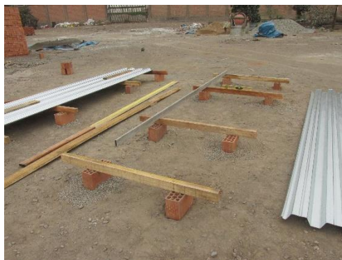
Figura N° 3.4 Nivelación de la superficie de terreno.
