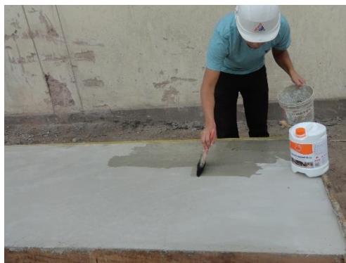
Figura N° 3.10 Aplicación de curador químico.
