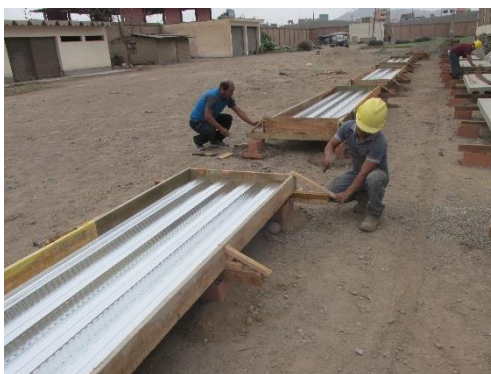
Figura N° 3.5 Encofrado lateral.
