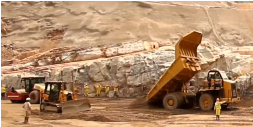
Figura N° 17 Vaciado de CCR (Nam Ngiep1 Power Company, 2016)
