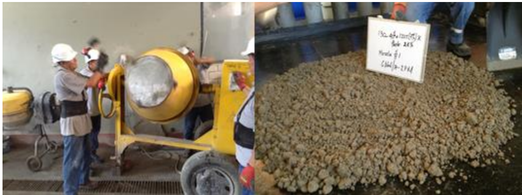
Figura N° 55 Proceso de mezclado y mezcla final de CCR (Fuente propia, 2018)
