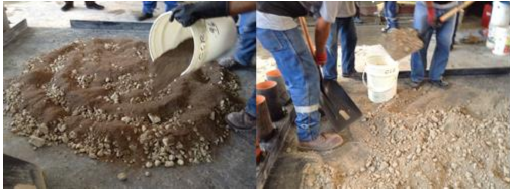
Figura N° 54 Proceso de mezclado de agregados CCR (Fuente propia, 2018)
