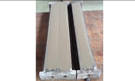
8-Acabado final con badilejo y dejar por 24h
