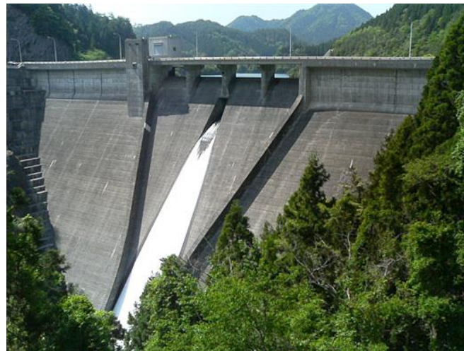
Figura Nº 23 Presa Shimajigawa (Fujii K., 2012)
