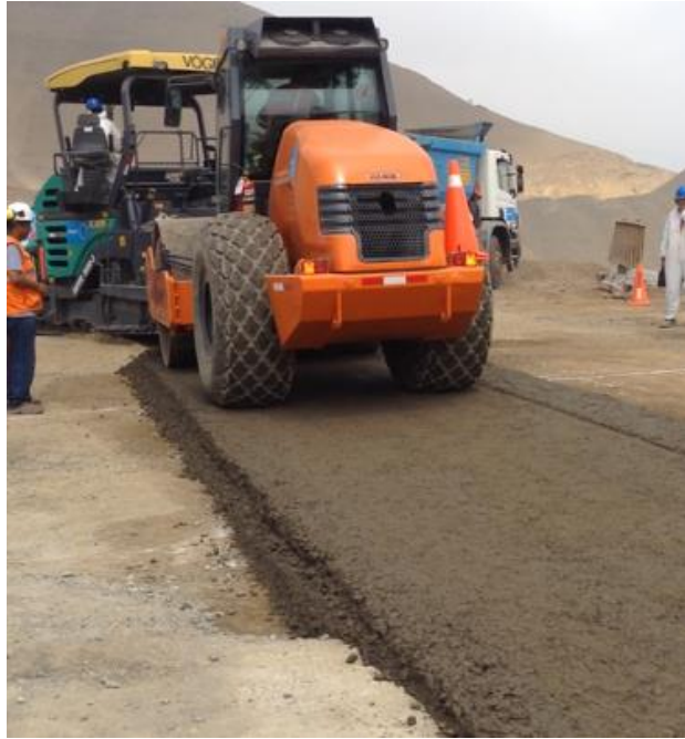
Figura Nº 19 Compactado del CCR (Fuente Propia, 2017)
