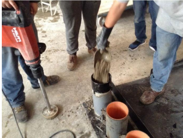
Figura N° 44 Ensayos previos de CCR (Fuente propia, 2018)
