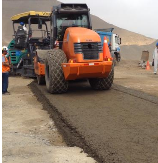
Figura Nº 12 Etapa de prueba de CCR (Fuente Propia, 2017)
