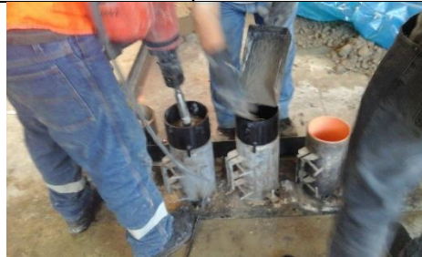
7-Colocar el collarín para la 3ra capa. Llenar y compactar
