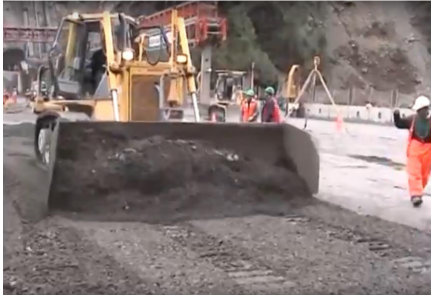
Figura N° 18 Extendido del CCR (Rotec, 2017)
