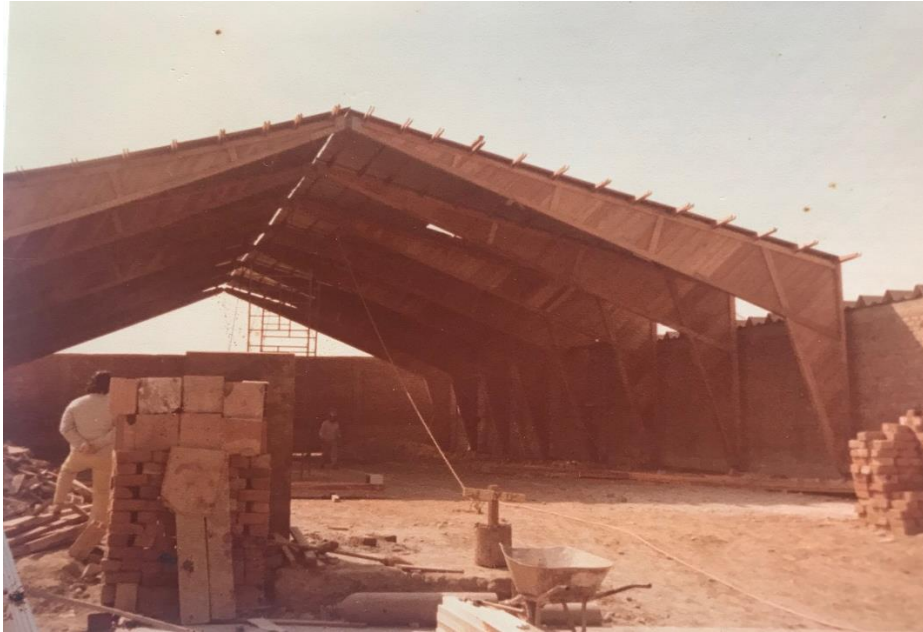
Figura 2.4 Pórticos triarticulados de madera laminada.
