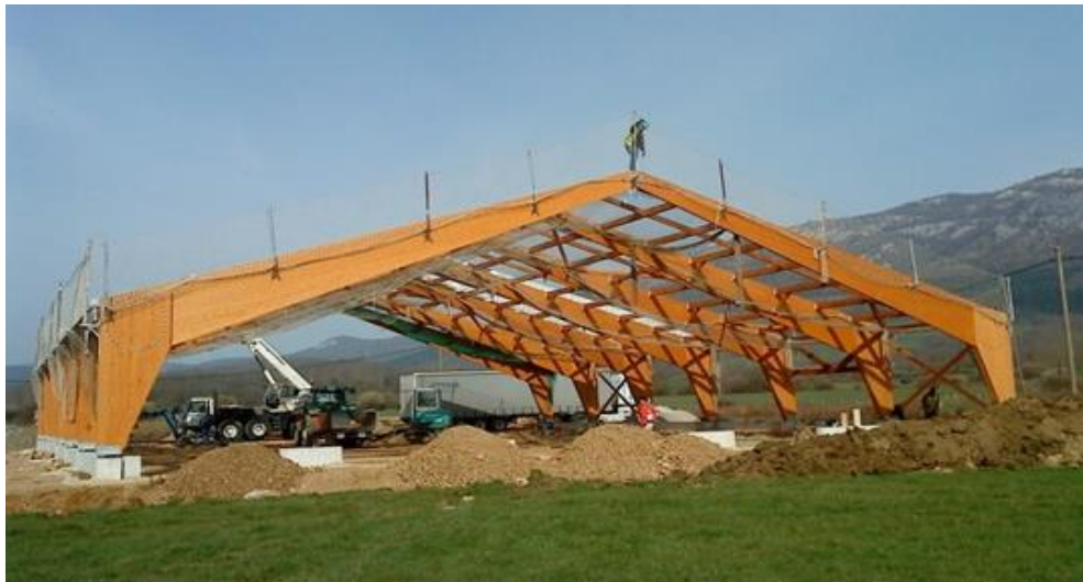
Figura 2.3 Ejemplo de la construcción de una nave industrial.
