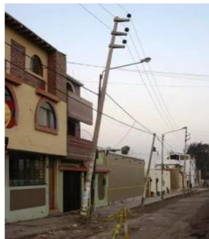
Figura N° 78 Alumbrado público luego del sismo en Pisco el 15 de agosto de 2007
