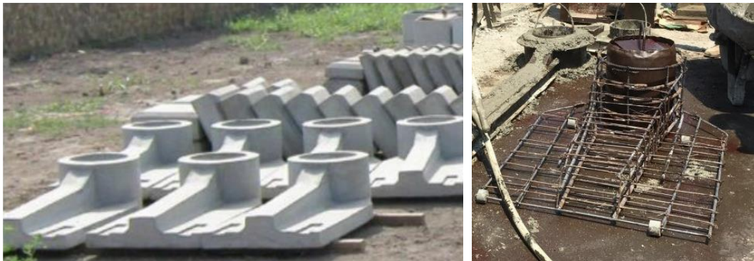
Figura N° 43 Plataforma de concreto armado y estructuración de la armadura de acero de refuerzo
