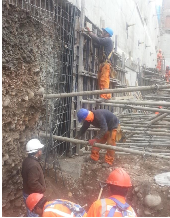
Figura N° 78. Trabajos mejorados II.
