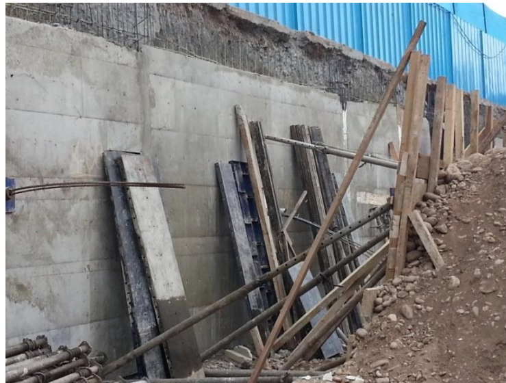
Figura N° 79. Trabajos mejorados III.
