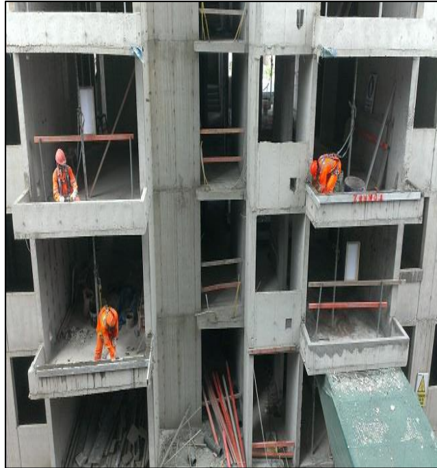
Figura N° 39. Proceso de construcción de la obra.
