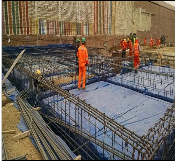
Figura N° 58. Estructura del edificio.
