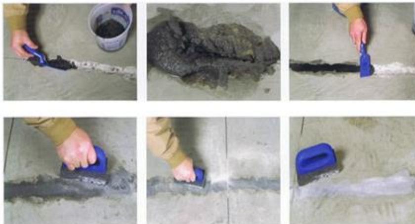
Figura N° 6. Proceso de reparación de fisura.
