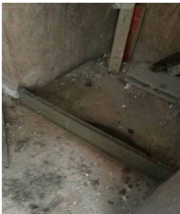
Figura N° 70. Construcción de los baños Fuente. Archivo de la empresa constructora
