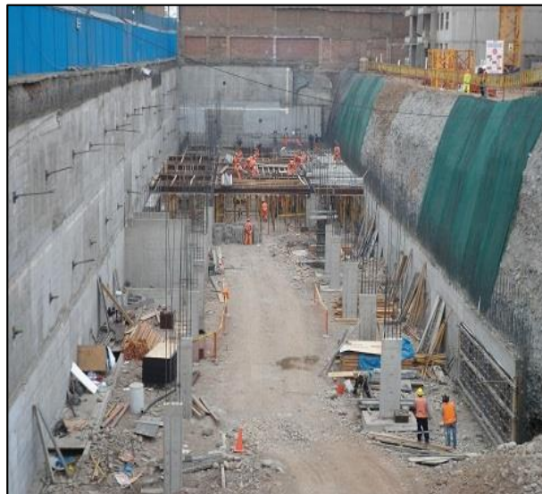
Figura N° 41. Cimentación del edificio.
