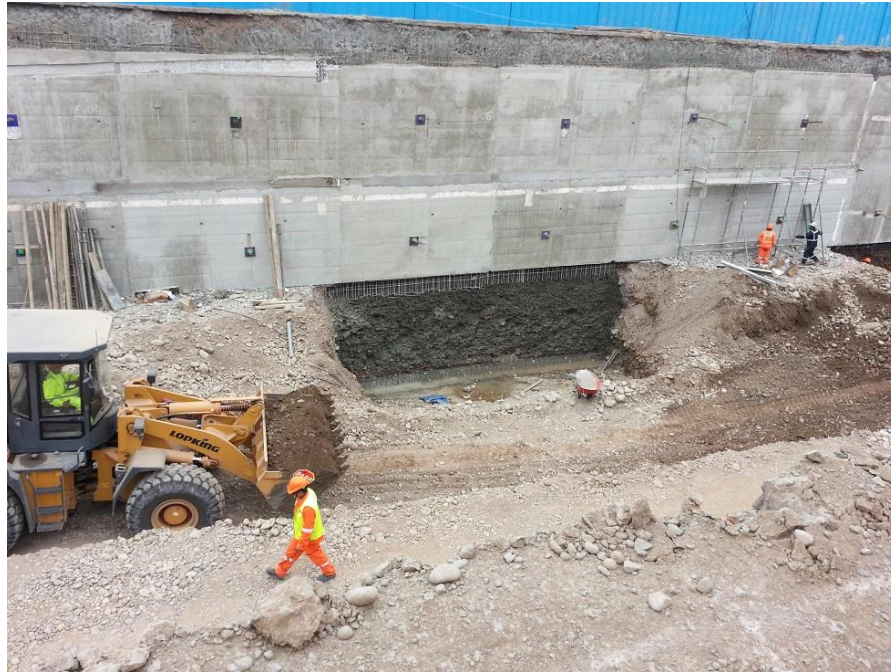
Figura N° 80. Trabajos mejorados IV.
