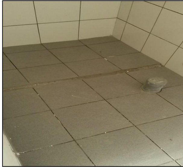
Figura N° 40. Enchapado de losas (revestimiento).
