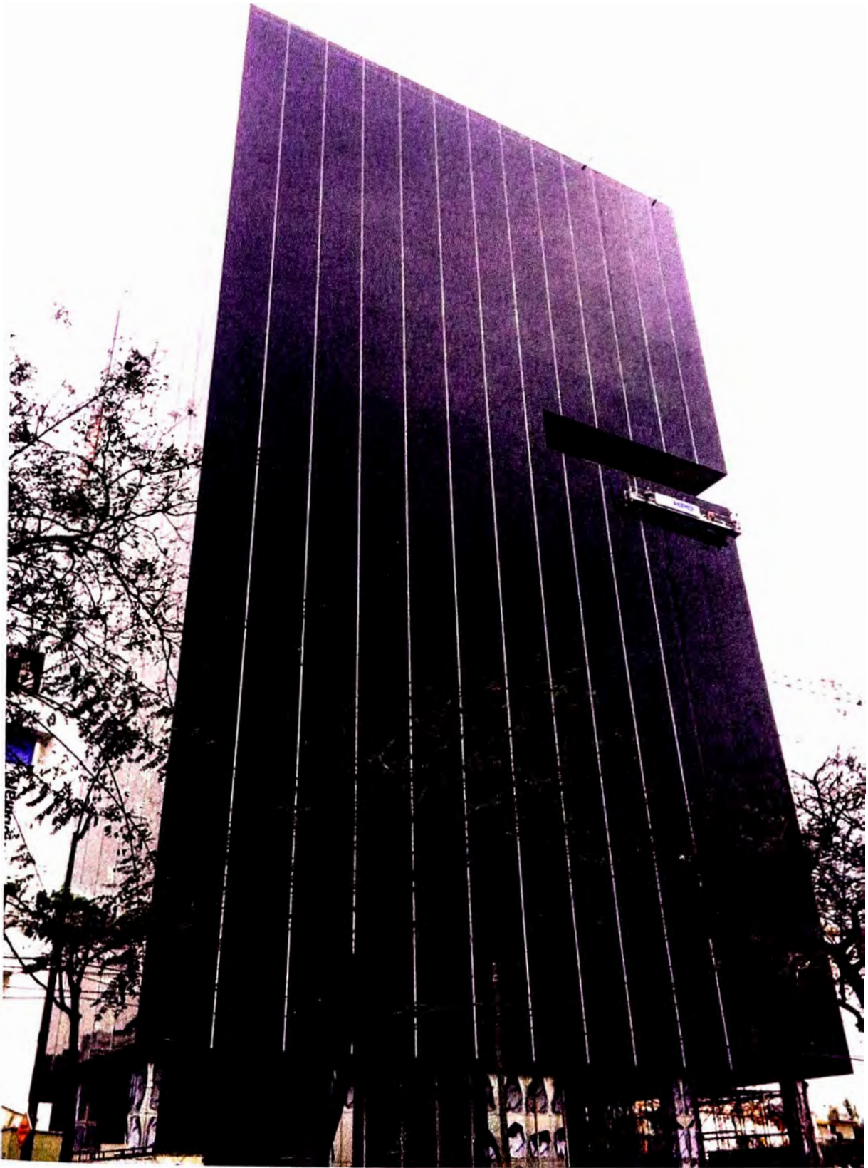
VISTA EXTERIOR DESDE AV. JAVIER PRADO
