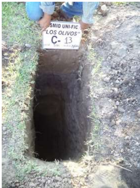
FOTO 26: En la calicata C-13, de 0.00 a 0.50 m se tiene terreno de cultivo; de 0.50 a 1.70 m arcilla delgada con arena (CL); de 1.70 a 2.50 m arena mal gradada (SP); de 2.50 a 3.00 m arcilla limosa (CL-ML).
