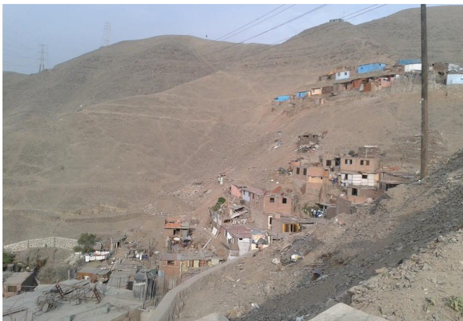
Figura N° 2.1. Laderas en el Cerco de los Olivos con posibilidad de que se puedan producirse desplomes de los bloques de rocas sueltas por las laderas debido a incrementos inusuales de lluvias o de actividad sísmica. Fuente: Propia.
