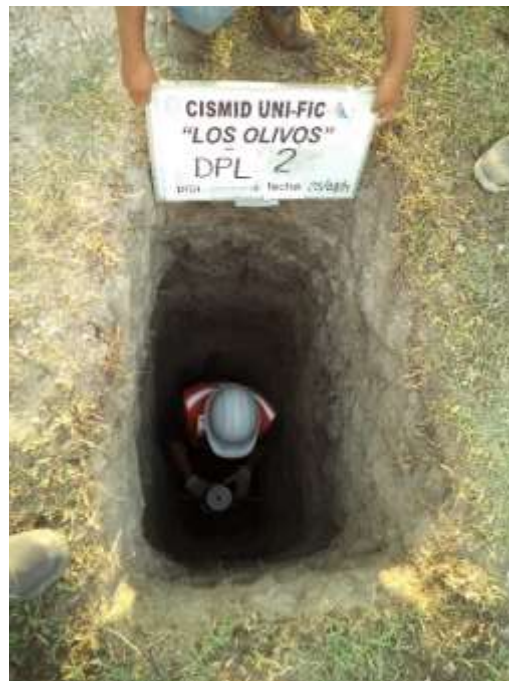
FOTO 40: Ensayo DPL-02, ubicado en la calicata C-18, coordenada UTM: 273134.00 m E y 8674574.00 m N.
