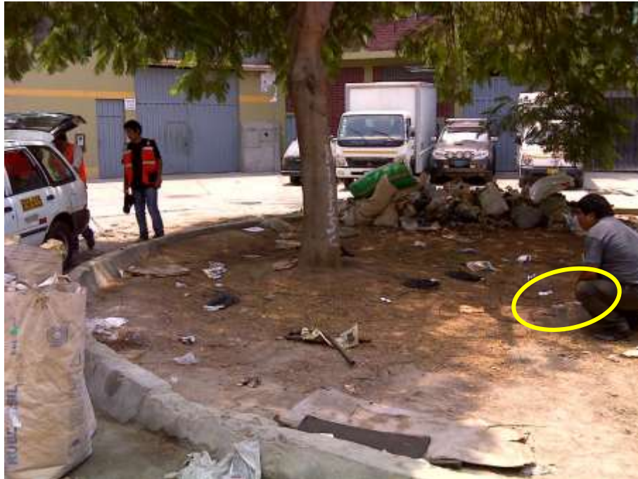
FOTO 59: M-19. Se observan la conexión y configuración para la ejecución del ensayo de microtremores.
