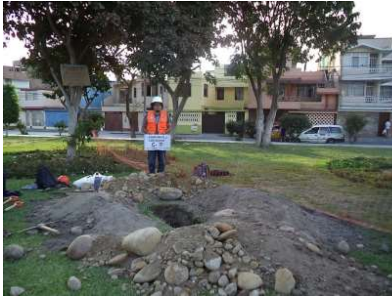
FOTO 5: Calicata C-03, ubicada en el parque Los Gemelos, coordenada UTM: 274490.37 m E y 8673261.24 m N.
