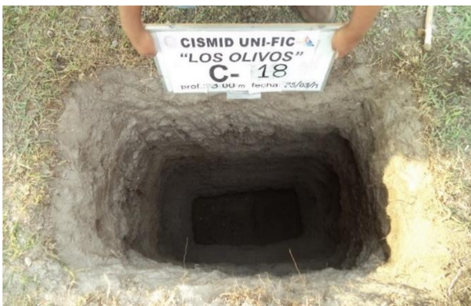
Figura N° 4.1. Ejecución de calicata C-18 de 3.0 m. en el área de investigación.
