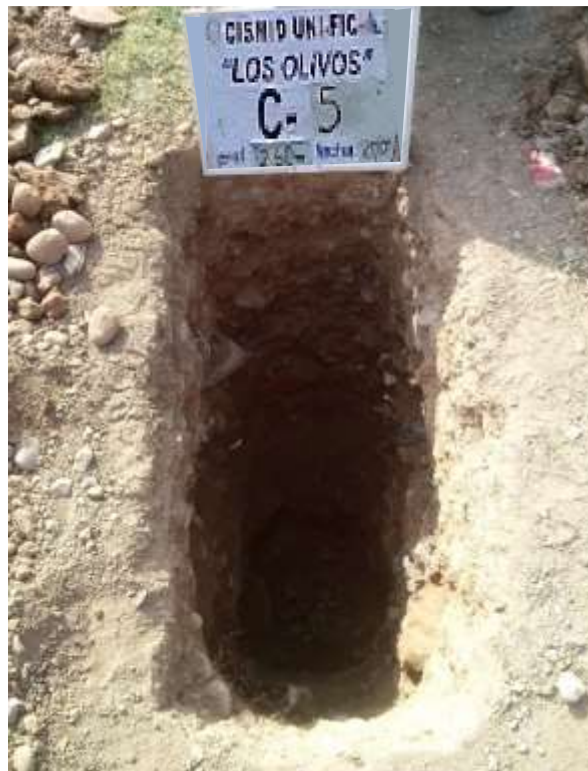
FOTO 10: En la calicata C-05, de 0.00 a 0.30 m se tiene relleno; de 0.30 a 2.60 m grava bien gradada (GW).
