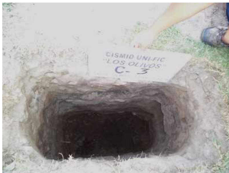
FOTO 6: En la calicata C-03, de 0.00 a 0.30 m se tiene terreno de cultivo; de 0.30 a 1.00 m arcilla delgada (CL); de 1.00 a 1.60 m arena limosa (SM); de 1.60 a 3.00 m grava mal gradada con arena (GP).
