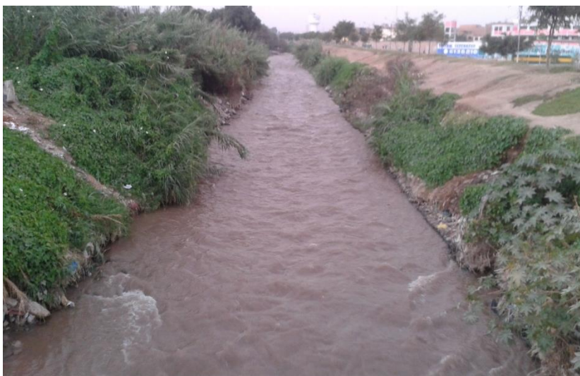
Figura N° 2.2. Riberas de un tramo del Río Chillón al noreste del distrito de los Olivos con posibilidad de ser inundadas y erosionadas por incremento excepcional del caudal. Fuente: Propia.
