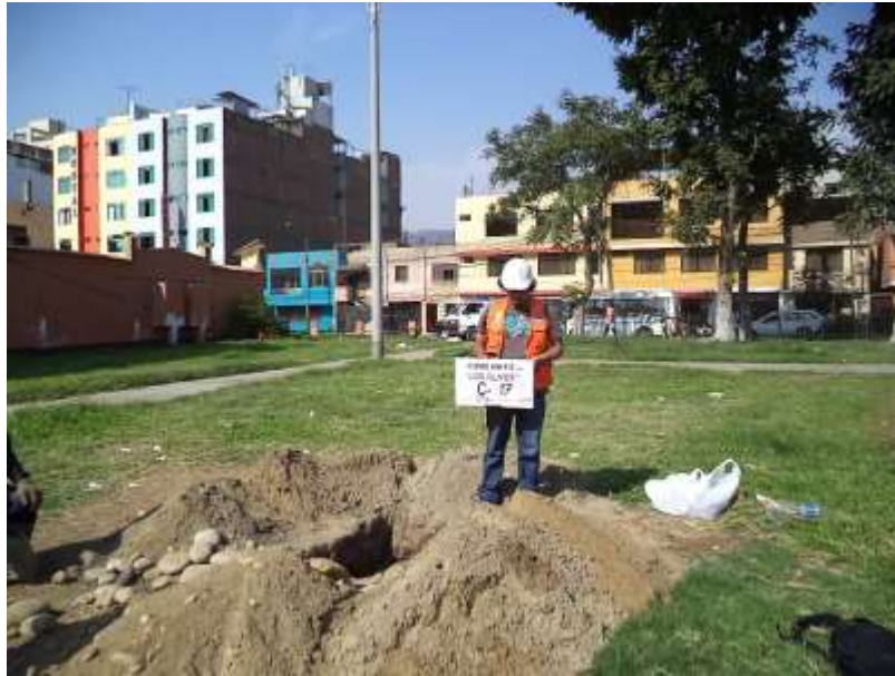
FOTO 33: Calicata C-17, ubicada en parque frente al Jr. Carlos A. Salaverry, coordenada UTM: 275160.79 m E y 8673270.14 m N.
