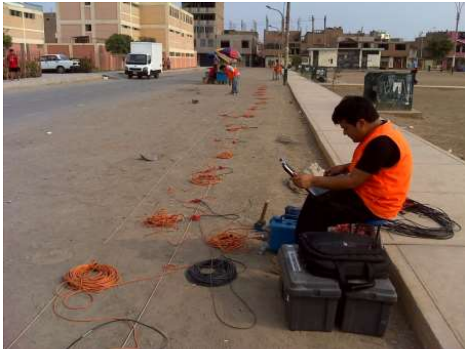
FOTO 105: LS-04. Se observa el arreglo lineal de geófonos y su conexión con el adquisidor de señales, previo a la ejecución del ensayo de refracción sísmica.
