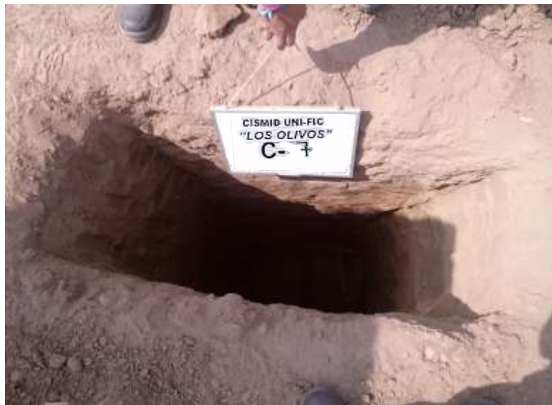
FOTO 14: En la calicata C-07, de 0.00 a 0.30 m se tiene relleno; de 0.30 a 1.00 m limo con arena (ML); de 1.00 a 1.20 m arcilla delgada (CL); de 1.20 a 3.00 m arcilla gruesa (CH).
