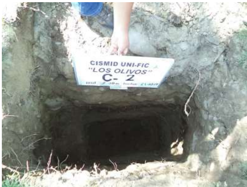
FOTO 4: En la calicata C-02, de 0.00 a 1.00 m se tiene relleno; de 1.00 a 2.10 m arena limosa (SM); de 2.10 a 3.00 m grava mal gradada con arena (GP).
