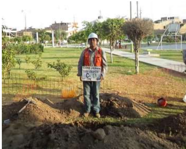
FOTO 25: Calicata C-13, ubicada en el parque Piscobamba, coordenada UTM: 272883.00 m E y 8675478.00 m N.
