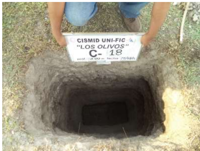
FOTO 36: En la calicata C-18, de 0.00 a 0.90 m se tiene terreno de cultivo; de 0.90 a 1.60 m limo elástico (MH); de 1.60 a 2.30 m limo (ML); de 2.30 a 3.00 m arcilla delgada (CL).
