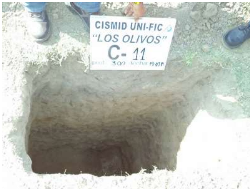
FOTO 22: En la calicata C-11, de 0.00 a 0.60 m se tiene terreno de cultivo; de 0.60 a 2.10 m limo arenoso (ML); de 2.10 a 3.00 m grava limosa con arena (GM).
