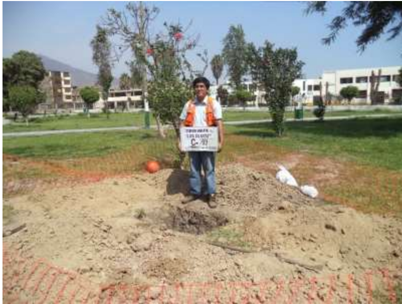
FOTO 37: Calicata C-19, ubicada en el parque Solidaridad, coordenada UTM: 274746.00 m E y 8674897.00 m N.
