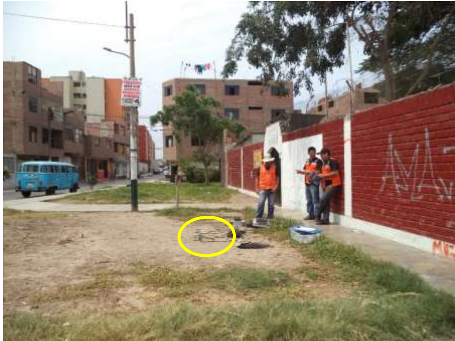
FOTO 69: M-29. Se observan los sensores conectados al adquisidor de señales y el instante del registro de microtremores en el AA.HH. 6 de Noviembre.
