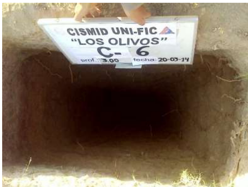
FOTO 12: En la calicata C-06, de 0.00 a 0.40 m se tiene terreno de cultivo; de 0.40 a 1.50 m limo con arena (ML); de 1.50 a 3.00 m arcilla delgada (CL).
