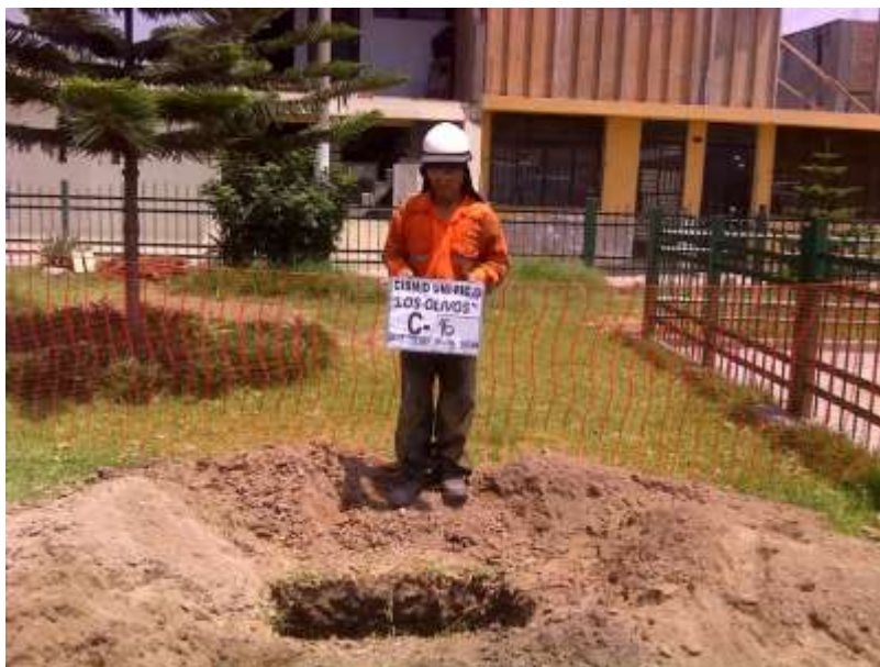
FOTO 31: Calicata C-16, ubicada en parque frente a la calle Margaritas, coordenada UTM: 274023.24 m E y 8674306.25 m N.
