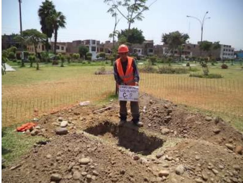
FOTO 17: Calicata C-09, ubicada en parque cerca de la Av. Confraternidad, coordenada UTM: 273925.12 m E y 8678521.09 m N.
