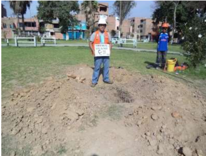
FOTO 21: Calicata C-11, ubicada en el parque 3 de Prolima, coordenada UTM: 274039.00 m E y 8680690.00 m N.
