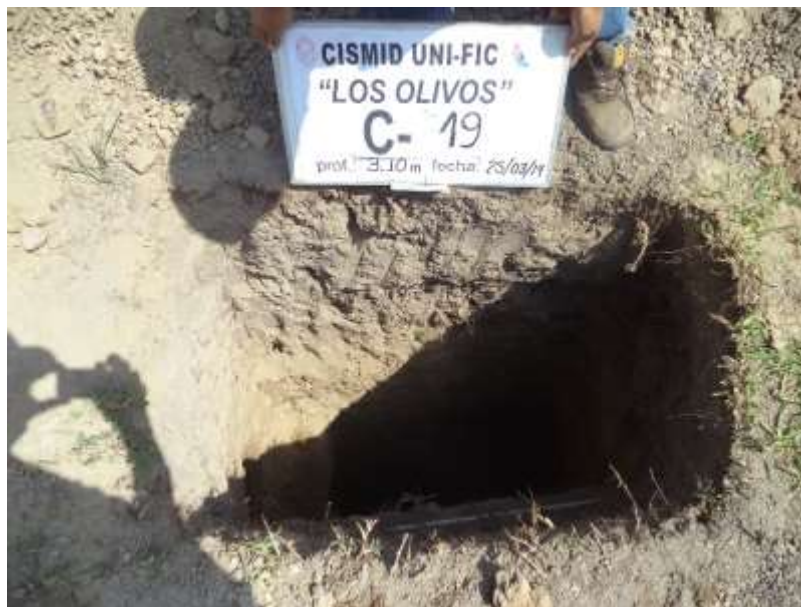
FOTO 38: En la calicata C-19, de 0.00 a 0.70 m se tiene terreno de cultivo; de 0.70 a 1.40 m arcilla (CL); de 1.40 a 1.80 m arena (SM); de 1.80 a 2.90 m arcilla delgada (CL); de 2.90 a 3.10 m arena limosa (SM).
