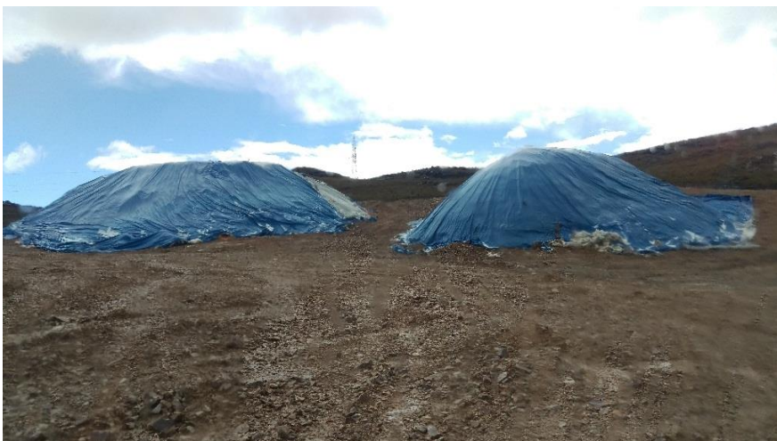
Foto Nº 2: Vista del acopio # 2 y 3 del suelo de baja permeabilidad.
