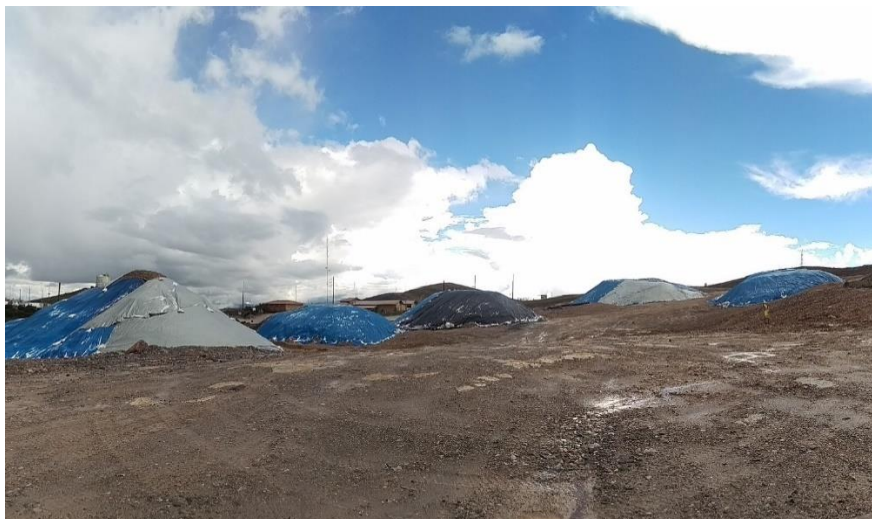
Foto Nº 1: Vista general de los acopios del suelo de baja permeabilidad.
