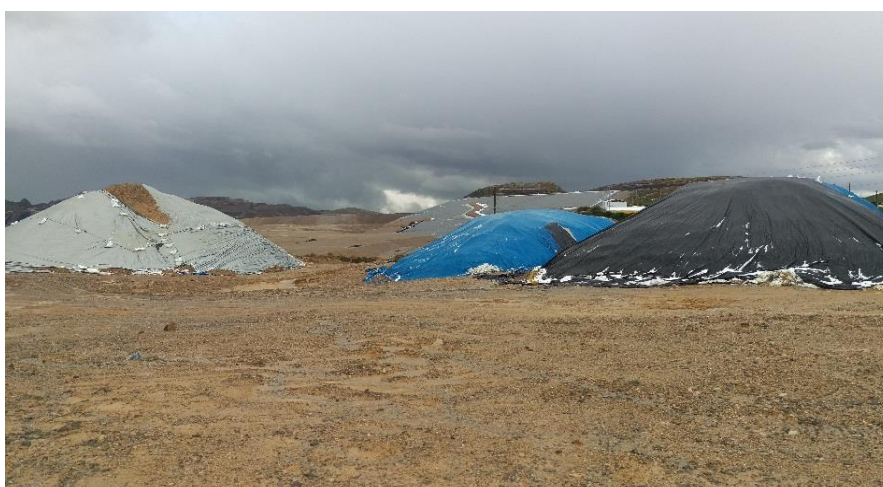
Foto Nº 3: Vista del acopio # 4, 5 y 6 del suelo de baja permeabilidad
