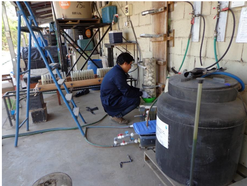
Foto N° 60: Desmontaje del Módulo 03
