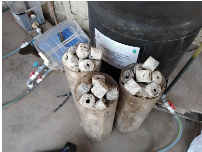
Foto N° 61: Desmontaje de los Módulos 01, 02 y 03
