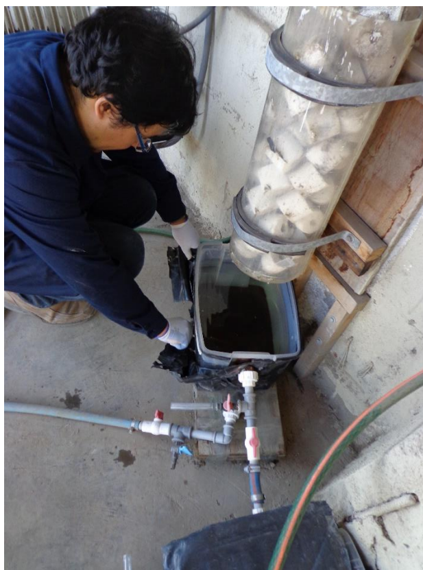
Foto N° 59: Desmontaje del Sedimentador 01
