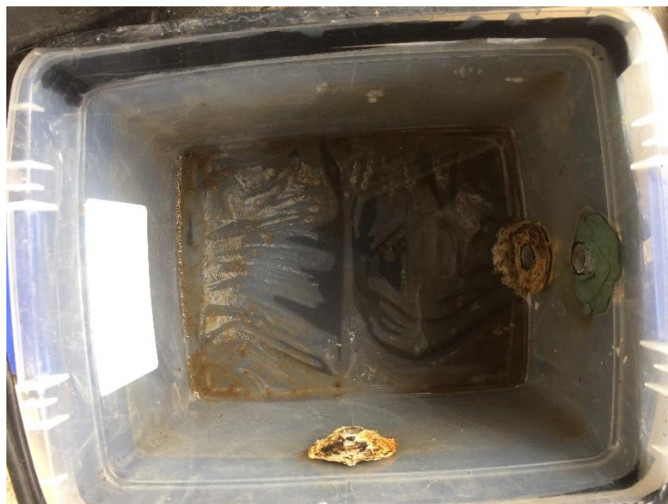
Foto N° 56: Lodo adherido a las paredes internas del Sedimentador 02
