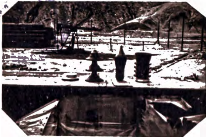
Conjunto de tapones para cementación múltiple intermitente.
