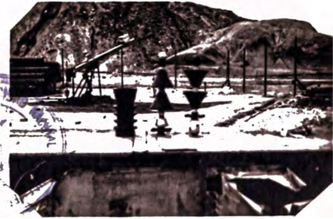
Conjunto de tapones para cementación múltiple continua.
