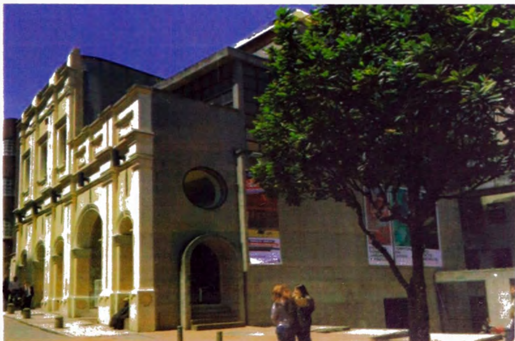
FOTO: Vista desde la esquina de la Av. Jiménez con Carrera 5. FUENTE: Plataforma arquitectura
