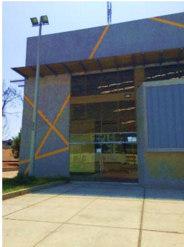
Ilustración 31: Vista interior de la I. E. San Juan de Trujillo.
