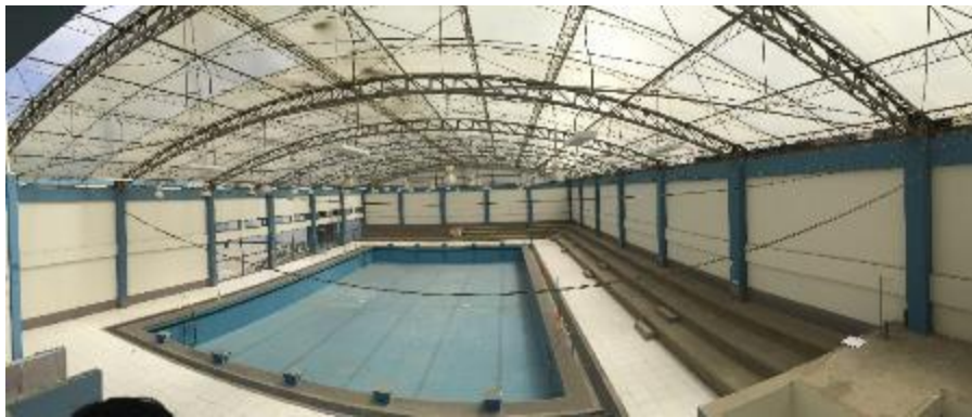
Ilustración 22: Vista interior de la piscina temperada de la I. E. Bartolomé Herrera.
