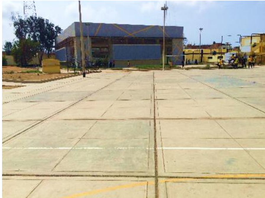
Ilustración 30: Vista interior de la I. E. San Juan de Trujillo.
