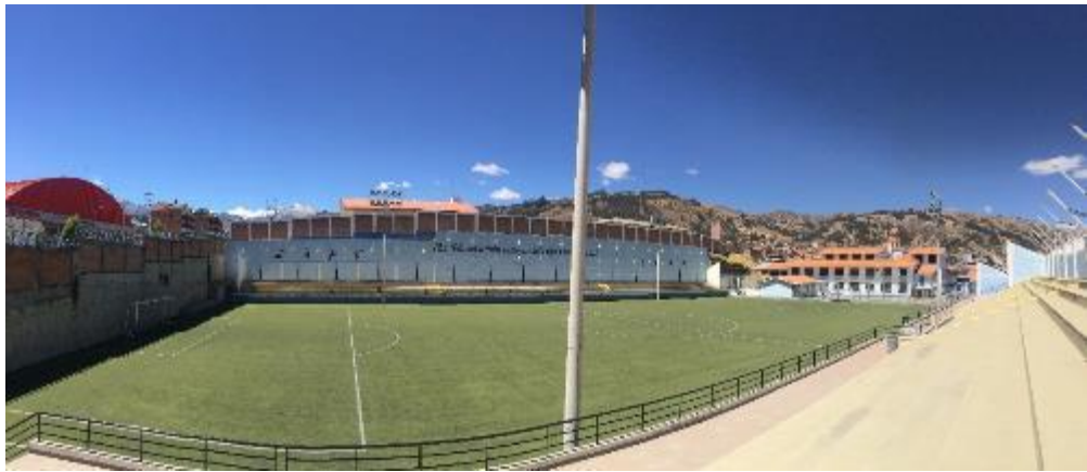
Ilustración 38: Vista interior del estadio de la I. E. La Libertad - Huaraz.
