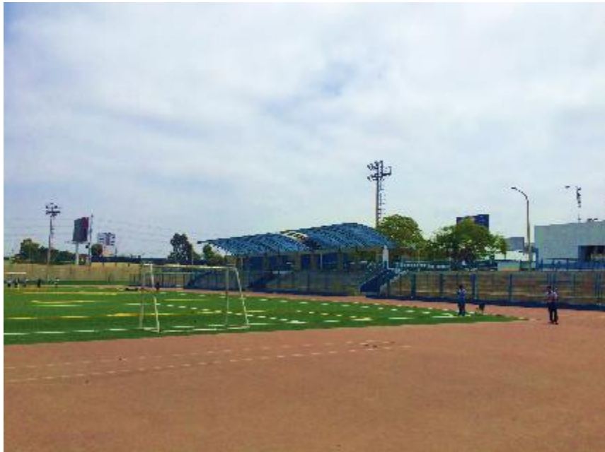
Ilustración 25: Vista interior del campo deportivo de la I. E. Bartolomé Herrera.
