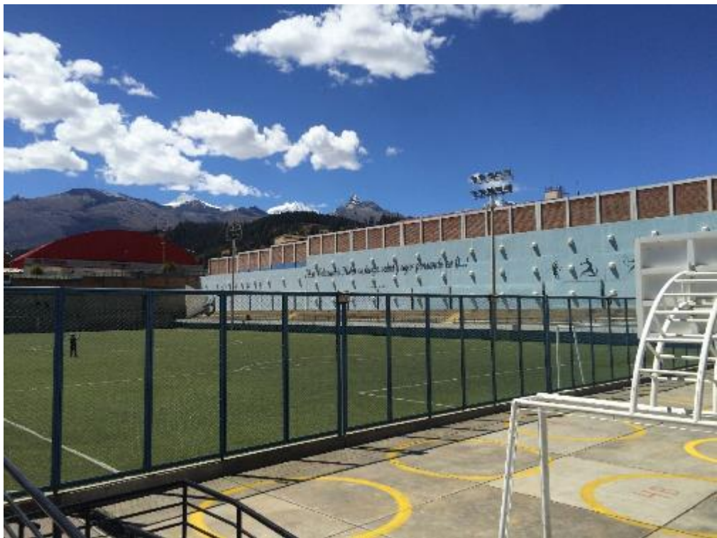
Ilustración 39: Vista interior del estadio de la I. E. La Libertad - Huaraz.
