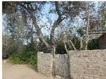
MUROS DE ADOBE, ALTURA 2.00 MT. ESPESOR 0.20 MT.
