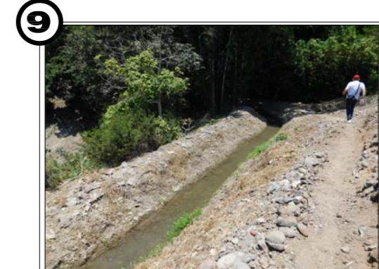
9 CAMINOS DE REGANTES Camino en elevación con respecto a la acequia el Alto. Accesos bien tratados para uso público.
