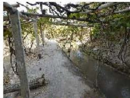
COLUMNETAS DE CONCRETO ARMADO QUE SUJETAN EL ENTRAMADO DE CAÑA.
