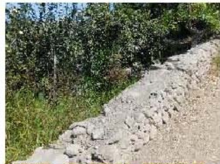
CERCOS DE PIEDRA REDONDAS DE RIO CON PIEDRAS IRREGULARES. ALTURA 0.40 MT.
