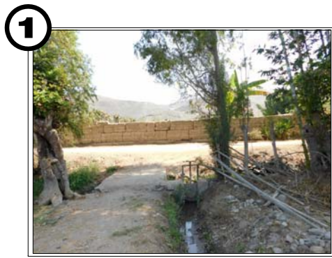
1 CAMINOS DE REGANTES Cruce de caminos, trocha carrózable entrega un puente de concreto para acceder a un camino privado de regantes. Nótese la derivación de la acequia El Alto al interior de la parcela por la bocatoma metálica.
