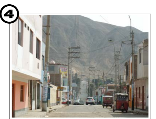
4 Paisaje urbano de la av. 3 de Mayo, un trayecto secundario del pueblo, es de sección de pista de 2 carriles con aceras respectivas y fachadas a plomo, como se aprecia hay un pronunciado desnivel que va de 85.0 msnm., donde está el auto a 104.7 msnm., lo que aprecia al fondo de la foto, camino a la salida a San Andrés.
