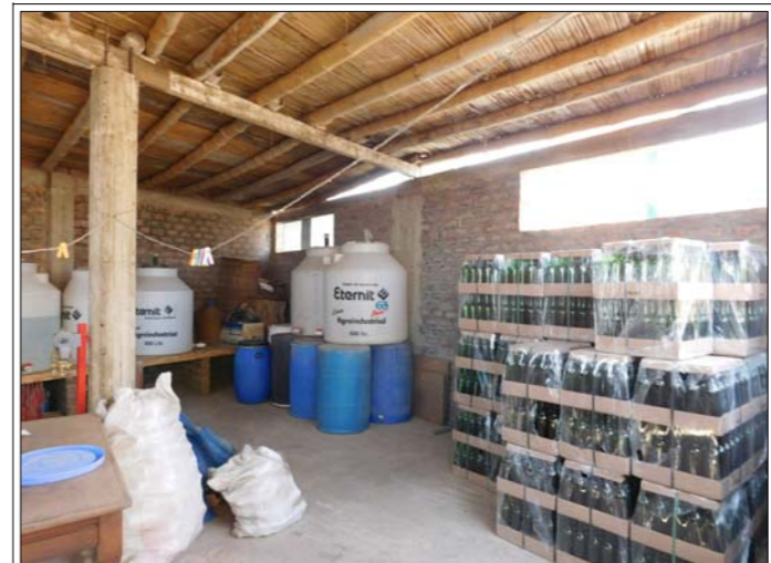
REPOSO Recipientes de polietileno en 2do nivel con techo de caña y torta de barro.
