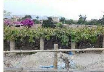
COLUMNETAS DE ADOBE DE SECCIÓN DE 0.50 MT. ALTURA 1.80 MT.
