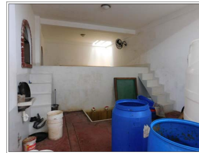
LAGAR Poza para depositar la uva. Acabado de pintura esmalte y encuentros boleados.
