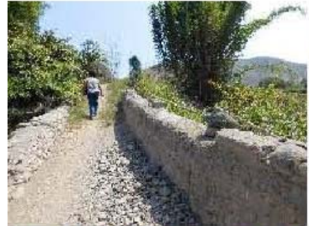
CERCO DE TAPIAL, ALTURA 0.90 MT. ESPESOR 0.40 MT.
