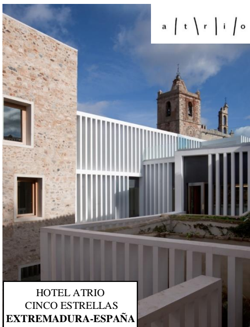
Figura 34. Hotel Atrio Vista 1 (Fuente: Tomada de Google imágenes)
