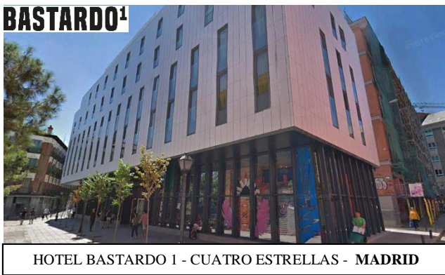
Figura 37. Hotel Bastardo 1 Vista 1 (Fuente: Tomada de Google Earth)
