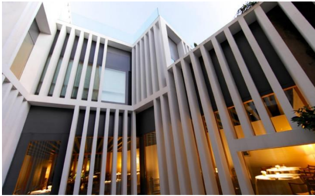
Figura 36. Hotel Atrio Vista 3 (Fuente: Tomada de Google imágenes)
