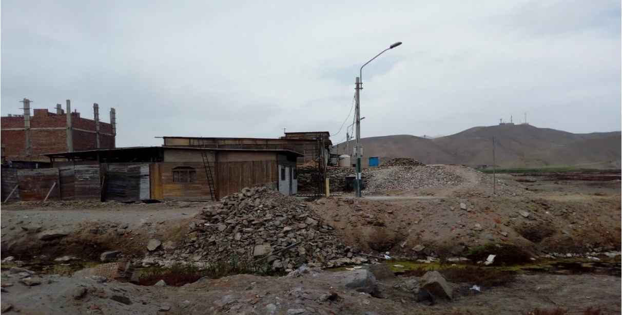
Figura 6: Desmonte en los límites del ACR Humedales de Ventanilla
