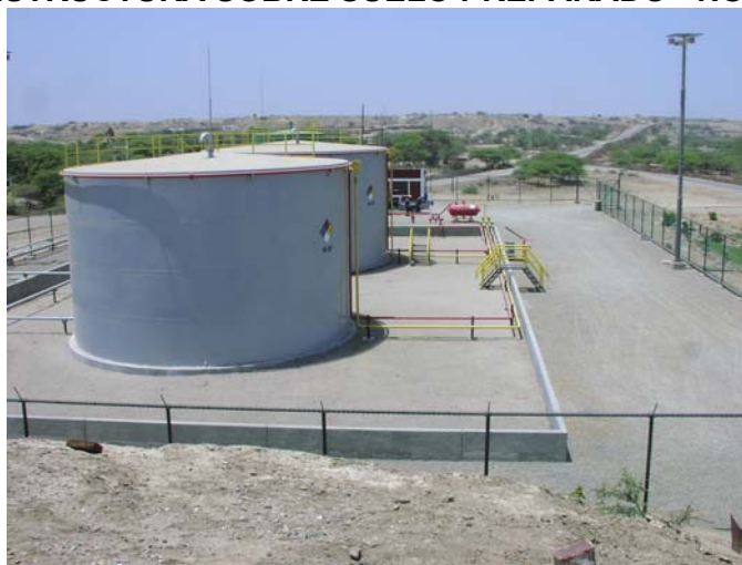
FIGURA I-3 INFRAESTRUCTURA SOBRE SUELO PREPARADO - NOROESTE
