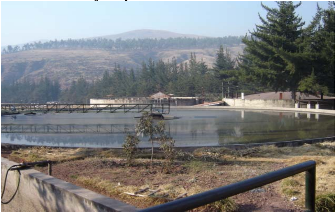
Foto 5 PTAR: sedimentador primario
