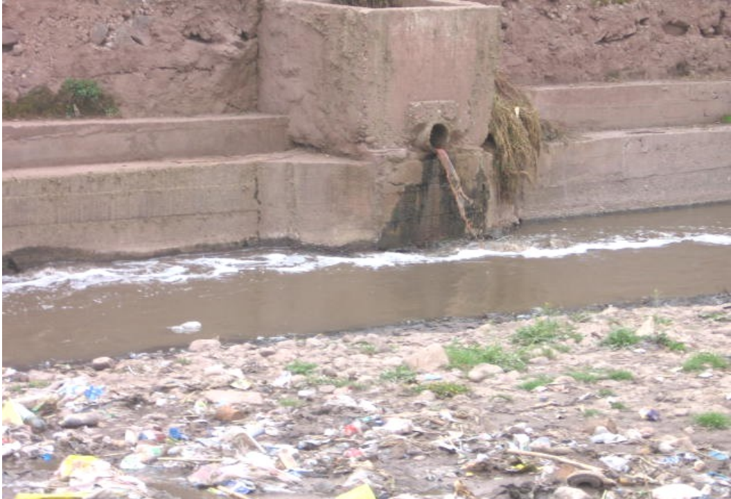
Foto 1 Arrojo de los desagües al río Huatanay
