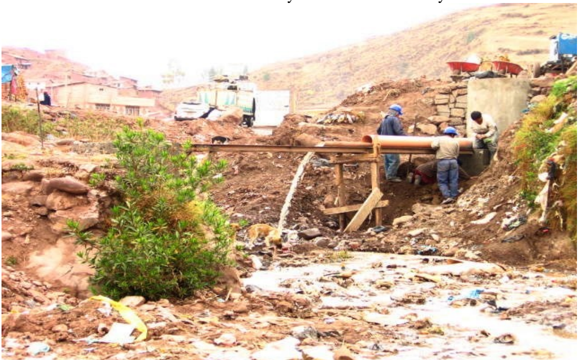
Foto 4 Construcción del interceptor Huatanay para recolectar los desagües
