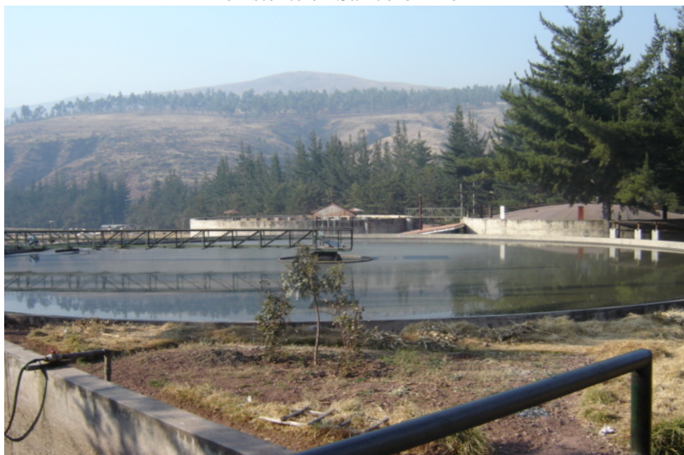
Figura N° A-8.2 PTAR existente en San Jerónimo
