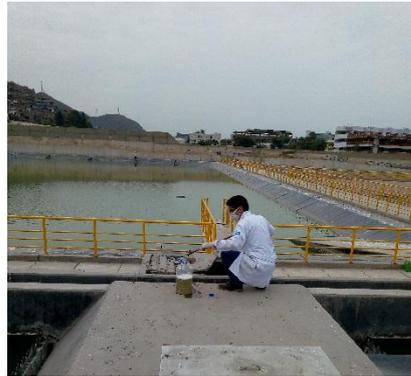
**Fotografía. 12.1. Reactor UASB – extracción de muestra del efluente del reactor**
