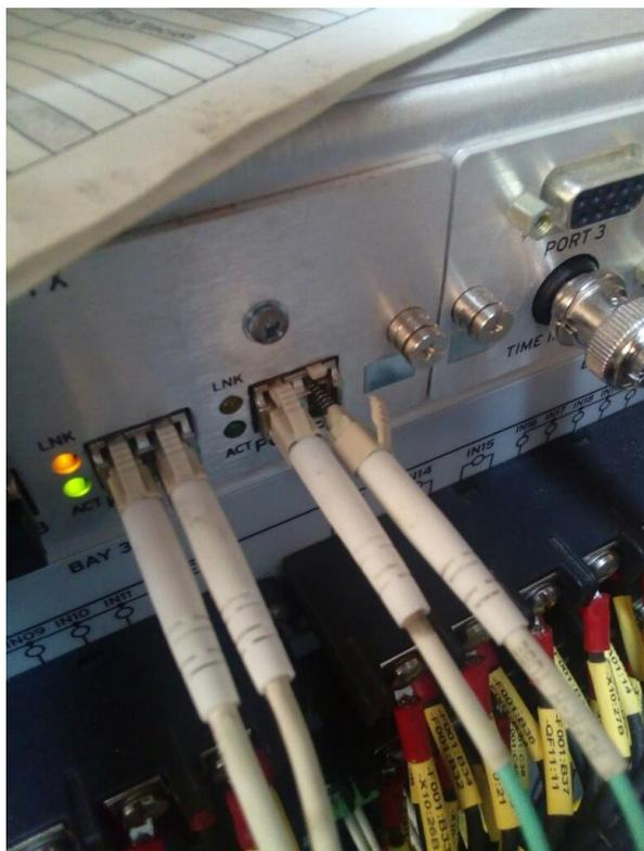
**Fig. C.3:** Conexiones de fibra óptica al equipo de telecomunicaciones (Router).
