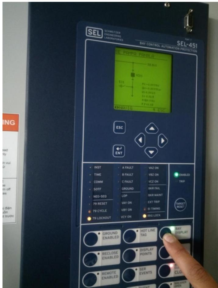
Fig. C.15: Relé de protección de sobrecorriente.
