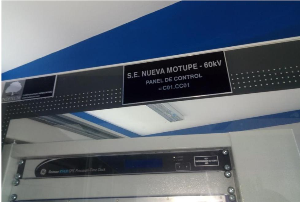
Fig. C.14: Equipo GPS en tablero de control
