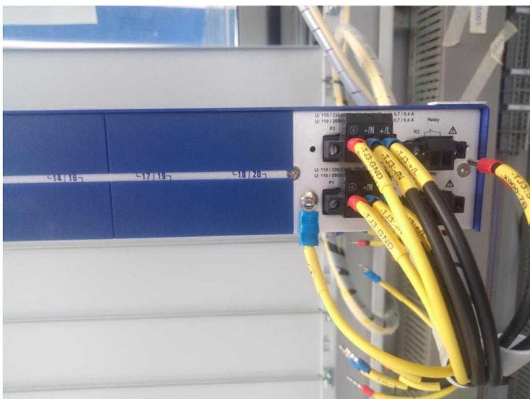
**Fig. C.4:** Conexiones de alimentación al equipo de telecomunicaciones (Router).
