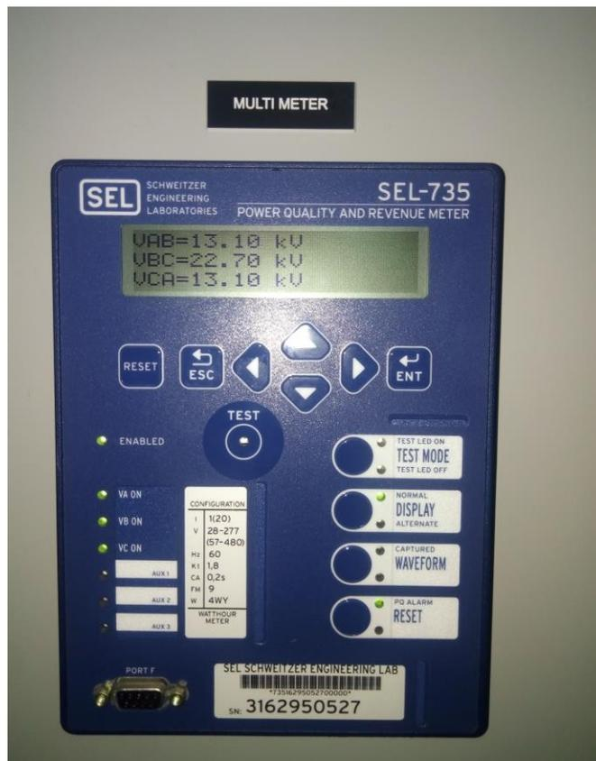
Fig. C.16: Medidor de energía y facturación.
