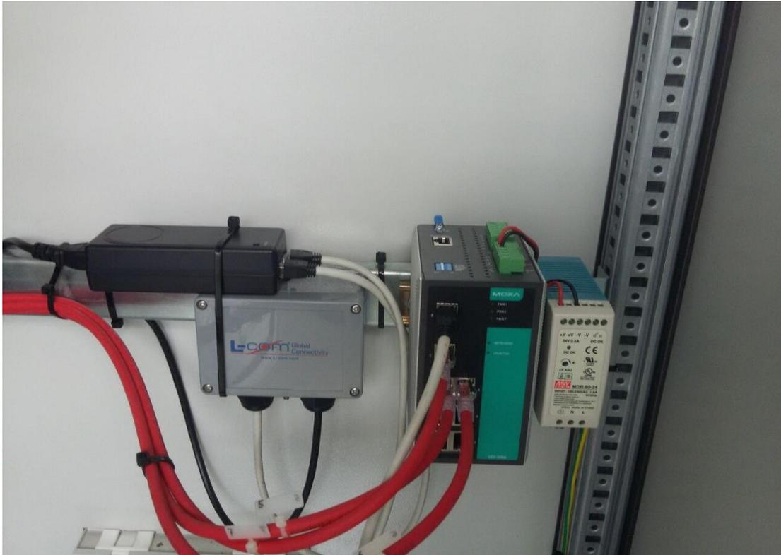
**Fig. C.7:** Cableado estructurado de los equipos inalámbricos.
