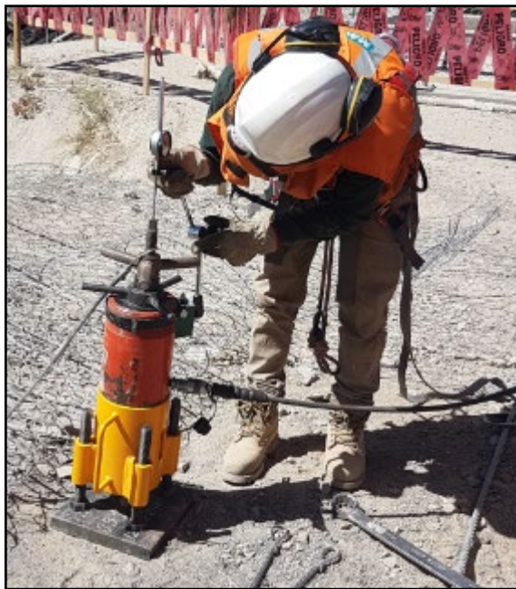
Figura N°5.8 Instalación del equipo de ensayo
