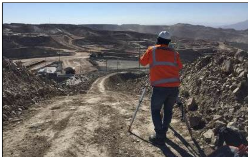
Figura N°4.1 Levantamiento topográfico en cresta del talud
