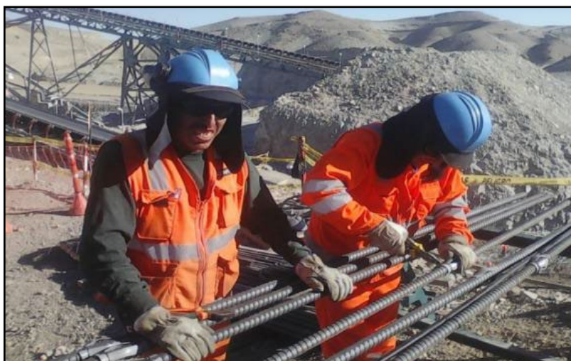
Figura N°4.2 Acondicionamiento de los anclajes
