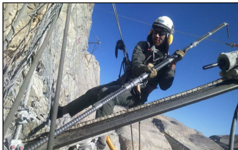
Figura N°4.11 Colocación del anclaje en el talud
