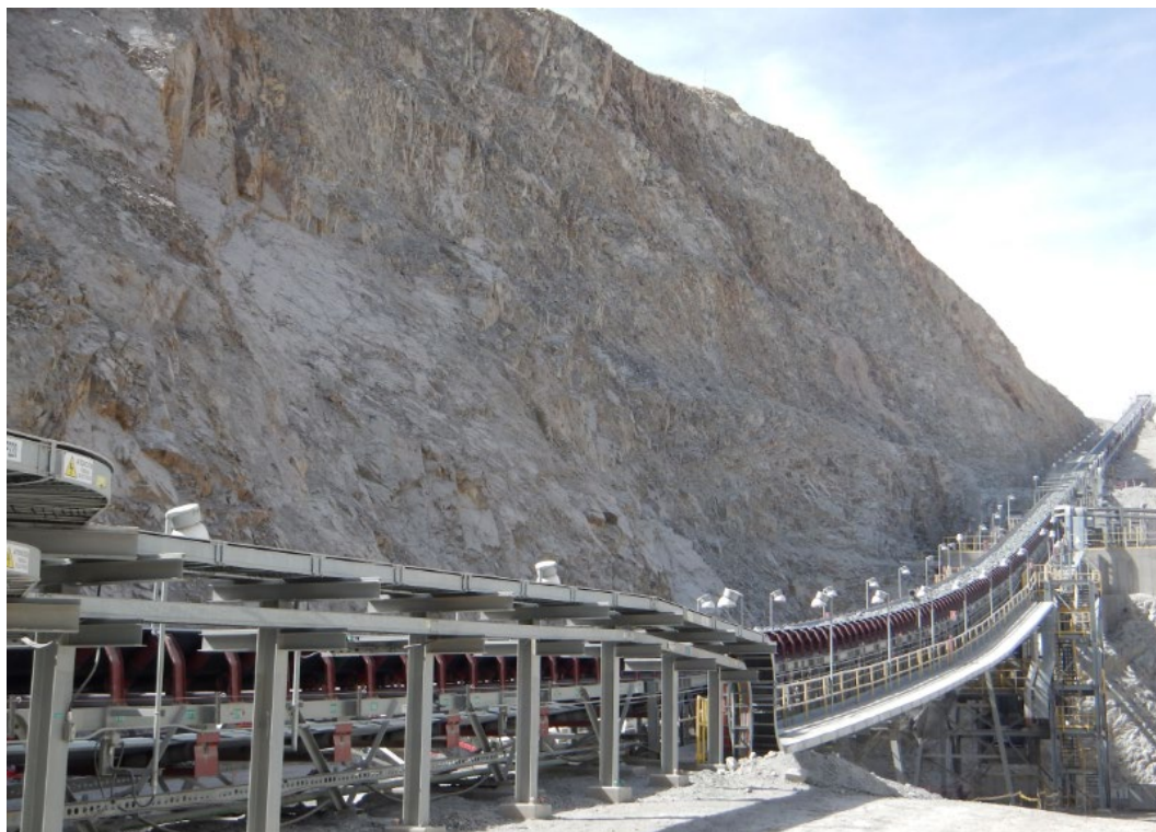
Figura N°3.2 Vista frontal del talud
