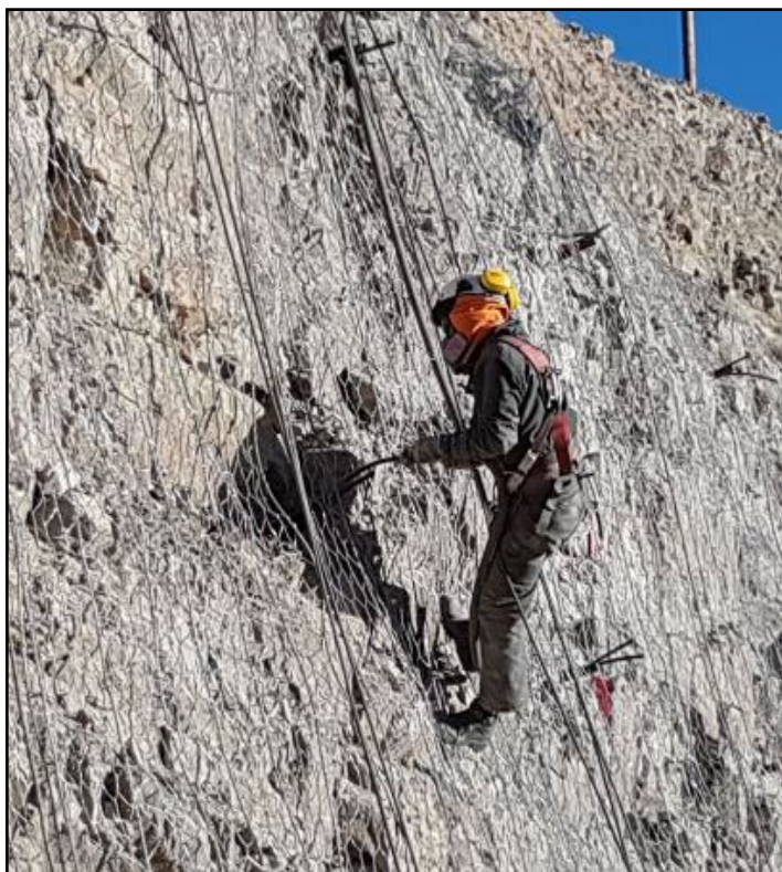
Figura N°4.12 Inyección de anclaje
