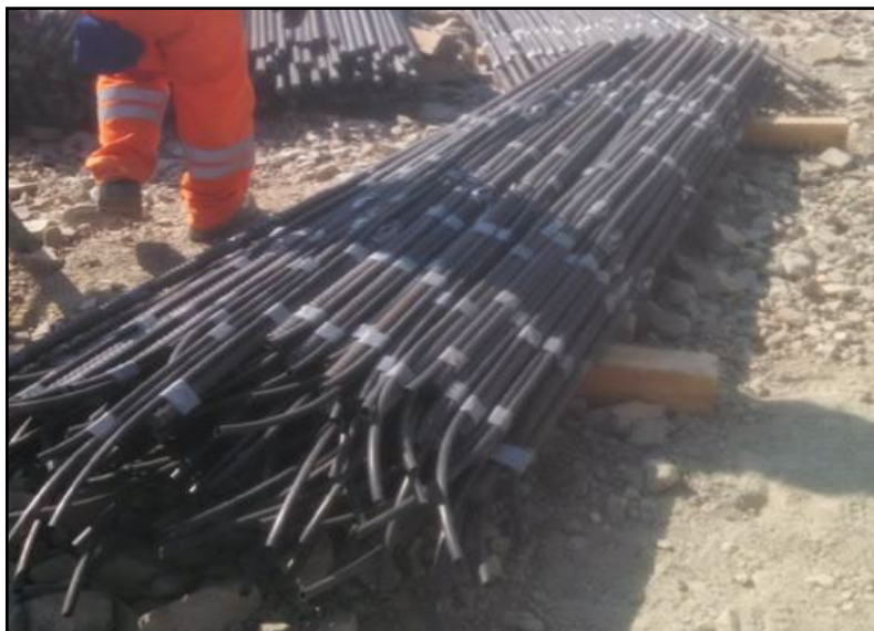
Figura N°4.3 Anclajes sobre parihuelas
