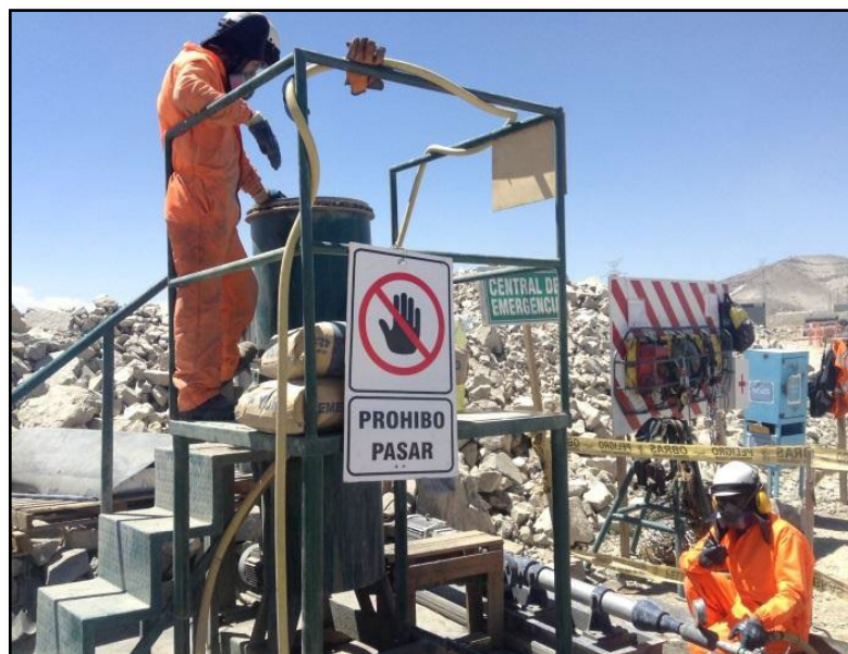
Figura N°4.10 Central de Inyección en la cresta del talud
