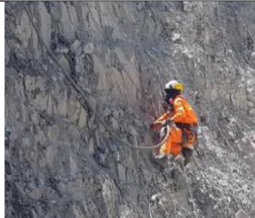
Inyección en la cara de talud
