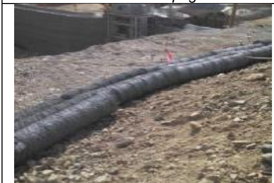
Tendido de malla en la cresta de talud
