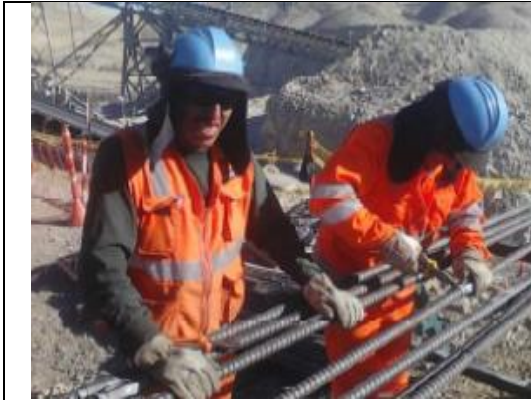
Preparación del anclaje
