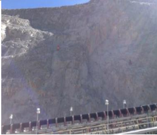
Vista frontal de talud
