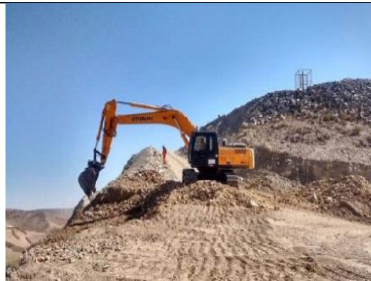
Limpieza con excavadora en cresta de talud
