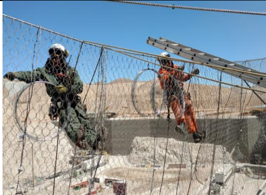
Instalación de la barrera híbrida
