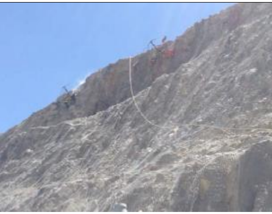
Perforación con Tam Rock
