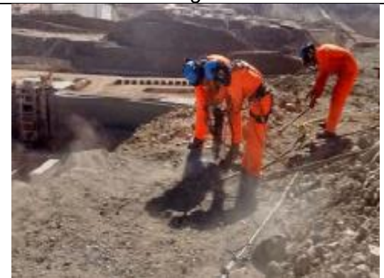
Instalación de línea de vida
