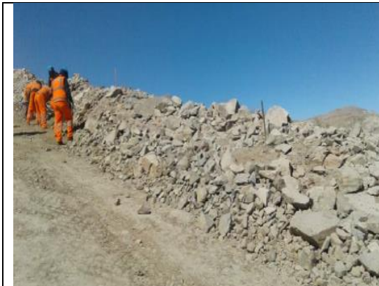
Limpieza manual en cresta de talud
