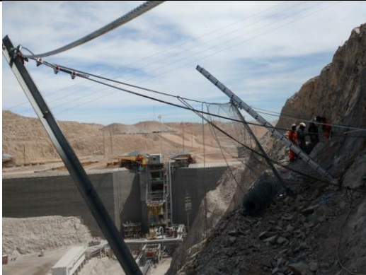
Colocación de la barrera híbrida
