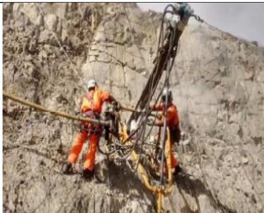
Perforación en la cara de talud
