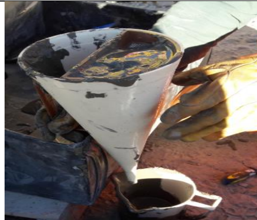
Fluidez del grout
