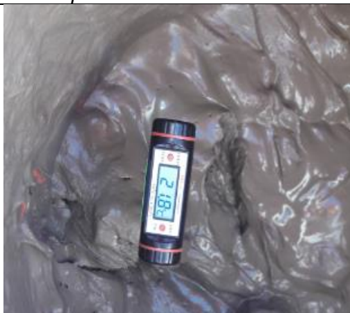
Temperatura de grout
