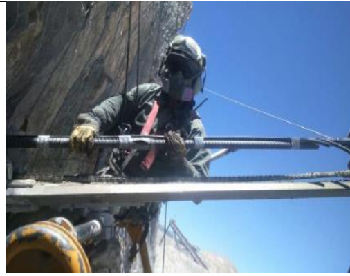
Colocación de la barra helicoidal
