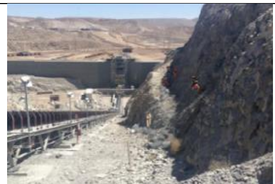
Tendido de malla en la cara del talud
