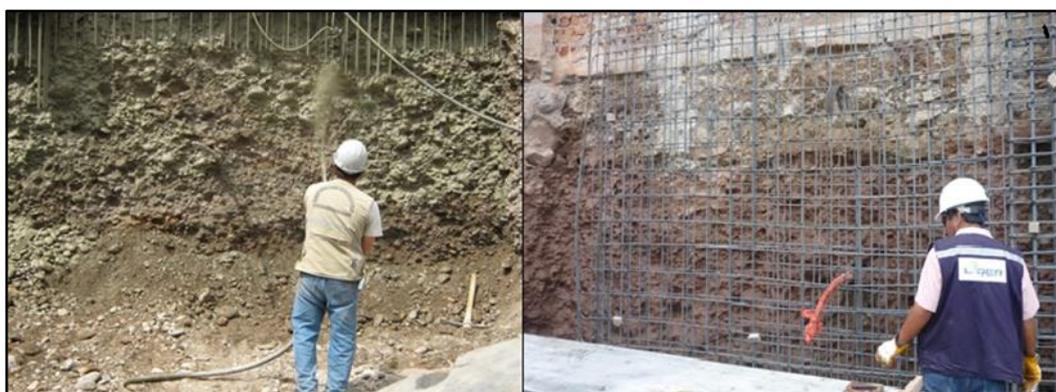
Figura 12: Colocación de armadura de Muro. Fuente: Pilotes Terratest Perú
