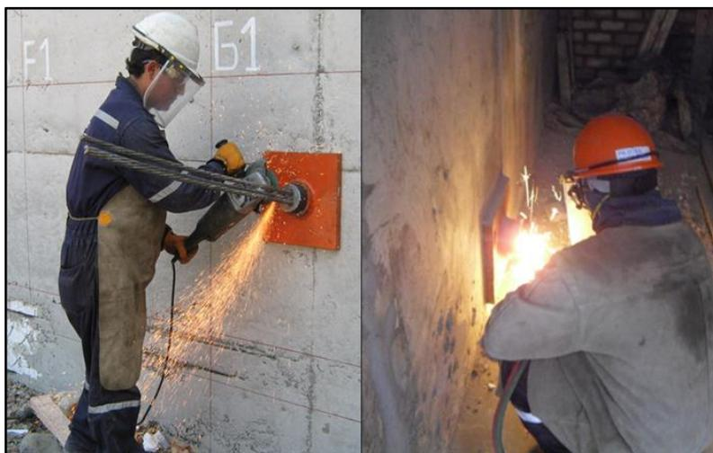
Figura 17: Proceso de destensado de Anclajes. Fuente: Pilotes Terratest Perú
