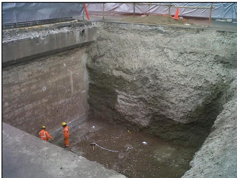
Figura 6: Vista del conglomerado de Lima. Obra Tramo 1 del Metro de Lima. 2010 (Fuente: Pilotes Terratest Perú S.A.C.)
