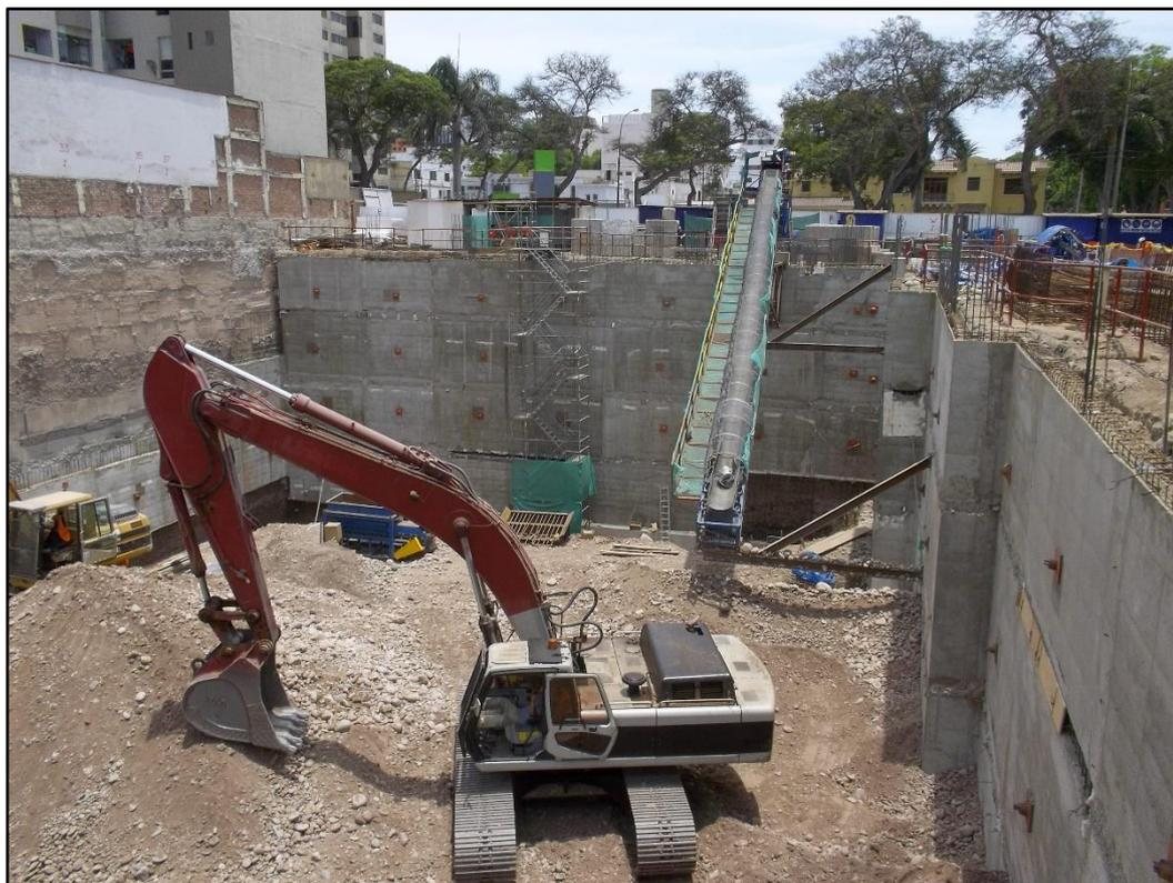
Figura 32: Estabilización perimetral del proyecto durante la etapa de excavación.
