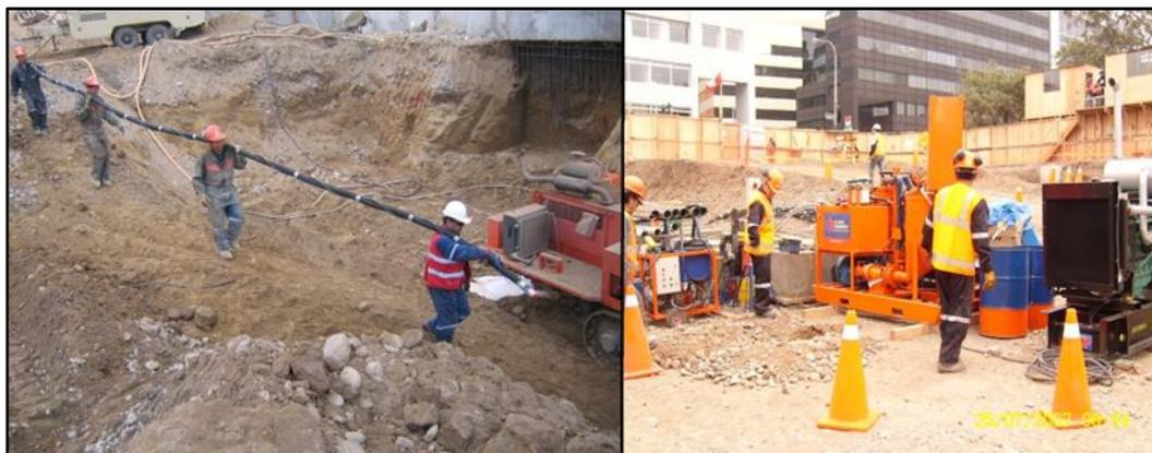
Figura 11: Proceso de Instalación de anclajes e inyección de lechada de concreto. Fuente: Pilotes Terratest Perú
