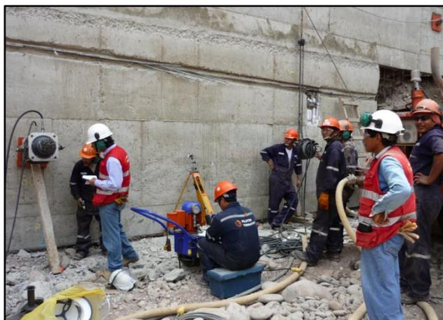
Figura 16: Proceso de tensado mediante una gata hidráulica. Fuente: Pilotes Terratest Perú
