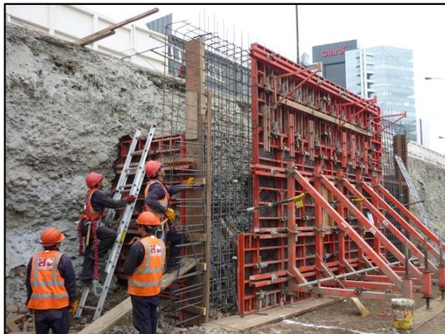
Figura 13:Proceso de encofrado en obra. Fuente: Pilotes Terratest Perú
