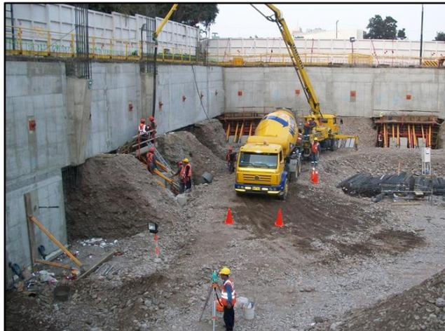
Figura 14: Vaciado de concreto en obra. Fuente: Pilotes Terratest Perú
