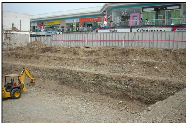
Figura 9: Primera etapa de excavación y perfilado. Fuente: Pilotes Terratest Perú
