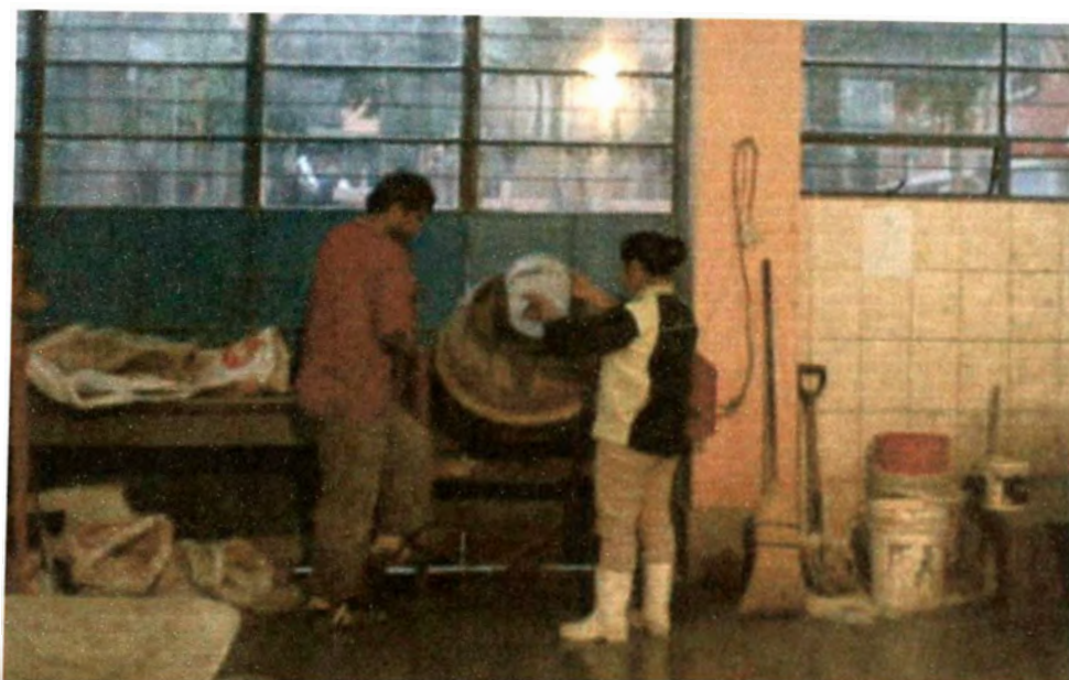
Foto G 5.- Preparación de la mezcla de concreto.
