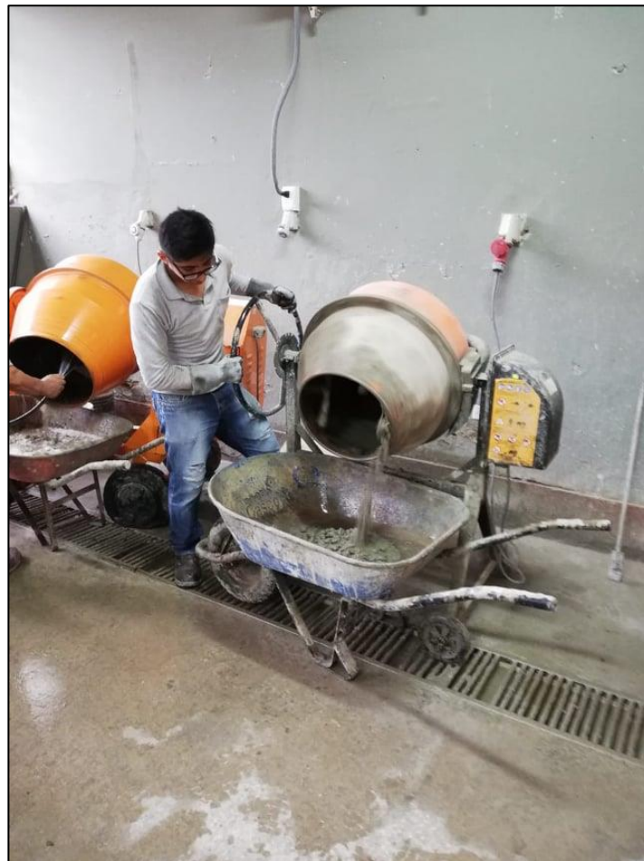
Figura N°4 Realización del concreto.
