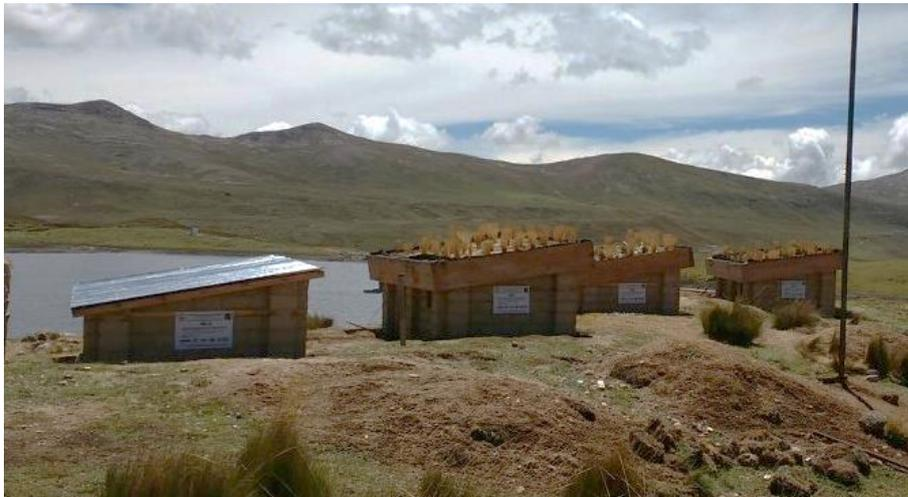
Figura 16 Vista Panorámica del modelo de control (izquierda) y de los tres modelos de vivienda con techo verde.
