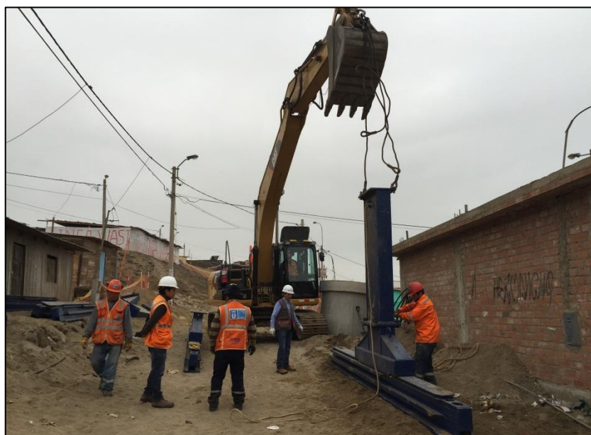
Figura 4.8. Armado de pórticos (carril deslizante con tensor rodante) con presencia del proveedor
