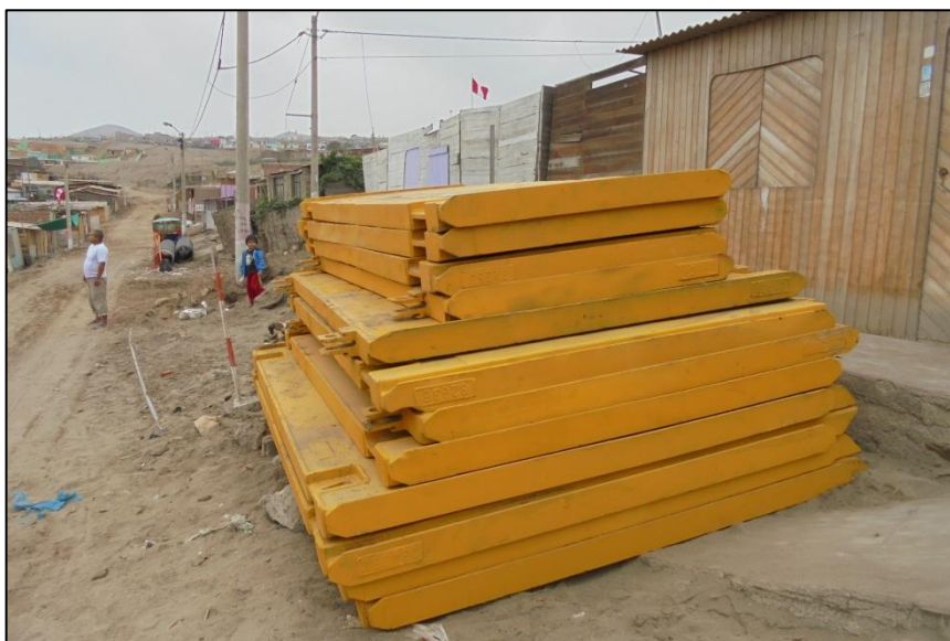
Figura 4.7. Paneles inferiores, intermedios y superiores
