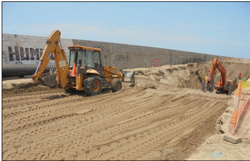
Figura 3.21. Relleno de zanja
