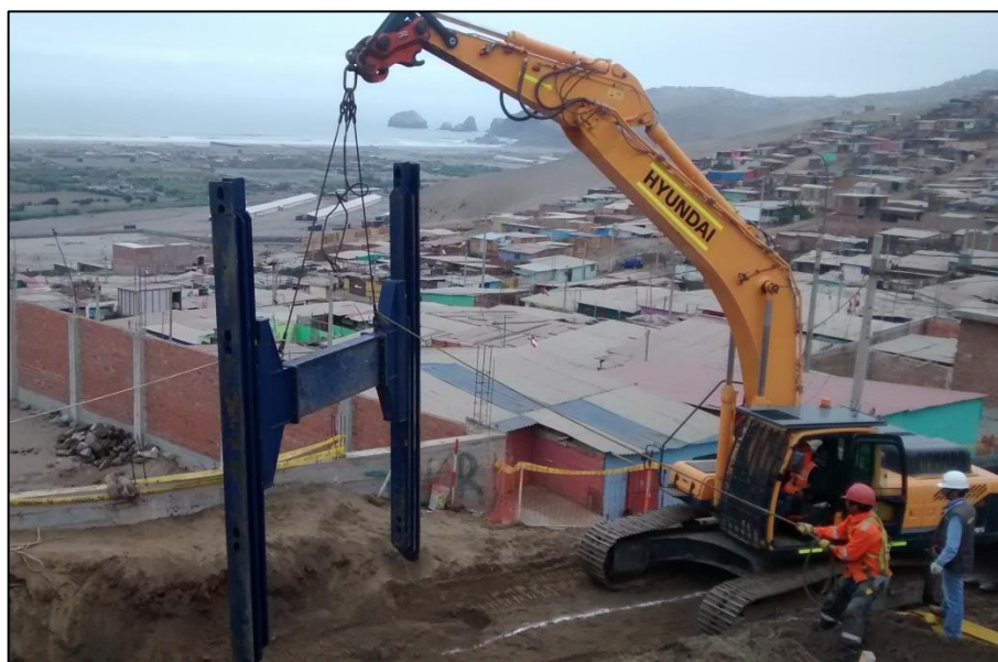
Figura 4.10. Izaje e instalación de pórtico, con dirección técnica de proveedor
