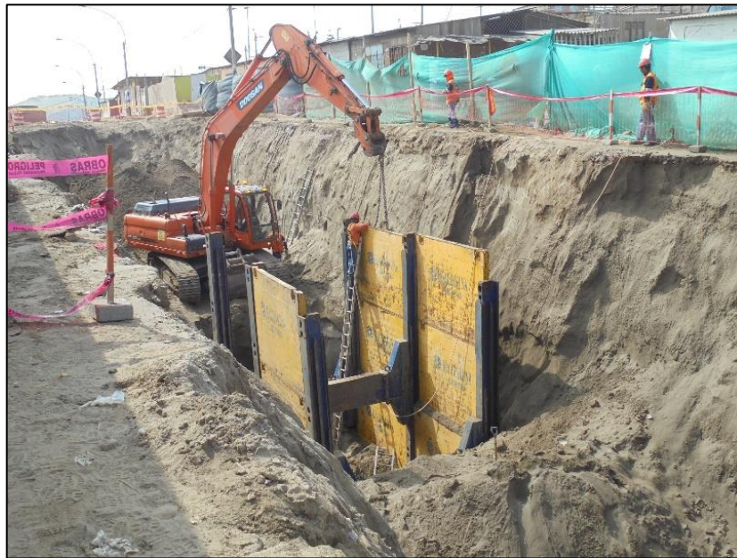
Figura 3.15. Instalación de paneles sobre pórticos instalados
