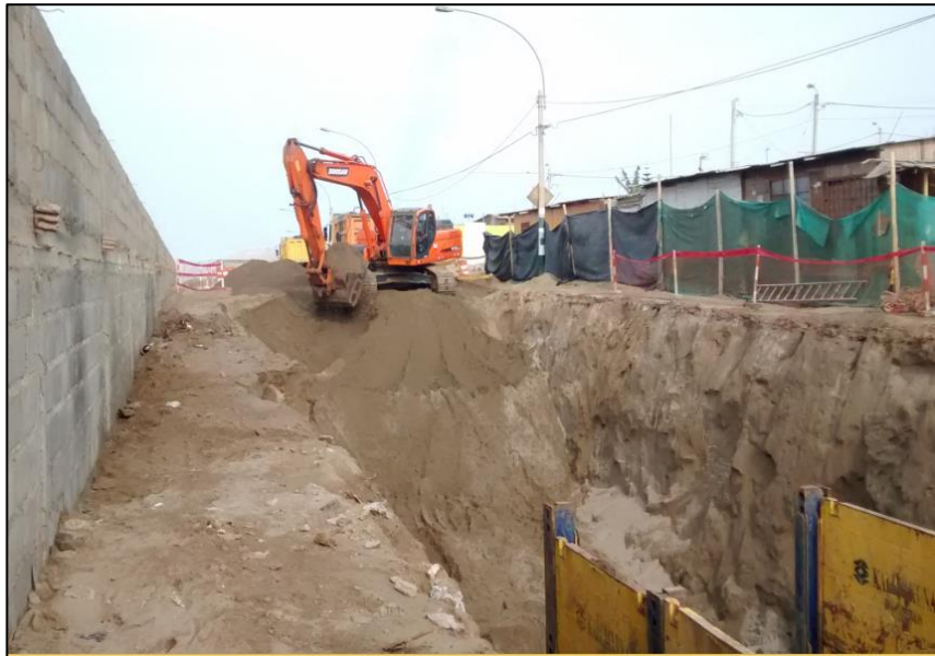
Figura 3.9. Excavación de banqueteta (hasta N.T. - 4.50 m)
