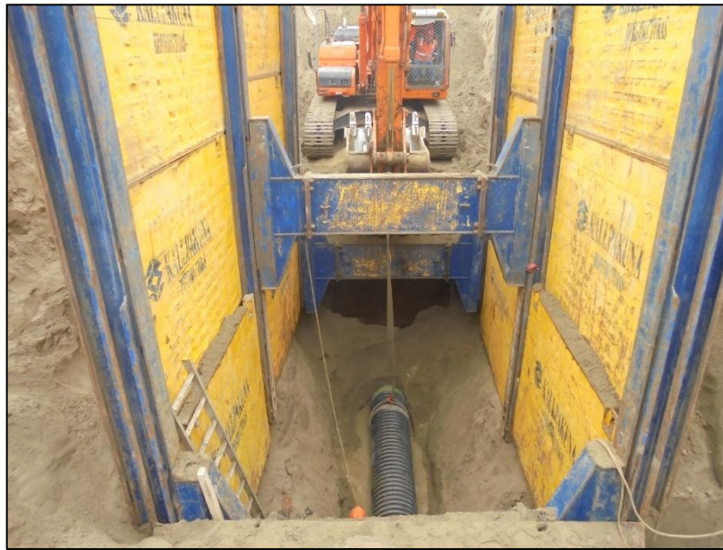
Figura 3.17. Instalación de tubería
