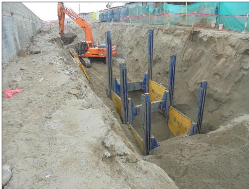
Figura 3.14. Excavación dentro de los cajones instalados
