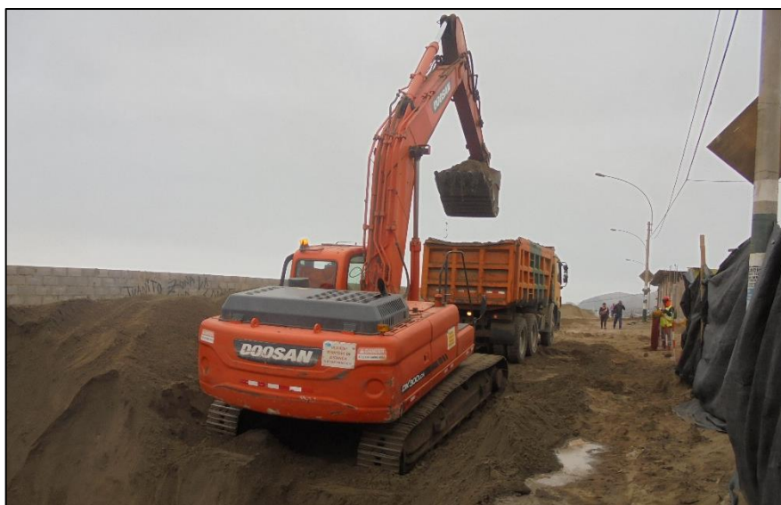
Figura 4.12. Excavación de rampa para llegar a banqueta
