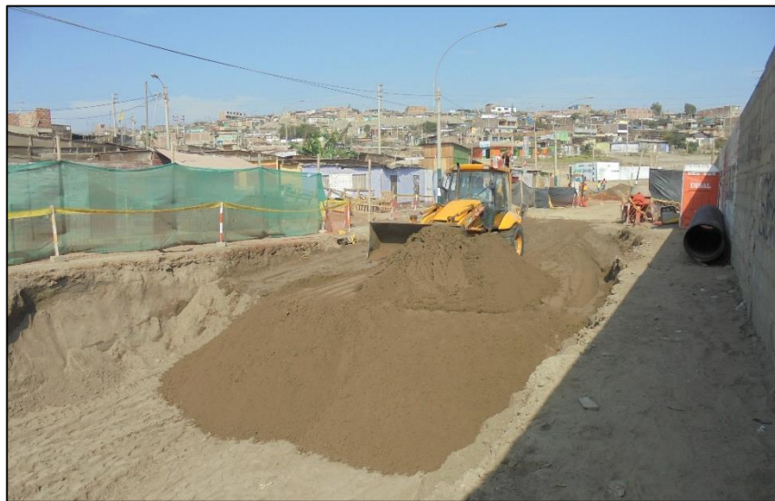
Figura 3.22. Relleno y compactación de zanja
