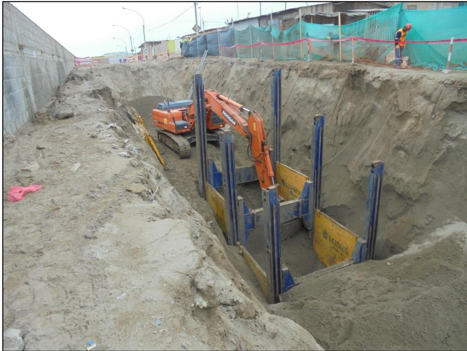
Figura 5.5. Uso de 2 cajones, largo del brazo de excavadora llega sin dificultad
