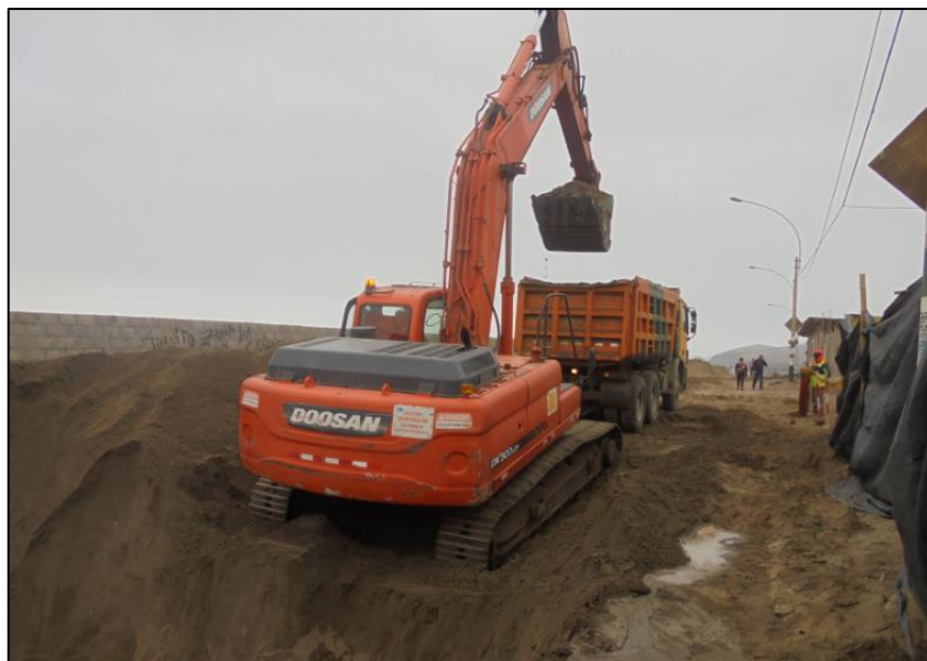
Figura 3.10. Carguío a volquete, material de zona de banqueteta (hasta N.T. - 4.50 m)
