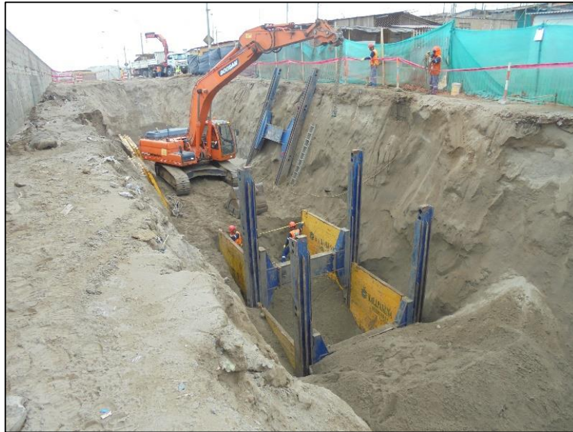
Figura 3.13. Instalación del segundo cajón
