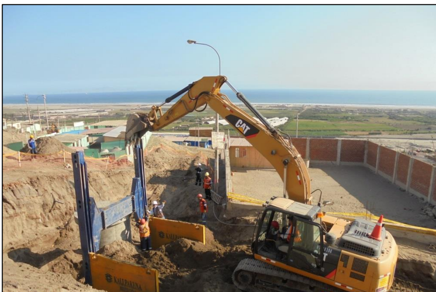
Figura 4.11. Instalación de pórtico con paneles
