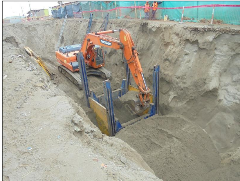
Figura 3.12. Instalación del primer cajón
