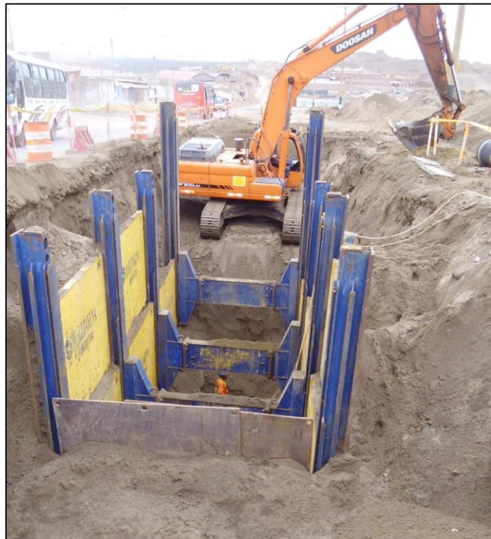
Figura 4.16. Excavación e instalación de entibado, usando 4 pórticos – 3 cajones
