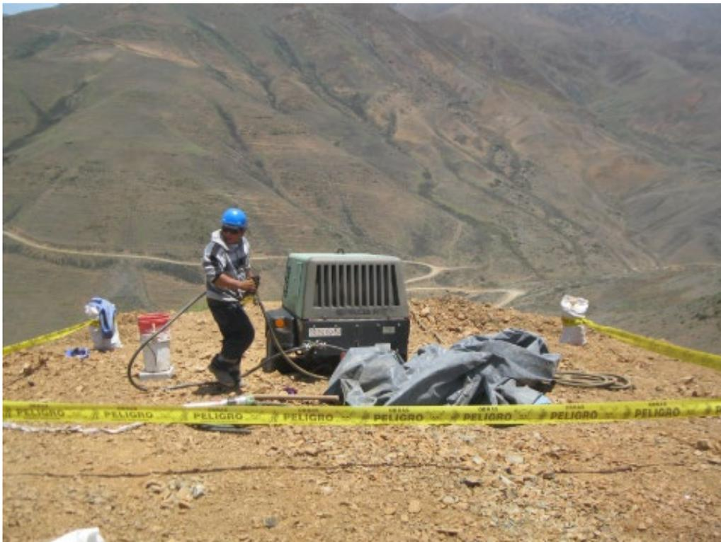
Foto 8 También se utilizó Herramientas de poder, para no realizar voladura de rocas.
