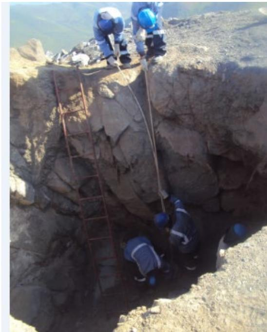
Foto 4 El desalajo de material rocoso, con cuerdas, sin utilizar sistemas de restricción anti caídas.
