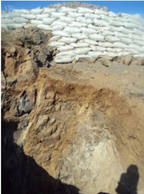
Foto 2 La utilización de barricadas en el control de desprendimiento de roca suelta en los taludes.
