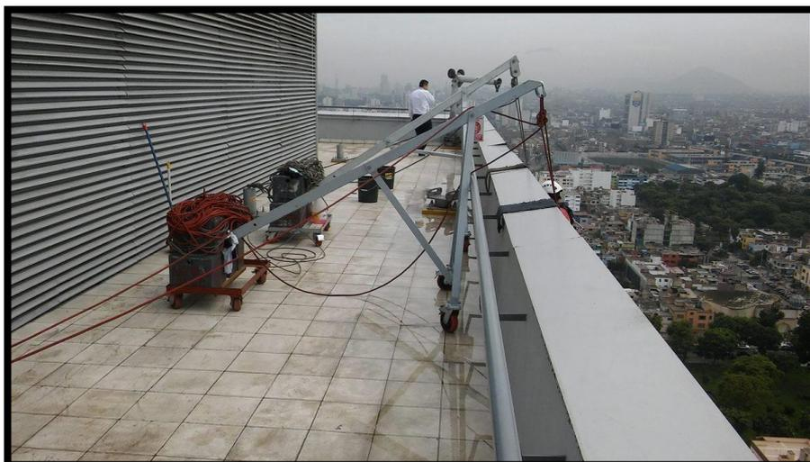
**Figura 3.6. Sistema de Anclaje con contrapesos.**
