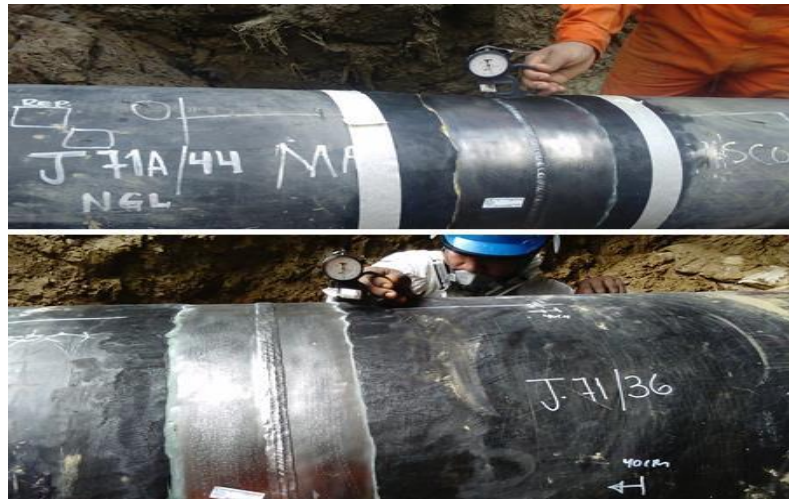
Figura 15: Medición del perfil de rugosidad en la Línea LGN
