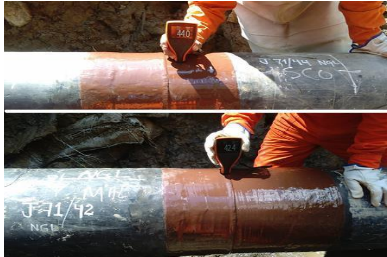
Figura 18: Medición de espesores en película seca a línea LGN
