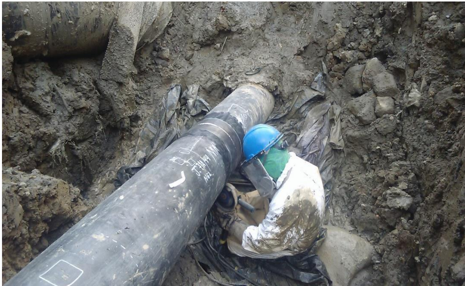
Figura 4: Preparación de superficie SSPC-SP 11
