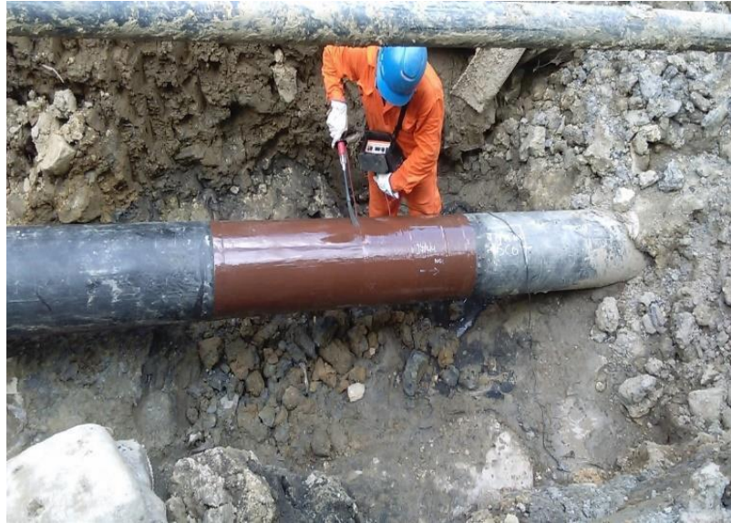
Figura 8: Identificación de discontinuidades según estándar NACE SP0188
