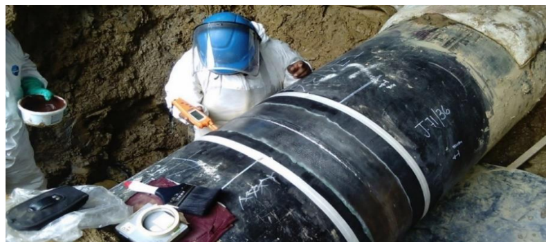
Figura 16: Medición de temperatura de superficie expuesta de la Línea LGN
