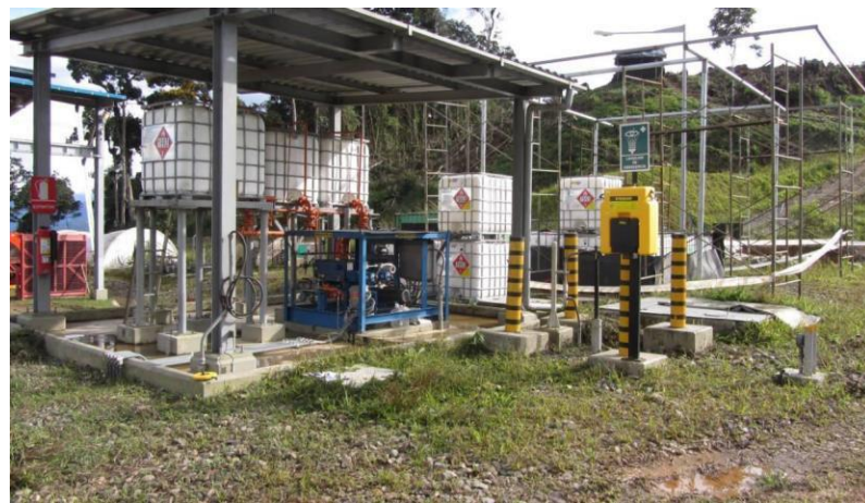
Figura 20: Sistema del agente Drag Reducer en la estación de bombeo PS2
