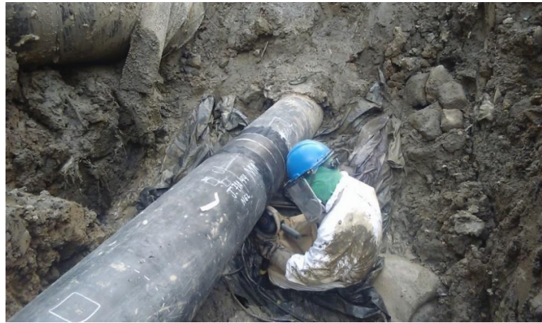
Figura 14: Preparación de superficie SSPC-SP11 a tubería de fluido LGN
