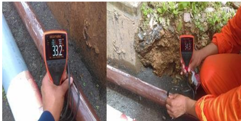
Figura 24: Medición de espesores en película seca a Línea de aire.
