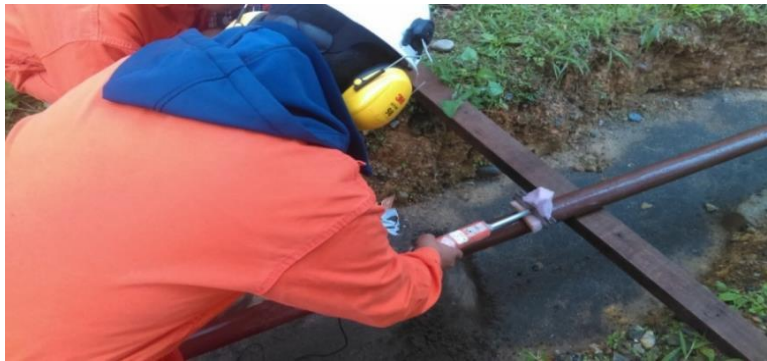
Figura 25: Inspección de discontinuidades en Línea de aire
