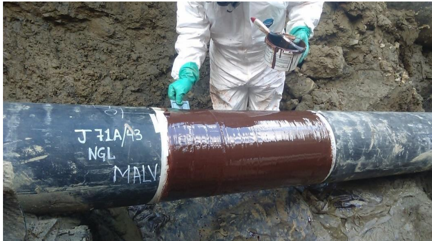
Figura 17: Medición de espesores en película húmeda a la Línea de LGN
