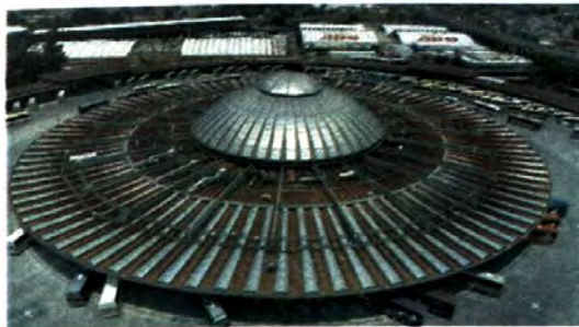
VISTA AÉREA DE LA CÚPULA
