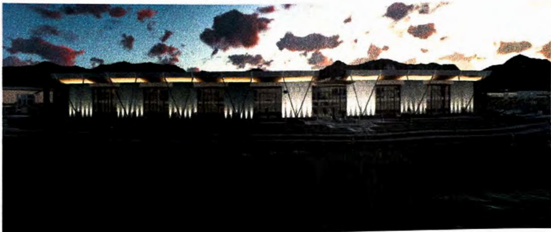
Iluminación artificial de pórtico
