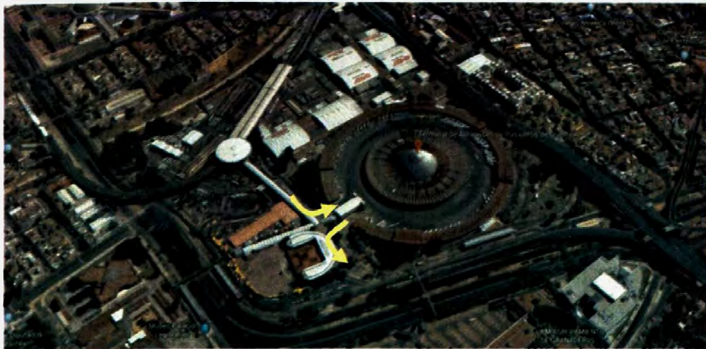
Ubicación del terminal – Accesibilidad
