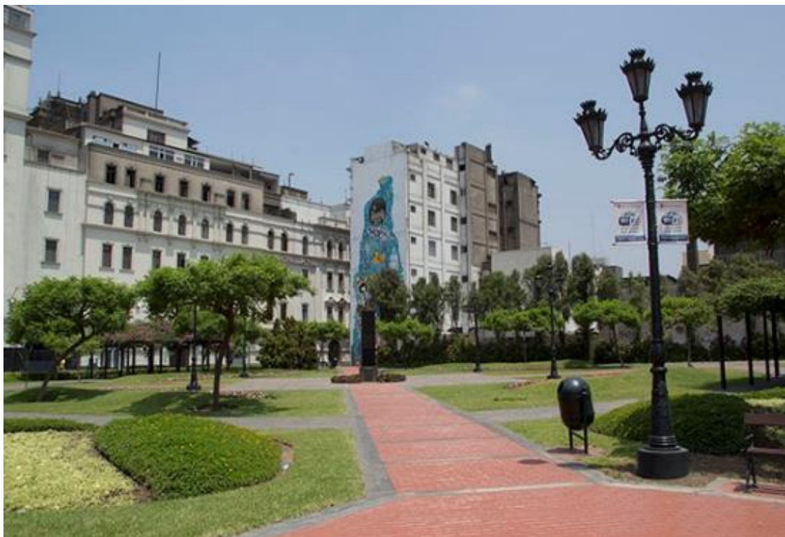
Figura N°18: Estado actual del lote.
