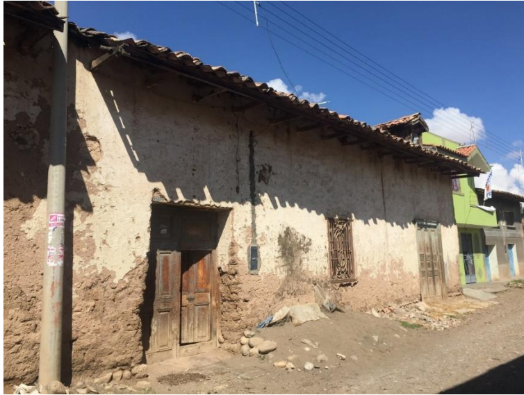
Foto 1.- Foto fachada exterior de Vivienda vernácula andina 01 donde se muestra el emplazamiento de la vivienda a plomo de vereda y predomina el lleno sobre el vacío en fachada. Foto propia tomada en octubre 2018
