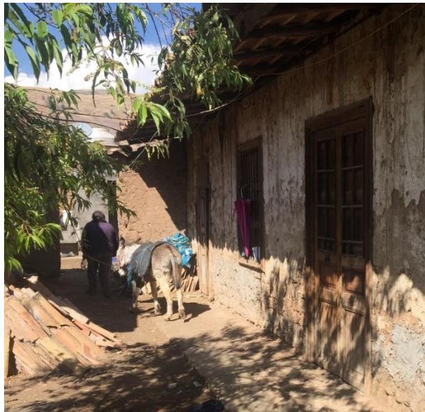
Foto 2.- Foto fachada interior de Vivienda vernácula andina 01 donde se muestra que la aparición de vanos es más notoria hacia el interior y cuenta con mayores dimensiones que en el exterior. Foto propia tomada en octubre 2018
