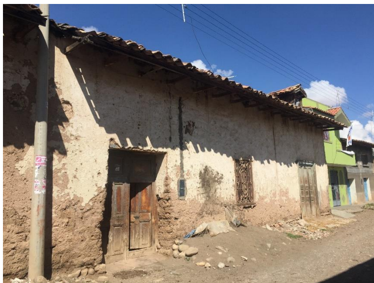
Foto 18.- Foto de fachada Vivienda vernácula andina número 1. Foto propia tomada en octubre 2018.
