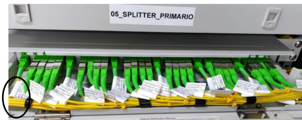
Figura 4.12 Instalación y cableado de fibras ópticas en el divisor óptico primario
