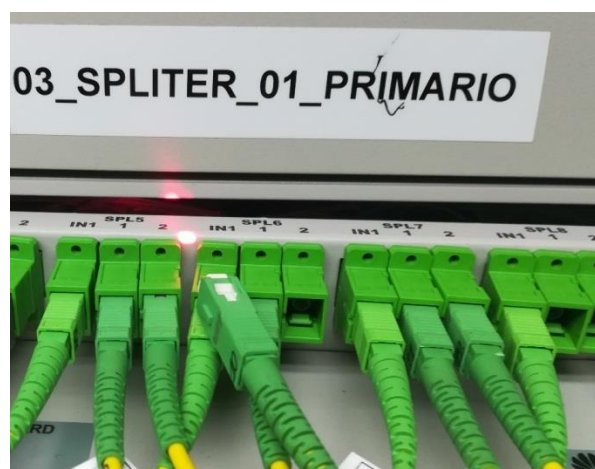
Figura 4.35 Salida de luz roja en la fibra óptica del divisor óptico (splitter) Fuente: Propia
