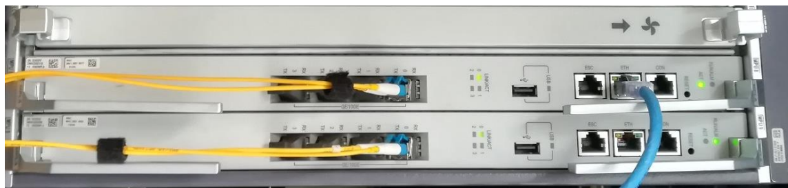
Figura 4.10 Instalación y cableado de fibras ópticas en componentes H902MPLA
