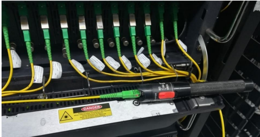
Figura 4.33 Emisión de luz roja en la fibra óptica de la fuente de televisión Fuente: Propia
