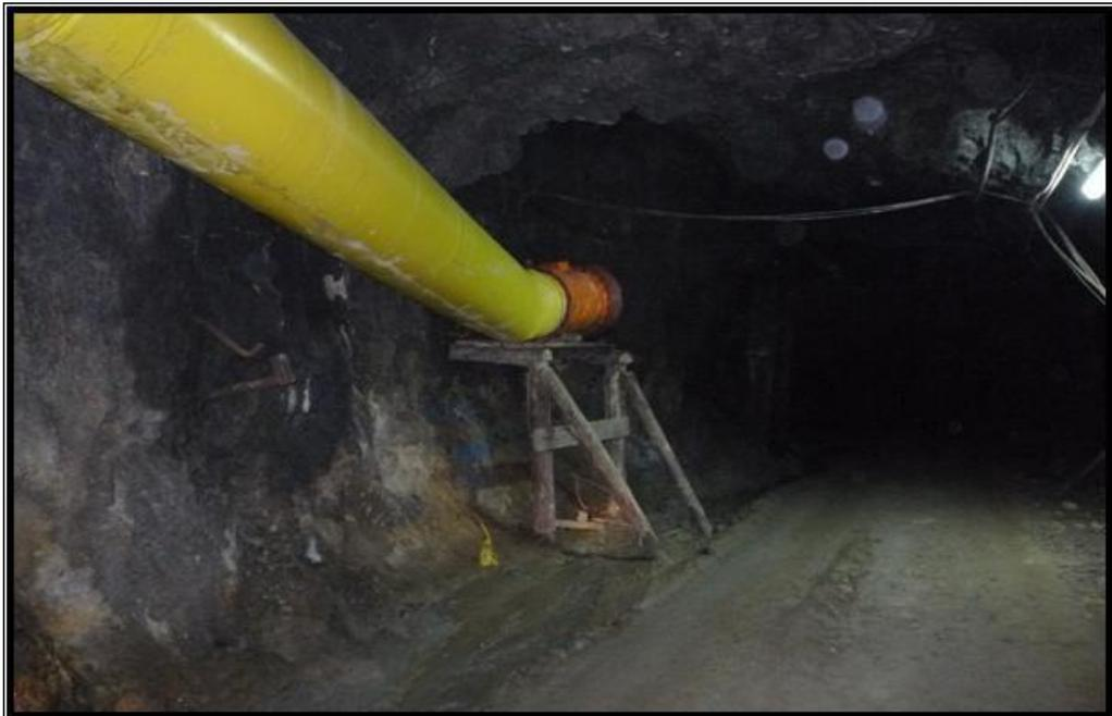
**Fotografía N° 7. Instalación de Ventilador – Nivel 280**
