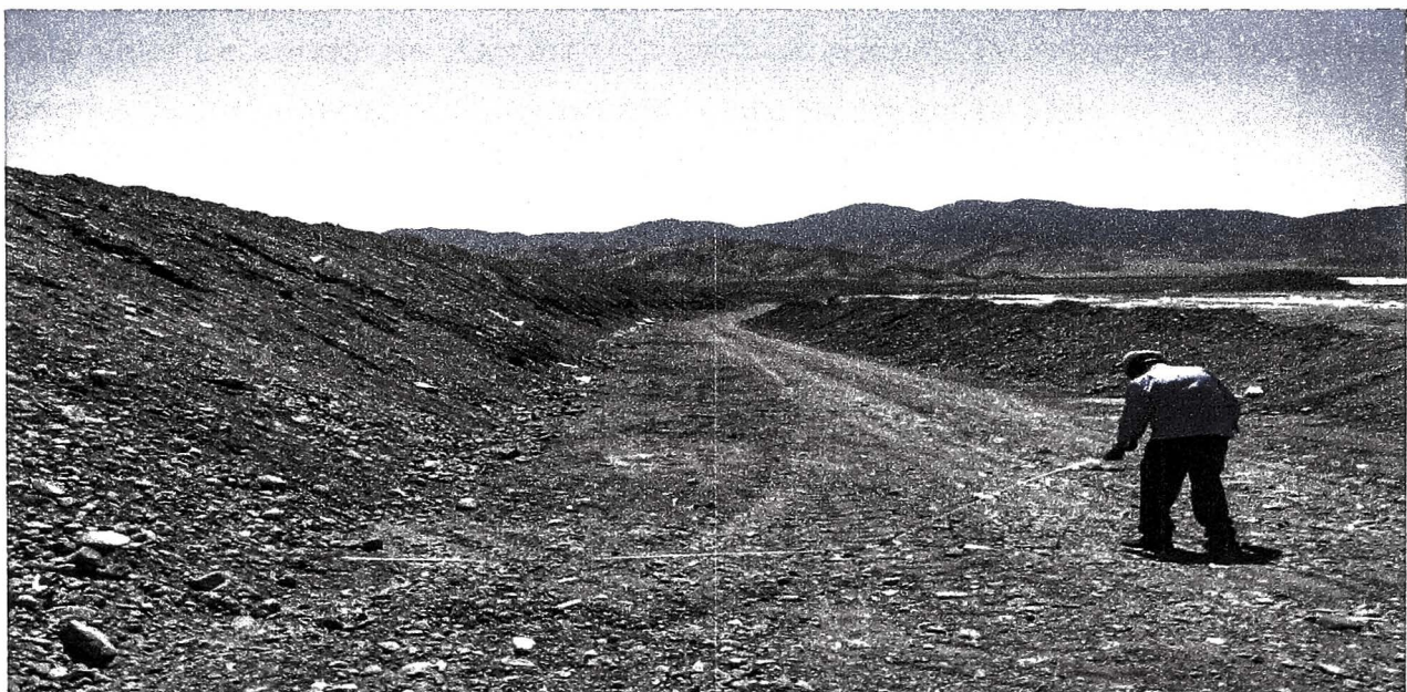
Figura N° 12 Medición del canal.
