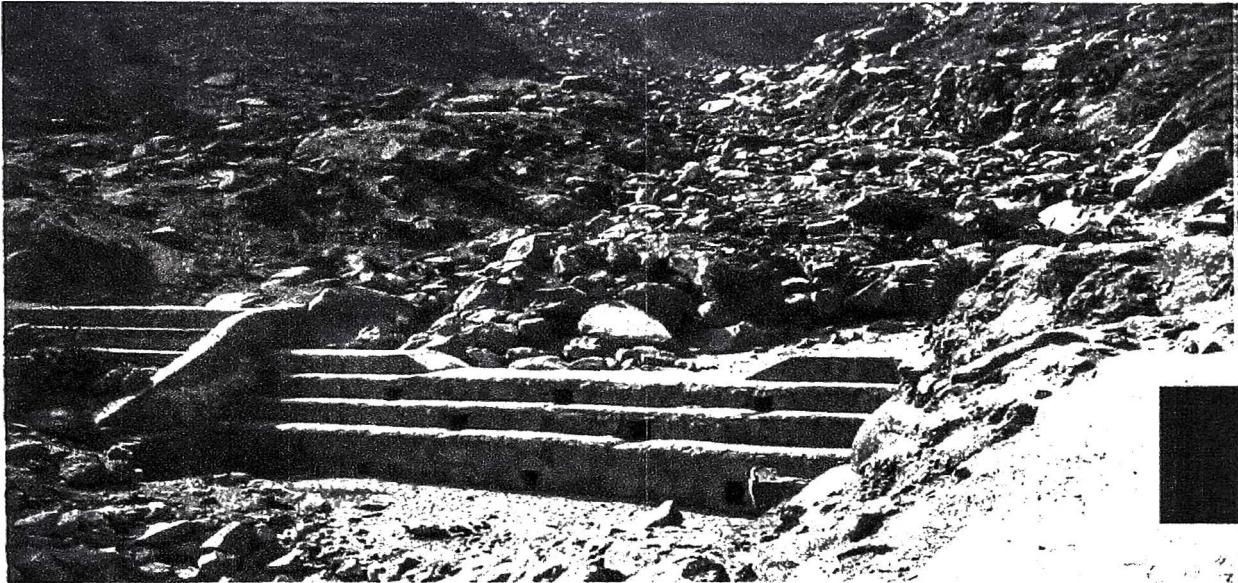
Figura N°7 Dique de escombro.
