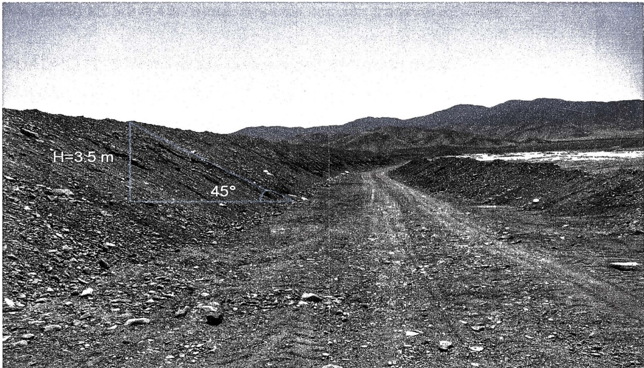
Figura N° 11 Sección del canal.
