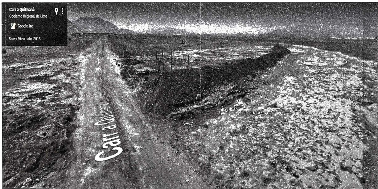
Figura N° 3 Cauce del río seco intersección con carretera de acceso Quilmana.
