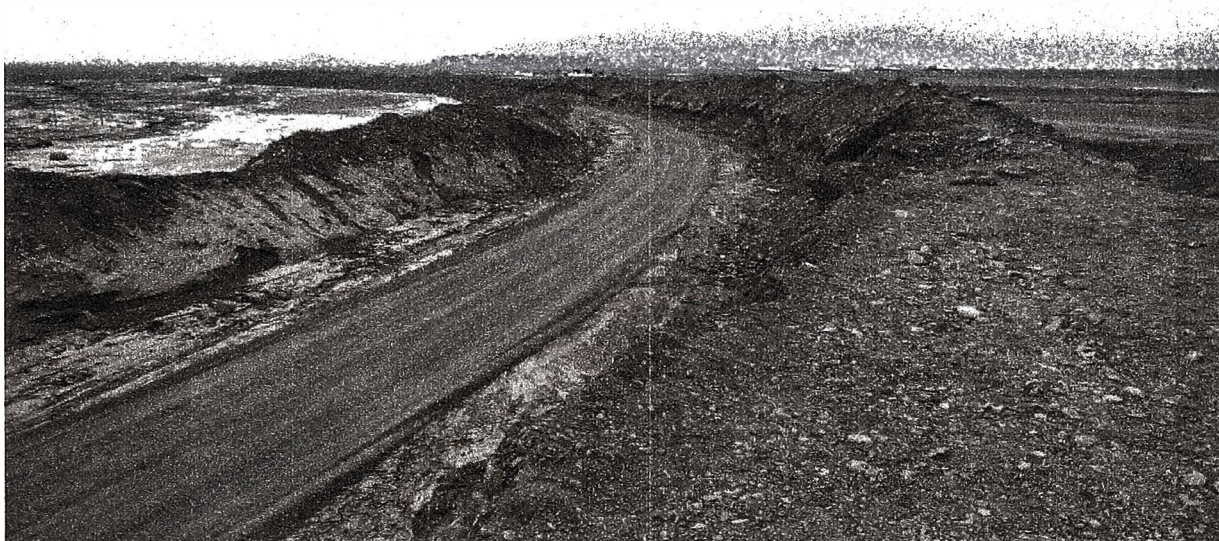
Figura N°4 Trabajos de prevención.
