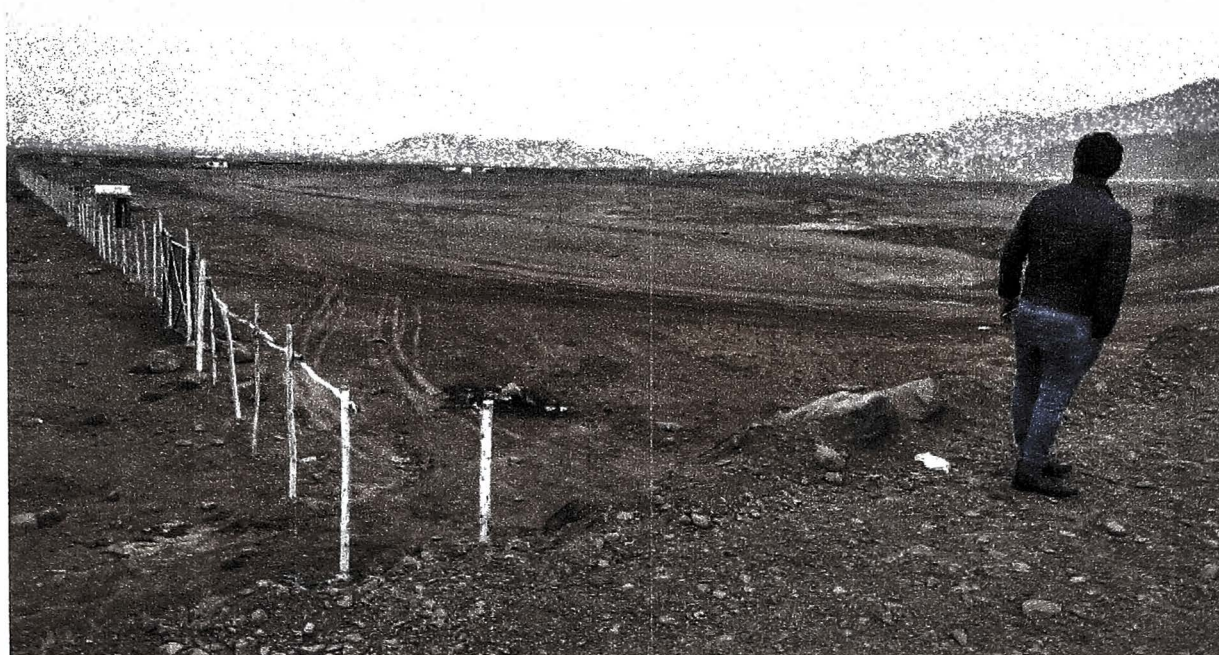
Figura N°5 Trabajos de prevención intersección con la carretera de acceso.
