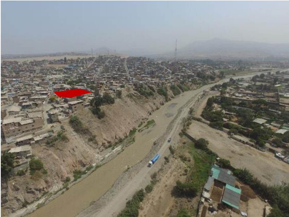
Imagen N°40: Vista aérea del estado actual del Centro Poblado Julio C. Tello en dirección Norte, indicando la ubicación del proyecto de tesis.
