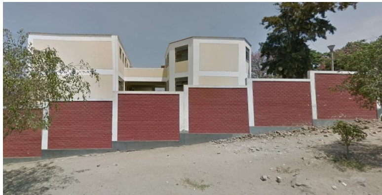
Imagen N°31: Exterior de la I.E. N°6023 Julio C. Tello Fuente: Google maps imágenes.
