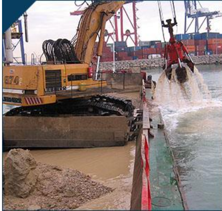
Figura N° 267 Dragado con pulpo hidráulico
