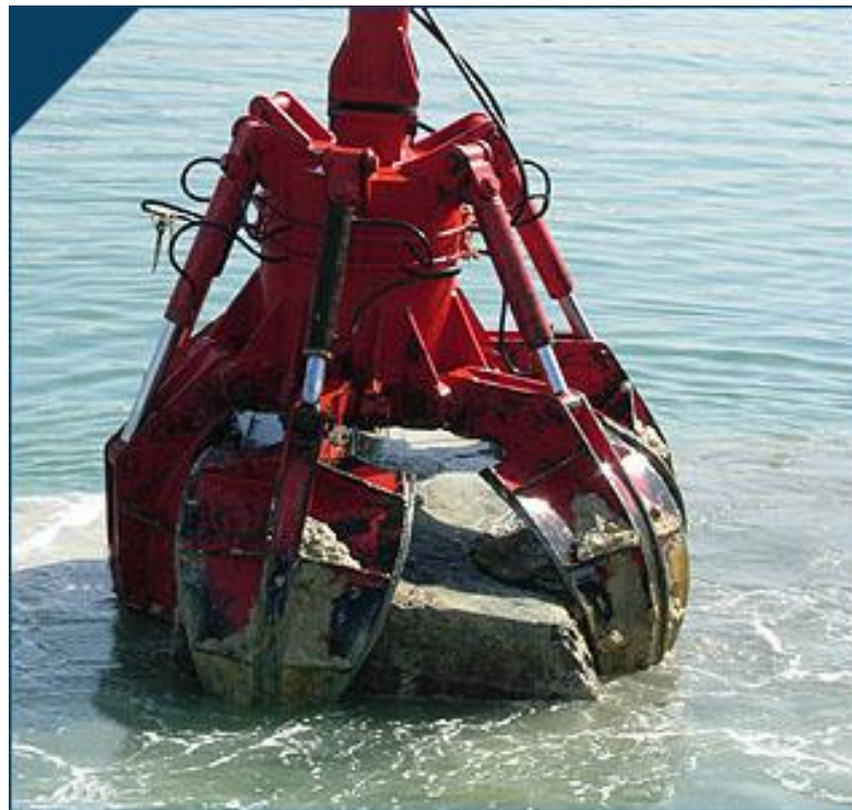
Figura N° 278 Remoción de material dragado del fondo del lecho marino
