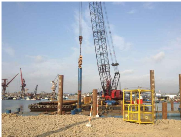
Figura N° 223 Proceso de remoción de pilotes
