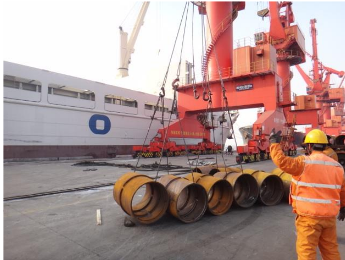
Figura N° 31 Carga de materiales
