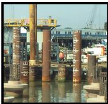
Figura N° 58 Hincado de Pilotes alternos en el muelle 5.
