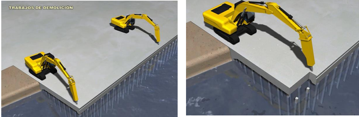
Figura N° 201 Excavadoras con martillos realizando los trabajos de demolición de la plataforma. Fuente:
