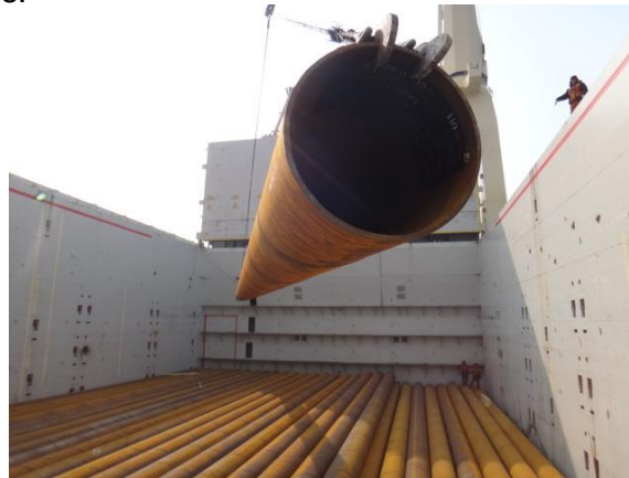
Figura N° 32 Descarga de pilotes
