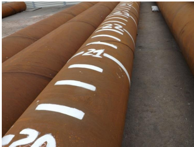
Figura N° 40 Marcas en pilotes
