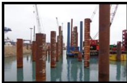
Figura N° 55 Esquema de pilotes con longitud sobresalida
