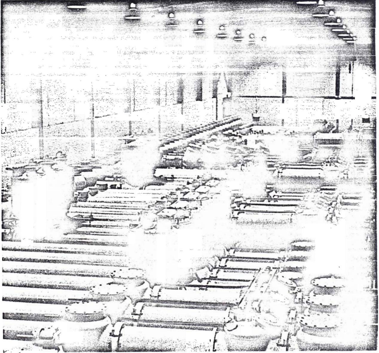
Figura 30- Vista del equipamiento encapsulado en SF<sub>6</sub>
