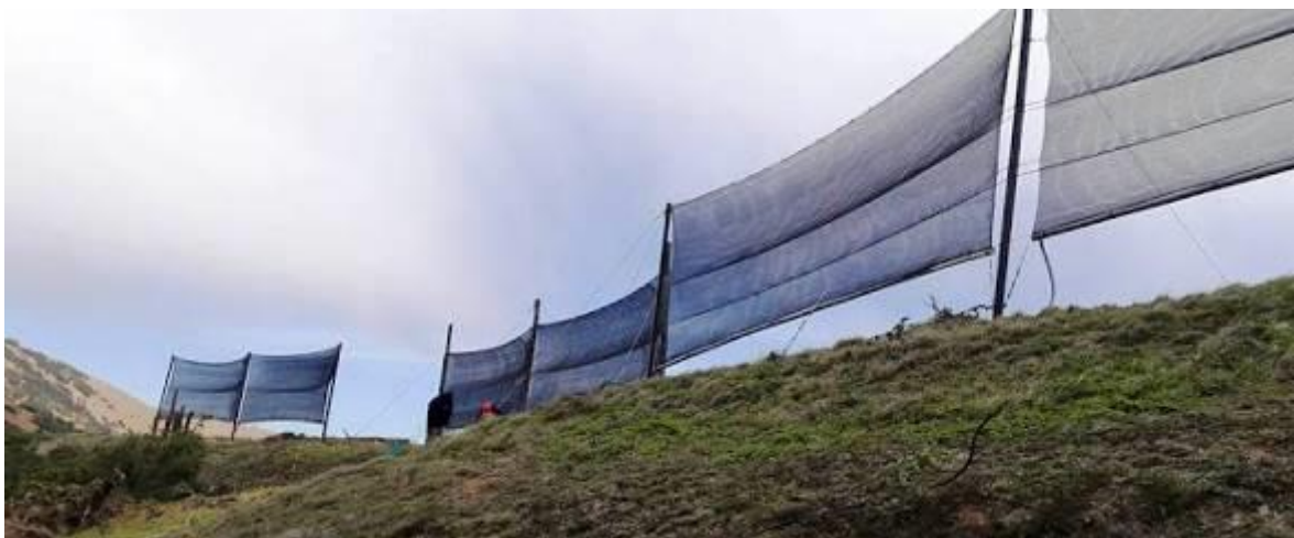
Imagen 37: Atrapanieblas instalados en las lomas de Atiquipa Fuente: Proyecto lomas de Atiquipa
