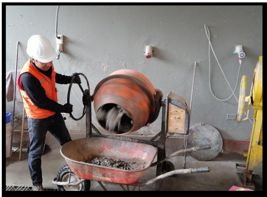
Fotografía N° 12: Proceso de mezclado y vaciado del concreto.
