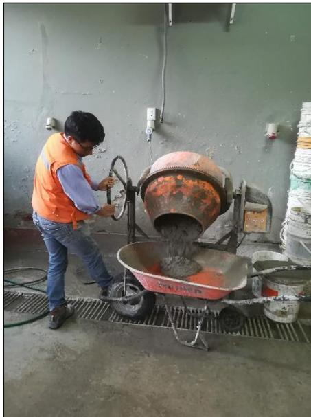
Figura N° 5.2 Proceso de mezclado del concreto ligero.
