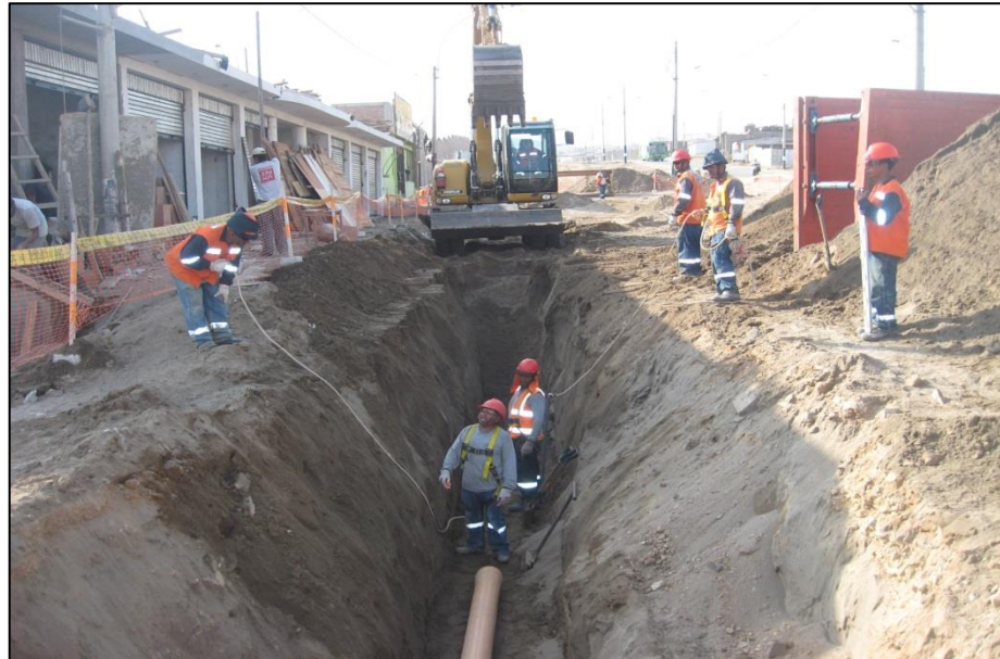
FOTO N°33: Colocación de tubería en excavación tipo II de red de alcantarillado (TII-001).
