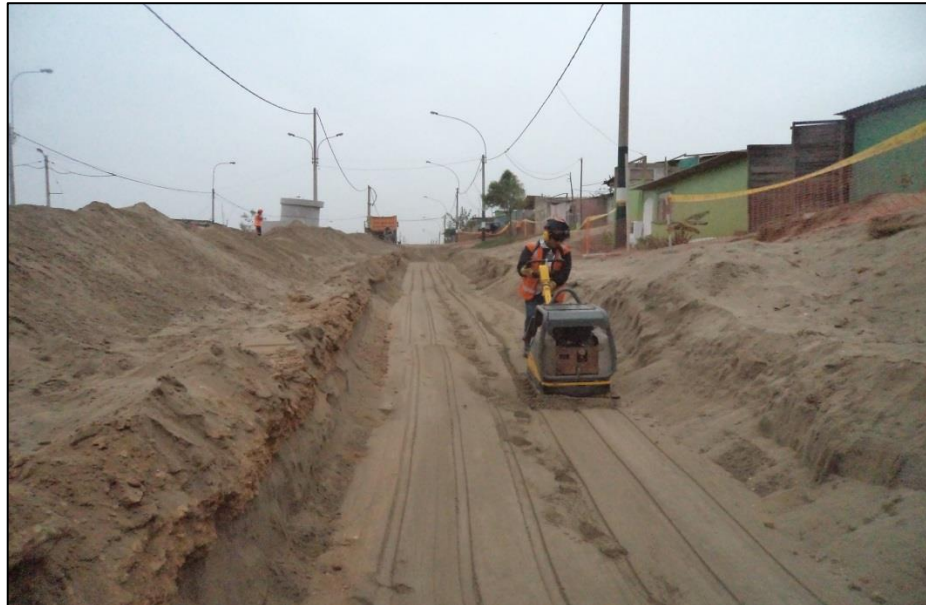
FOTO N°48: Precompactación con plancha vibratoria en aplicación de excavación tipo III en red de alcantarillado (TIII-002).
