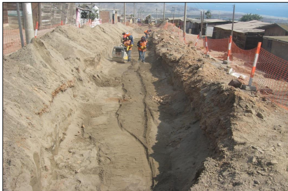
FOTO N° 55: Precompactación con plancha vibratoria previo a la aplicación de excavación tipo III (TIII-003).
