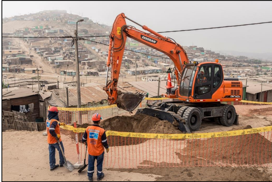
Fig.N°38: Excavadora Doosan DX140F
