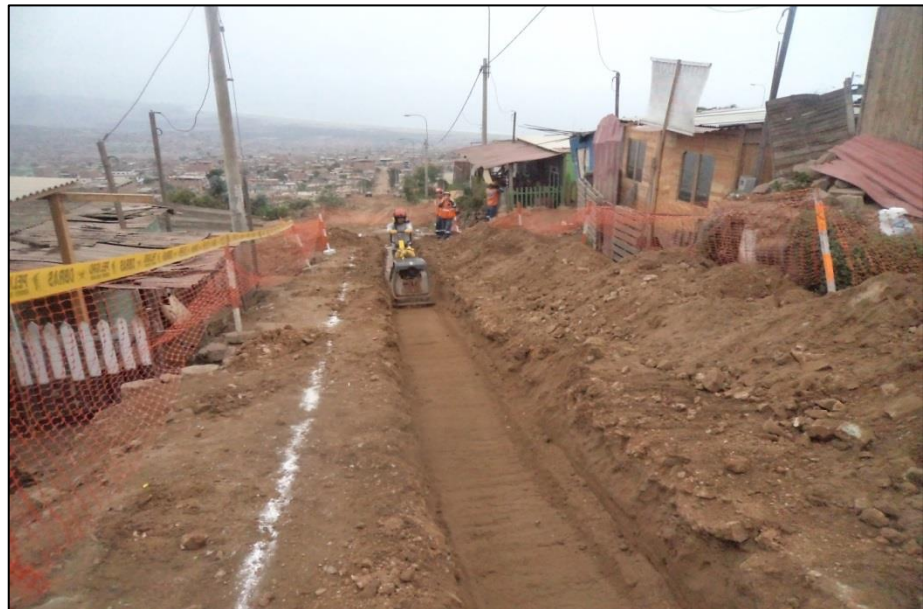
FOTO N°26: Precompactación con plancha vibratoria (TI-004).
