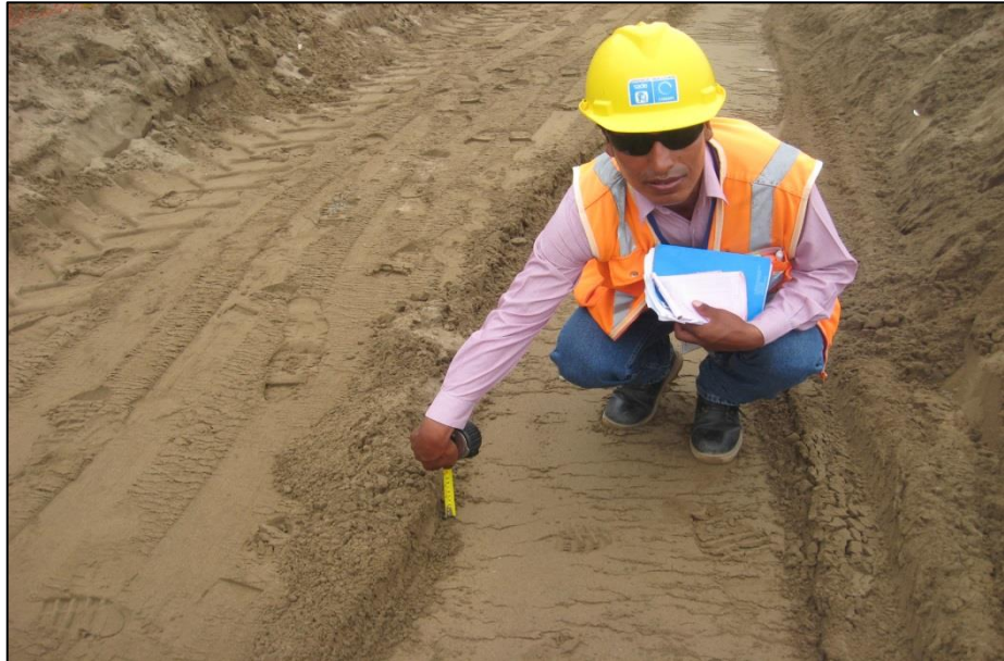
FOTO N°37: Efecto de la precompactación con plancha vibratoria previo a la excavación tipo II en red de alcantarillado (TII-002).
