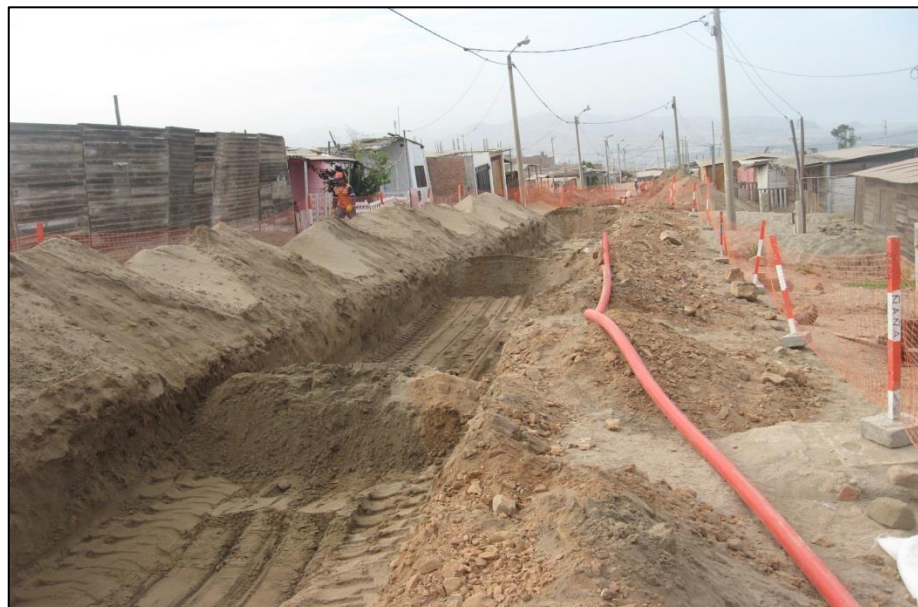
FOTO N°53: Arroceras en aplicación de excavación tipo III en red de alcantarillado (TIII-003).
