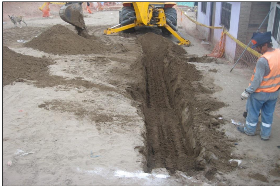
FOTO N°21: Aplicación de excavación tipo I en red de agua potable, trazo de eje (TI-003).
