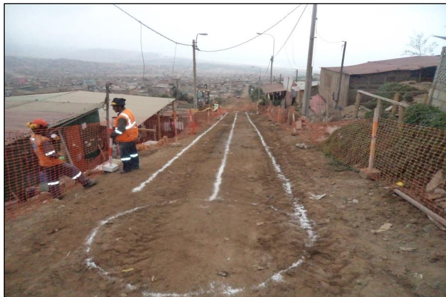
FOTO N°24: Trazo de eje de la red, excavación tipo I en red alcantarillado (TI-004).
