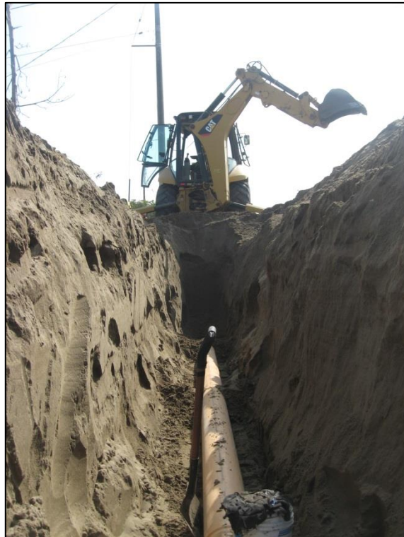
FOTO N°43: Culminación de excavación tipo II de red de alcantarillado(TII-004).
