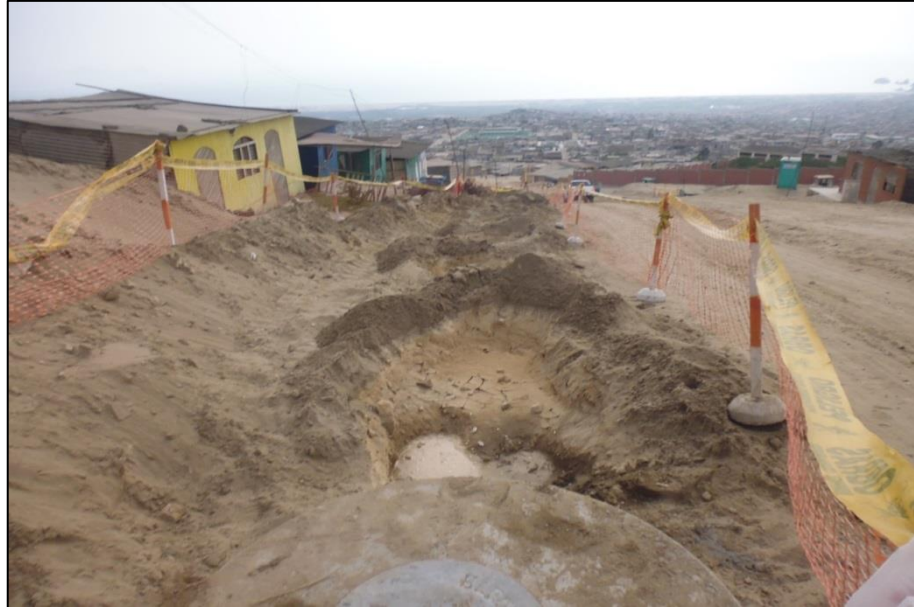
FOTO N°03: Arroceras para inundación con agua previa a la excavación (compactación hidráulica).
