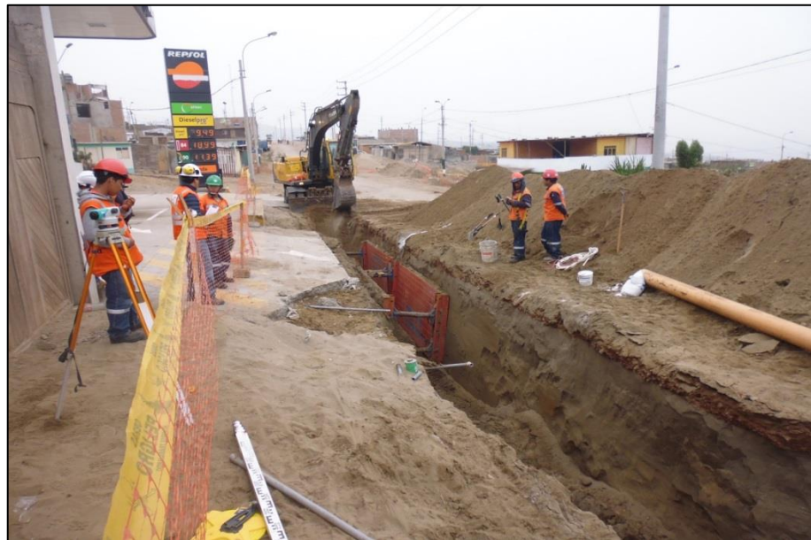
FOTO N°05: Entibados para excavación, su uso garantiza la seguridad mas no favorece la producción.
