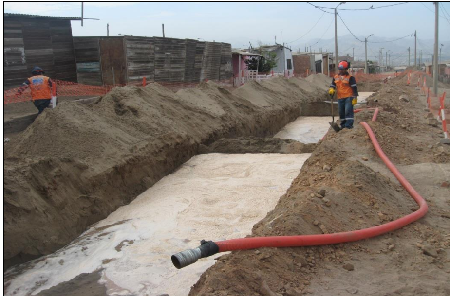
FOTO N° 54: Colocación de agua en arrozceras de aplicación de excavación tipo III en red de alcantarillado (TIII-003).
