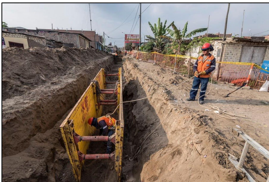
Fig.N°19: Sobre excavaciones y uso de entibados
