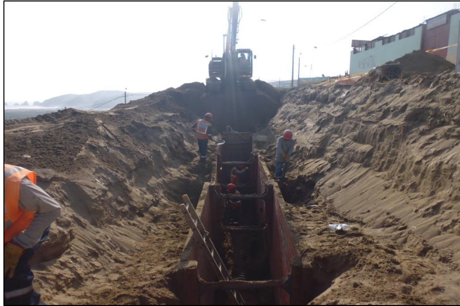
FOTO N°11: Necesidad de usar cantidad suficiente de entibados en excavaciones profundas.
