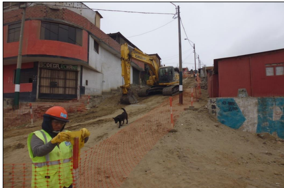
FOTO N°28: Zona de aplicación de excavación tipo I, en red de alcantarillado (TI-005).
