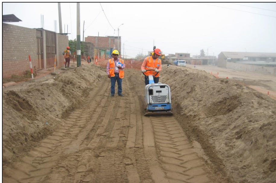
FOTO N°36: Precompactación con plancha vibratoria previo a la excavación tipo II en red de alcantarillado (TII-002).
