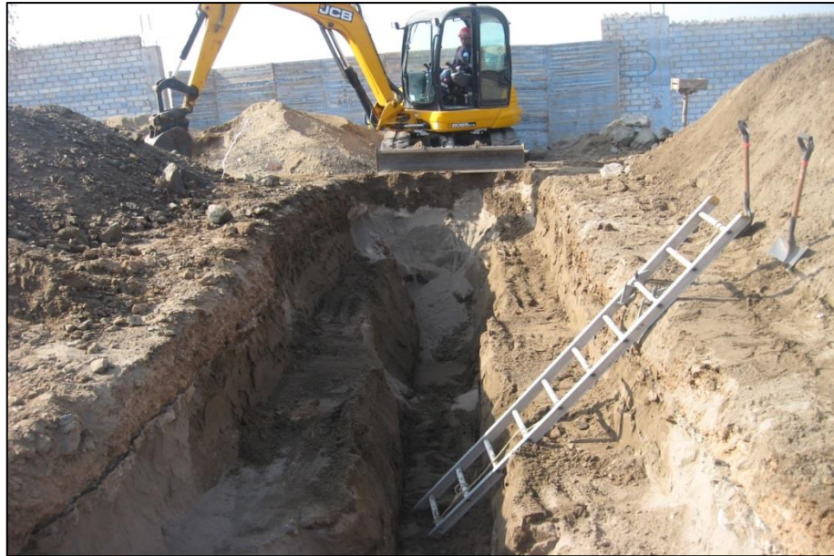
FOTO N°15: Prueba de aplicación de la metodología propuesta con mini excavadora (TI-001).
