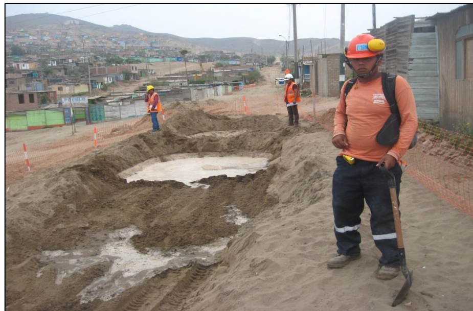
FOTO N°34: Arroceras en aplicación de excavación tipo II en red de alcantarillado (TII-002).
