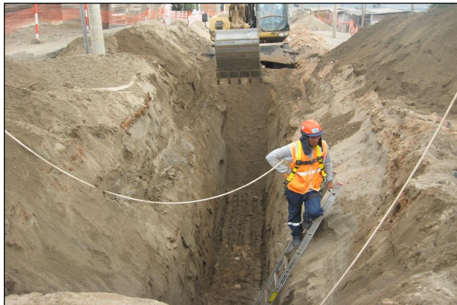
FOTO N° 57: Culminación de la aplicación de excavación tipo III (TIII-003).
