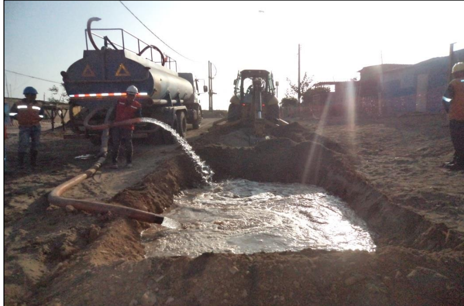
FOTO N°46: Arroceras y colocación de agua en aplicación de excavación tipo III en red de alcantarillado (TIII-002).
