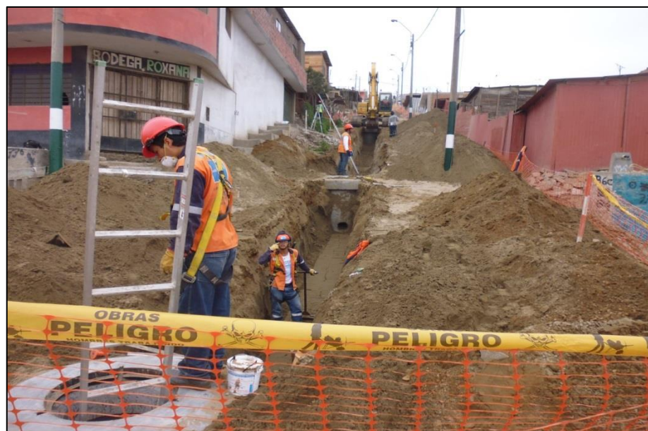
FOTO N°30: Excavación tipo I en red de alcantarillado (TI-005).
