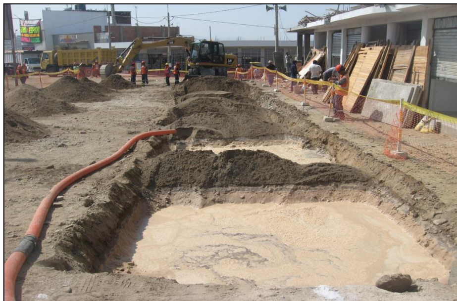
FOTO N°31: Arroceras en aplicación de excavación tipo II en red de alcantarillado (TII-001).
