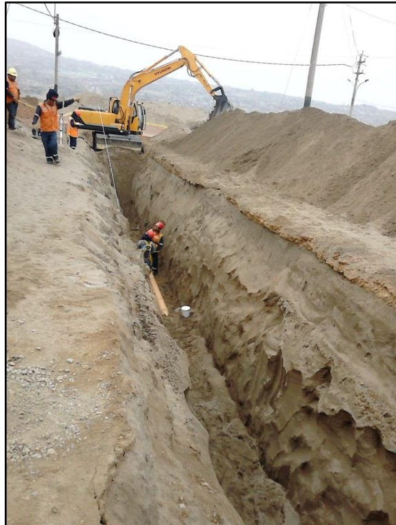
Fig.N°47: Implementación de diseño de excavación tipo III
