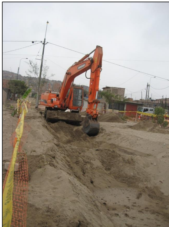
FOTO N°44: Arroceras en aplicación de excavación tipo II en red de alcantarillado (TII-004).
