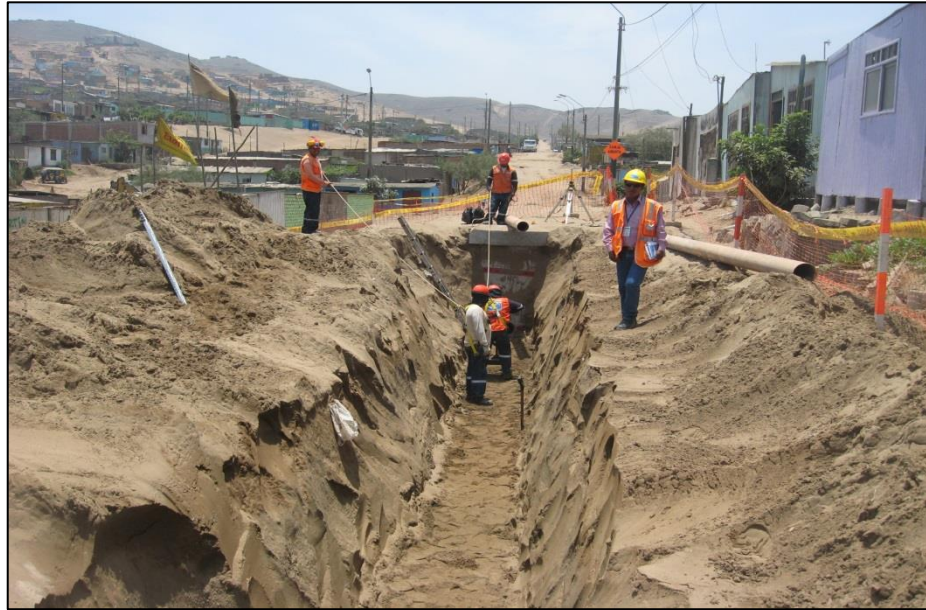
FOTO N°39: Culminación de excavación tipo II de red de alcantarillado (TII-002).
