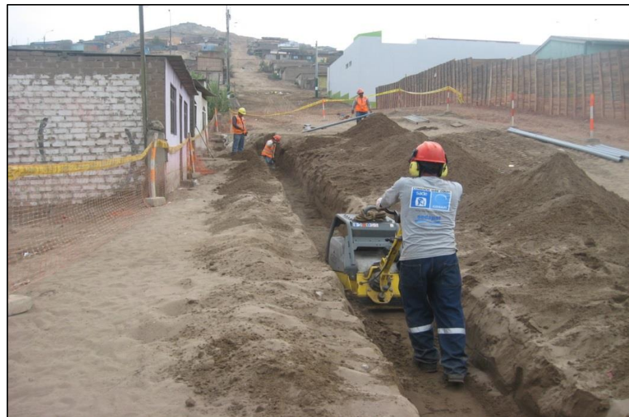
FOTO N°22: Precompactación con plancha compactadora, excavación tipo I en red de agua potable (TI-003).
