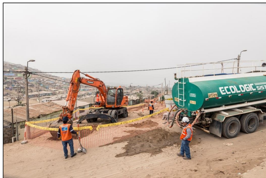
FOTO N°06: Cisterna de agua para compactación hidráulica, excavación inmediata a la colocación de agua.
