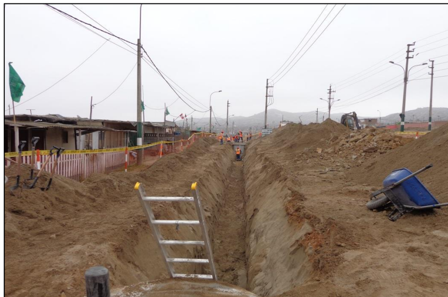
FOTO N°43: Culminación de excavación tipo II de red de alcantarillado (TII-005).
