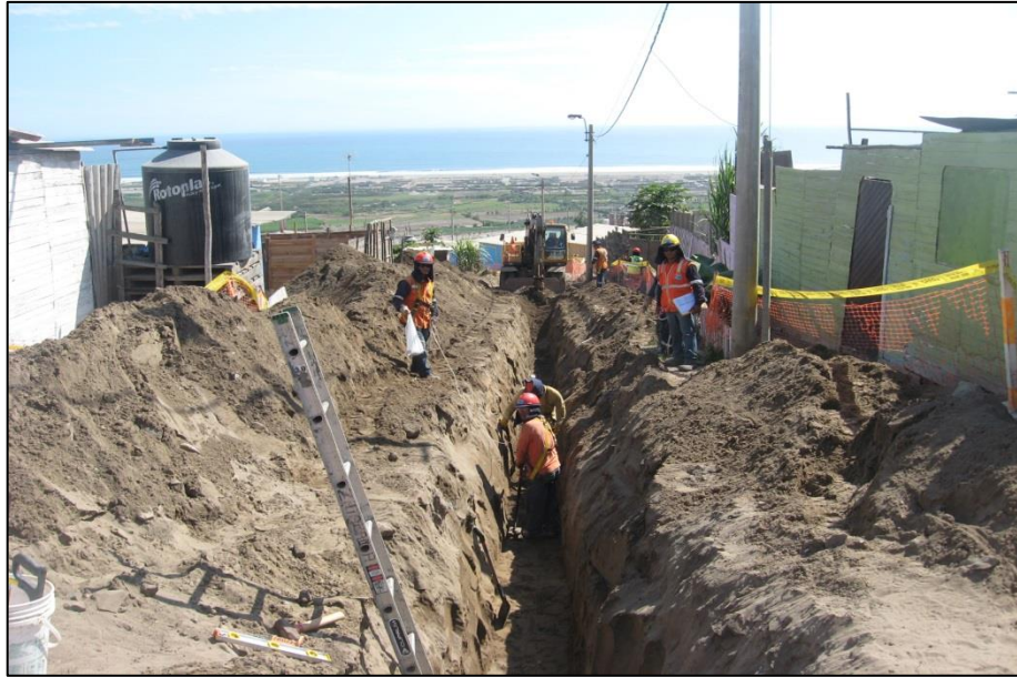
FOTO N°43: Culminación de excavación tipo II de red de alcantarillado(TII-003).
