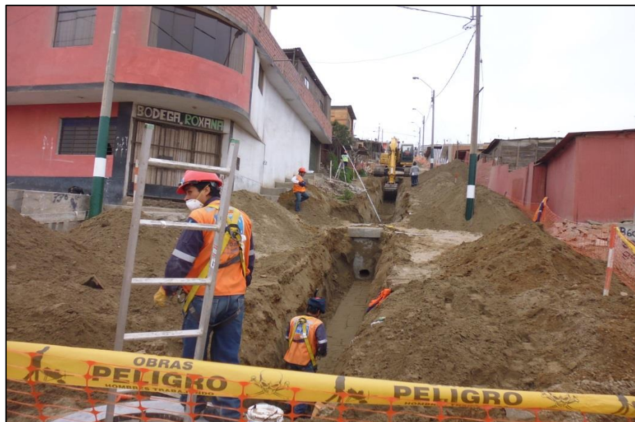
FOTO N°29: Excavación tipo I en red de alcantarillado (TI-005).
