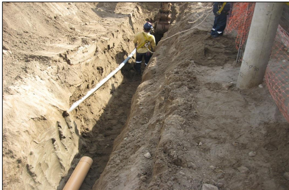
FOTO N°42: Culminación de excavación tipo II de red de alcantarillado (TII-003).
