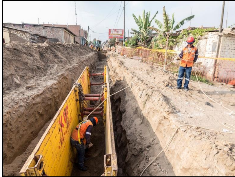
Fig.N°04: Entibados y sobre excavaciones
