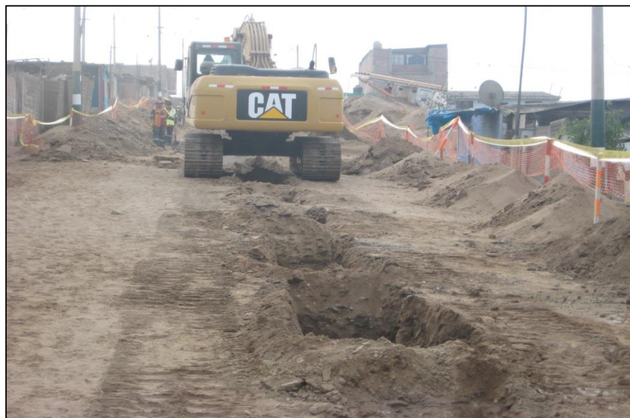
FOTO N°08: Arroceras para compactación hidráulica sin dimensiones definidas.
