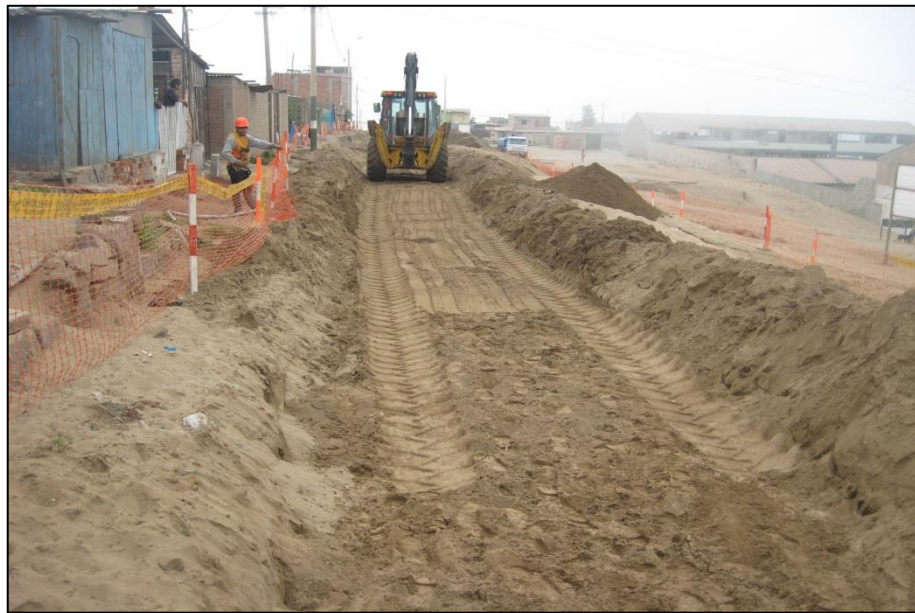
FOTO N°35: Demolición y nivelación de arroceras en aplicación de excavación tipo II en red de alcantarillado (TII-002).
