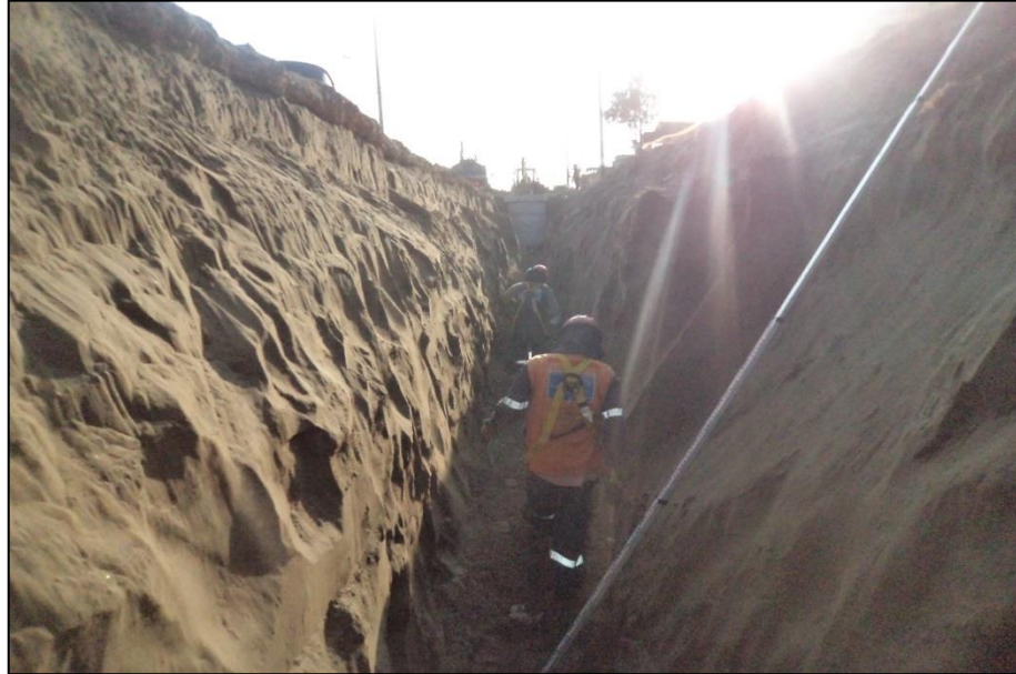
FOTO N°52: Culminación de aplicación de excavación tipo III en red de alcantarillado (TIII-002).
