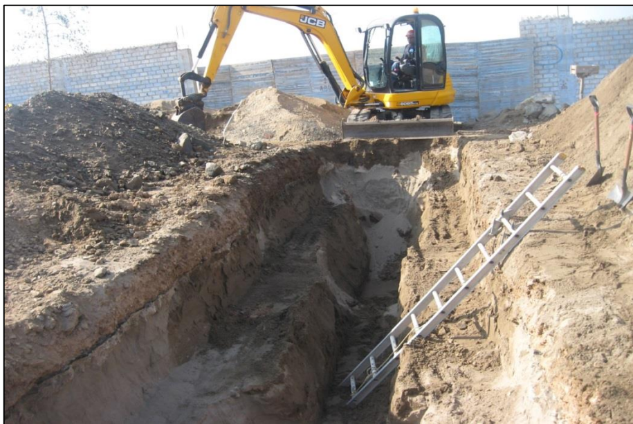
FOTO N°16: Prueba de aplicación de la metodología propuesta con mini excavadora (TI-001).
