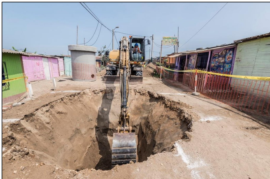
FOTO N°01: Excavación para colocación de buzón de desagüe, calle angosta viviendas contiguas.
