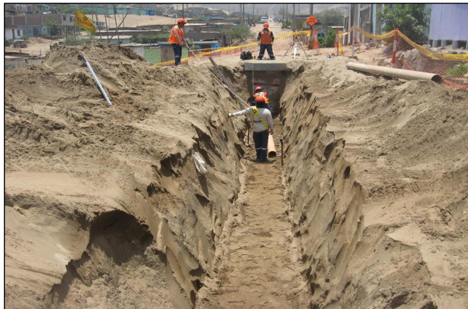
FOTO N°40: Culminación de excavación tipo II de red de alcantarillado (TII-002).
