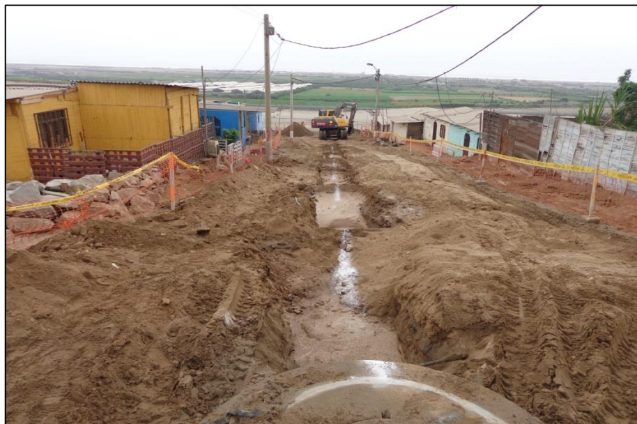
FOTO N°04: Arroceras para inundación con agua previa a la excavación (compactación hidráulica en suelos arenosos).
