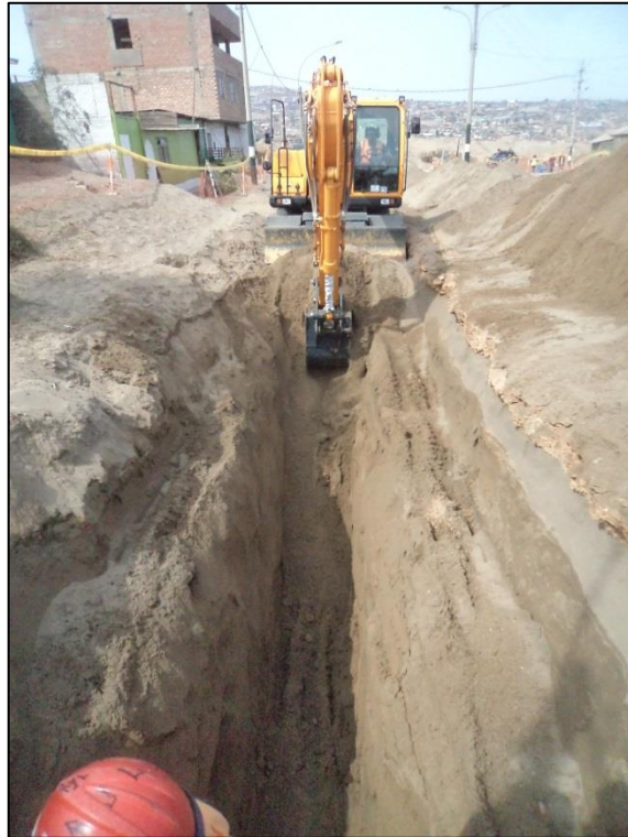
FOTO N°50: Culminación de aplicación de excavación tipo III en red de alcantarillado (TIII-002).
