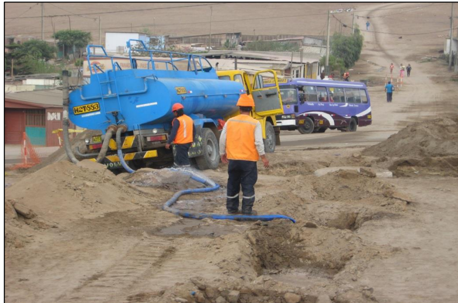
FOTO N°09: Compactación hidráulica sin racionamiento de agua determinado.
