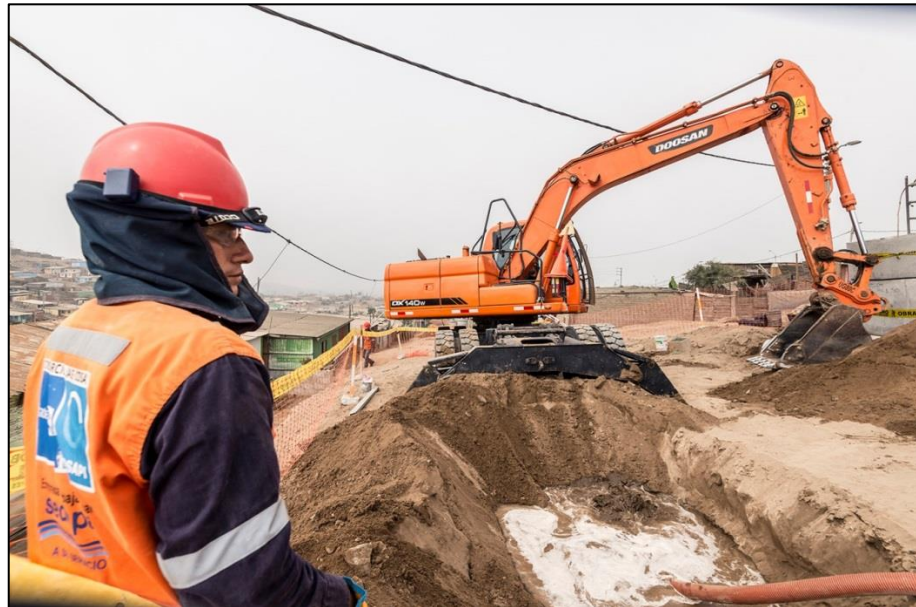
FOTO N°07: Excavación inmediata a la colocación de agua en arrozceras.
