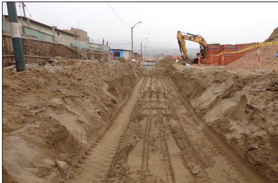
FOTO N°44: Demolición y nivelación de arroceras, excavación tipo III en red de alcantarillado (TIII-001).
