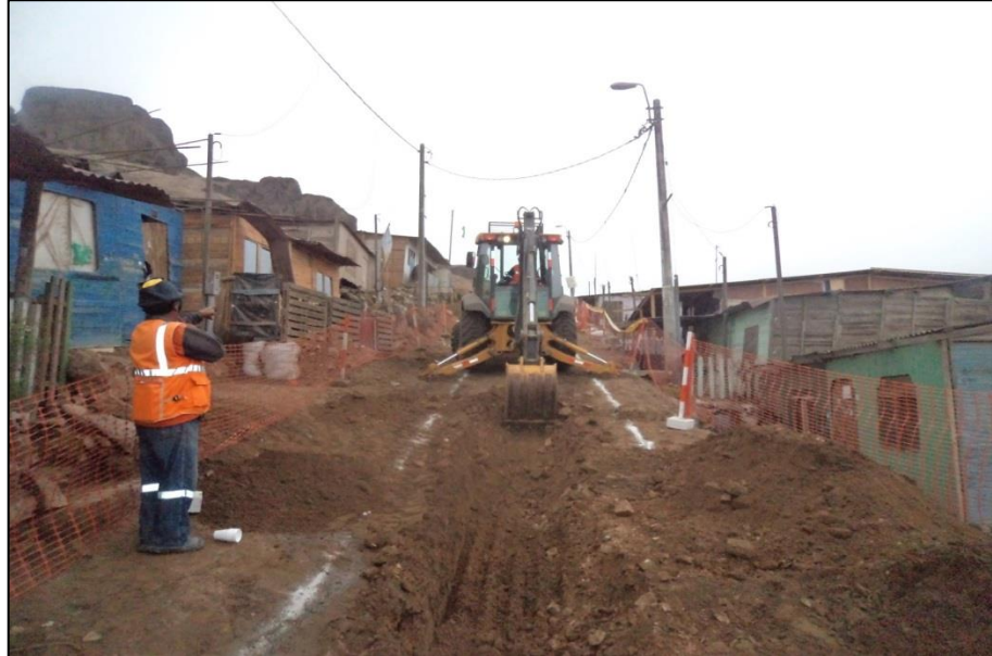
FOTO N°25: Excavación y retiro de material lastrado previo a la precompactación (TI-004)
