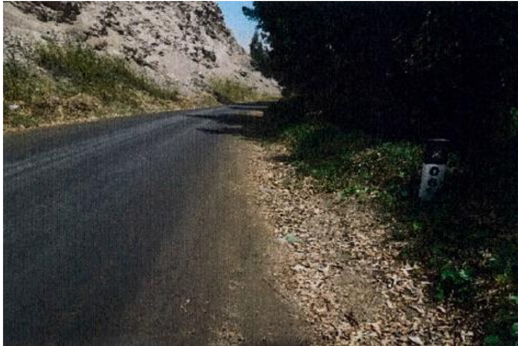
Figura N° 94 Vista hacia atrás del Km 06+000, foto tomada a los 14 meses de haberse rehabilitado el camino. (02-09-2015)
