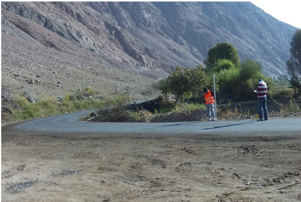
Figura N° 133 Medición del Parámetro polvo URCI Y Grado de Polvo. Prog.km 07+750, foto tomada a los 22 meses de haberse rehabilitado el camino (16-05-2016)
