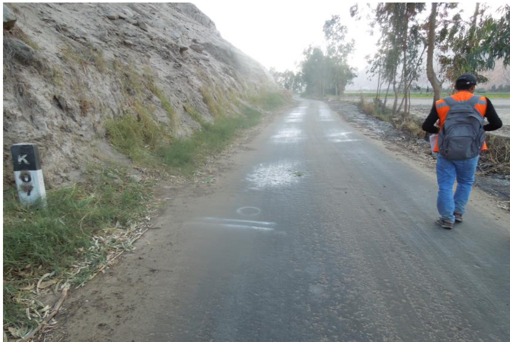
Figura N° 106 Vista hacia atrás del Km 07+000, foto tomada a los 22 meses de haberse rehabilitado el camino. (16-05-2016)
