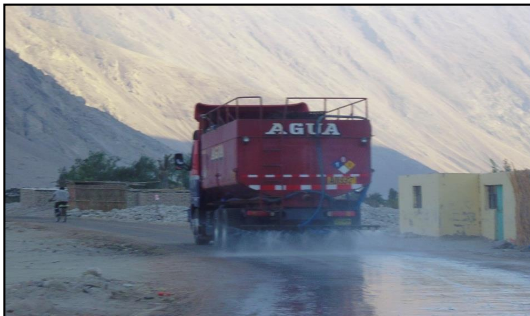
Figura N° 39 Progresiva Km 24+360, aplicación del tratamiento supresor de polvo sobre la superficie compactada.
