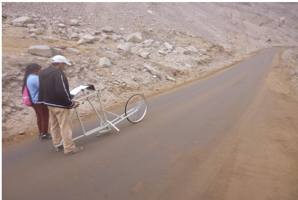
Figura N° 131 Medición de la rugosidad empleando el equipo MERLIN. Prog.km 14+200, foto tomada a los 0 meses de haberse rehabilitado el camino (22-07-2014)
