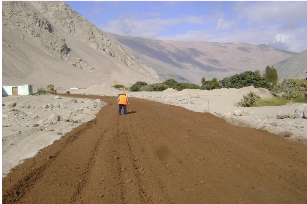
Figura N° 119 Conformación del material granular, el material granular empleado fue previamente mezclado con salmuera en la cantera. Prog.km 23+800.
