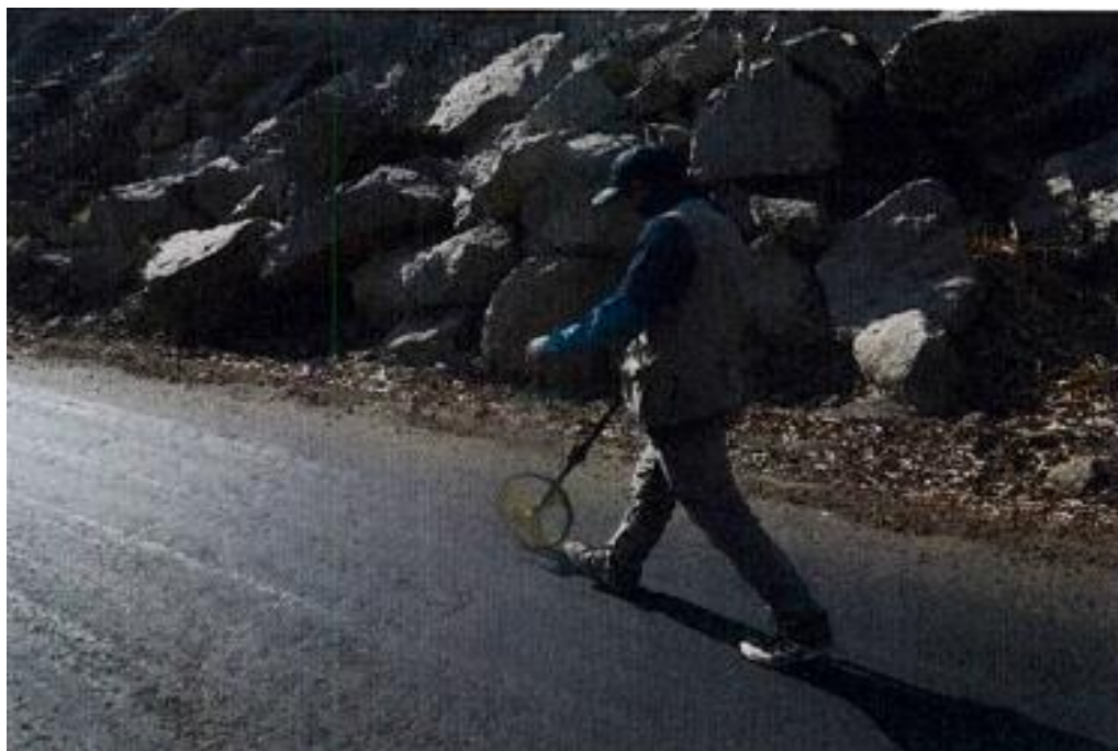
Figura N° 125 Inicio del demarcado superficial de la capa de rodadura para delimitar las unidades de muestra. Prog.km 05+000, foto tomada a los 14 meses de haberse rehabilitado el camino (02-09-2015)
