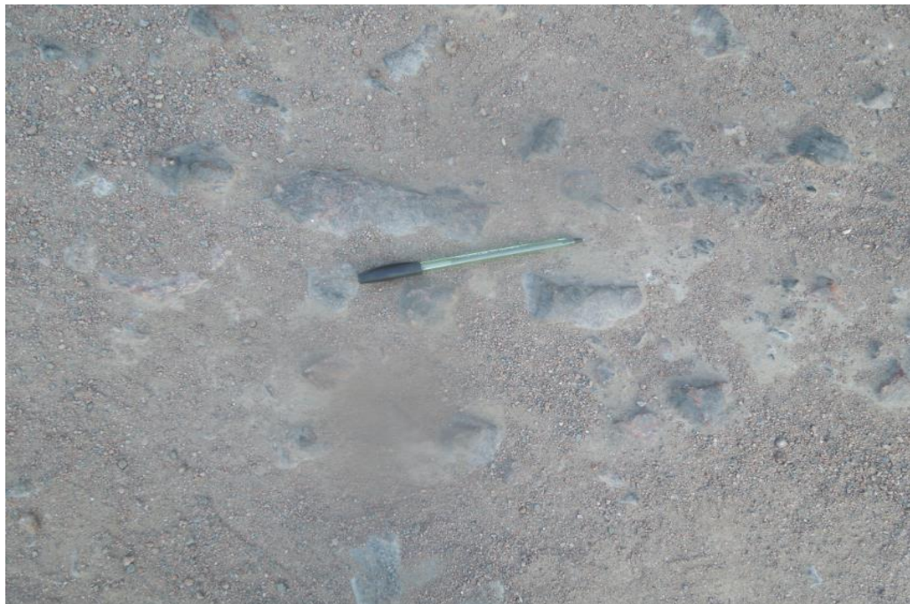
Figura N° 128 Piedra perteneciente a la capa de rodadura mayor a 2". Prog.km 07+350, foto tomada a los 22 meses de haberse rehabilitado el camino (16-05-2016)
