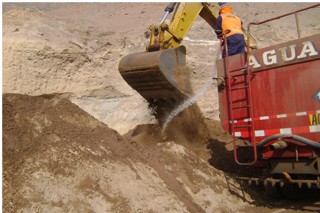
Figura N° 117 Mezcla en cantera del material previamente cubicada con la salmuera. Prog.km 09+550.
