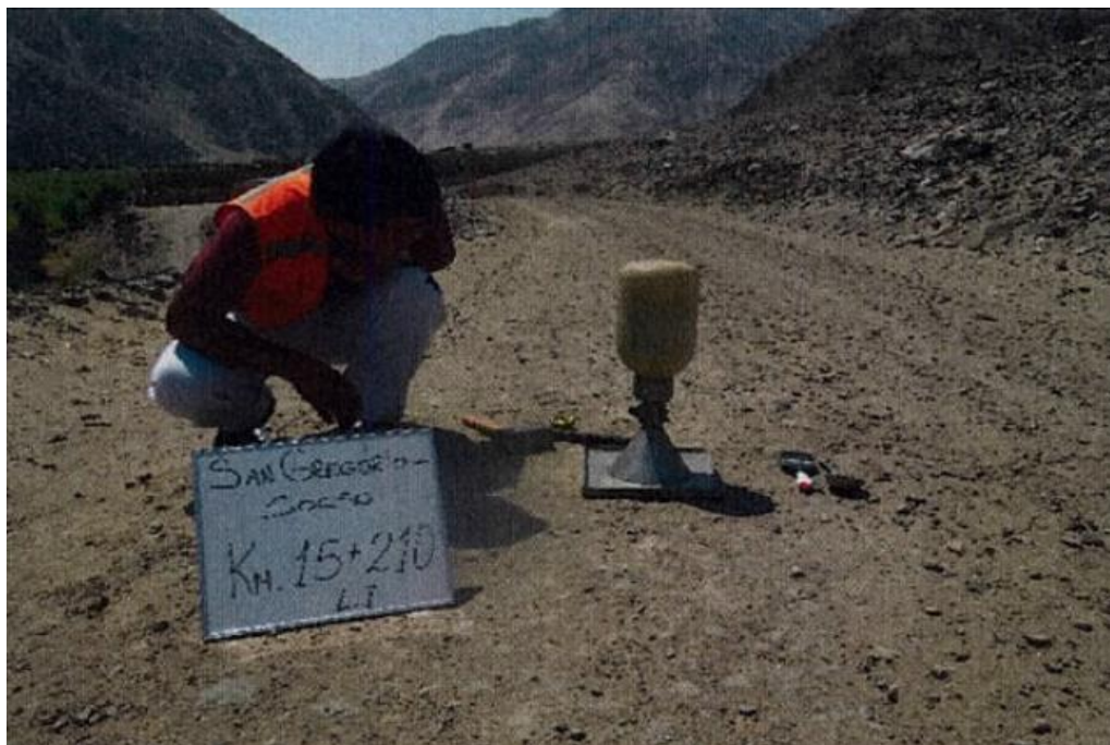
Figura N° 135 Extracción de muestra y ensayo de densidad de campo. Prog.km 15+210, foto tomada a los 14 meses de haberse rehabilitado el camino (02-09-2015).
