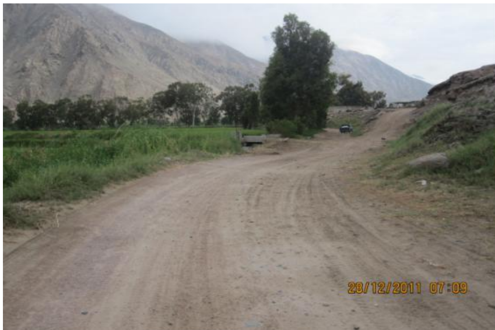
Figura N° 83 Vista hacia adelante del Km 05+500, foto tomada antes de la rehabilitación del camino. (28-12-2011)
