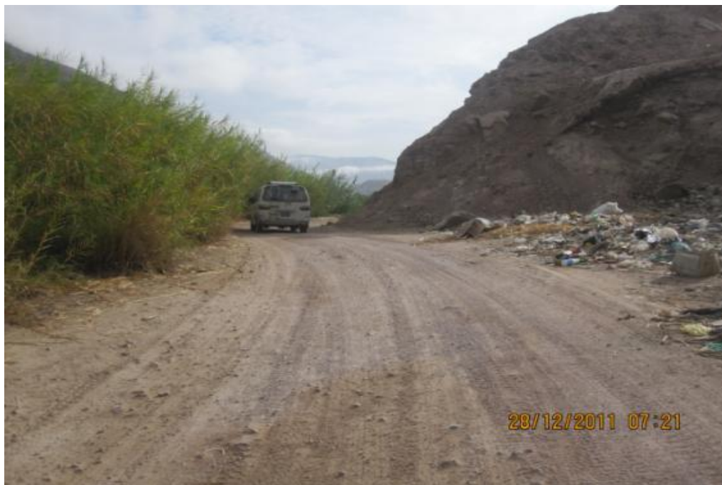
Figura N° 85 Vista hacia adelante del Km 08+100, foto tomada antes de la rehabilitación del camino. (28-12-2011)
