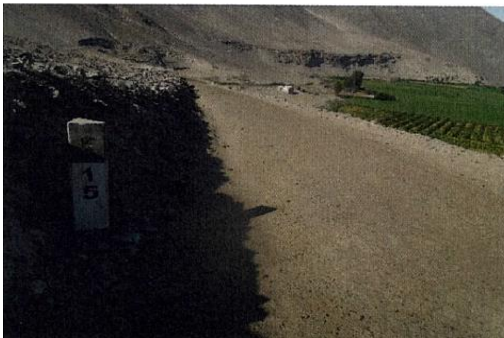
Figura N° 103 Vista hacia atrás del Km 15+000, foto tomada a los 14 meses de haberse rehabilitado el camino. (02-09-2015)
