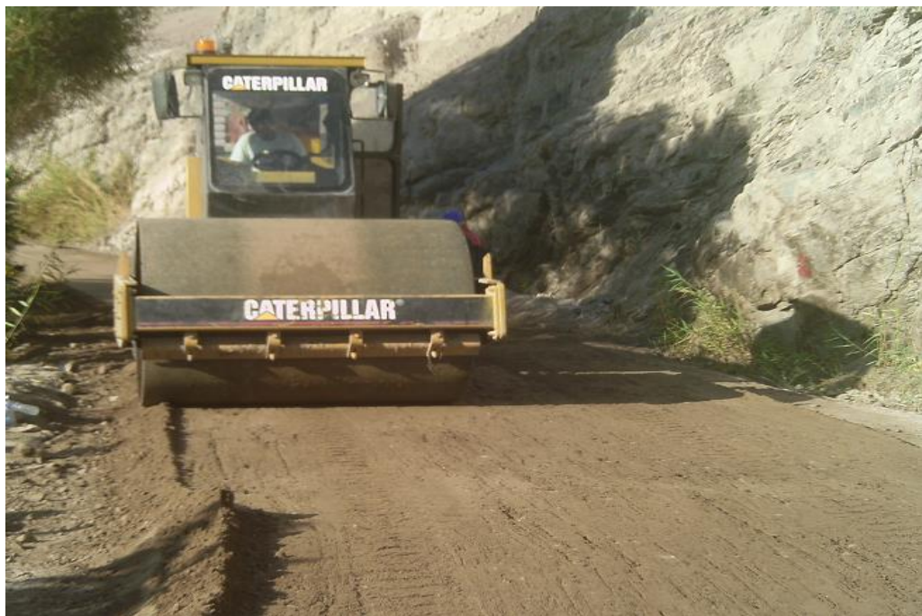
Figura N° 122 Compactado del material granular previamente conformado. Prog.km 22+950.
