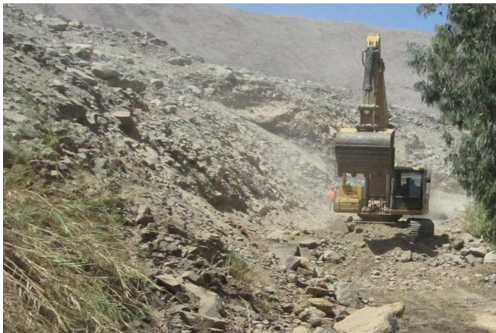
Figura N° 115 Ensanche de la plataforma con excavadora sobre orugas. Prog.km 21+080.
