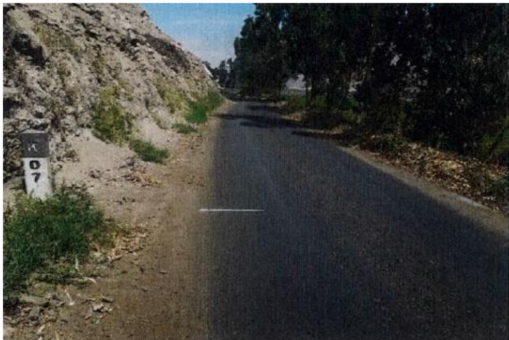
Figura N° 95 Vista hacia atrás del Km 07+000, foto tomada a los 14 meses de haberse rehabilitado el camino. (02-09-2015).
