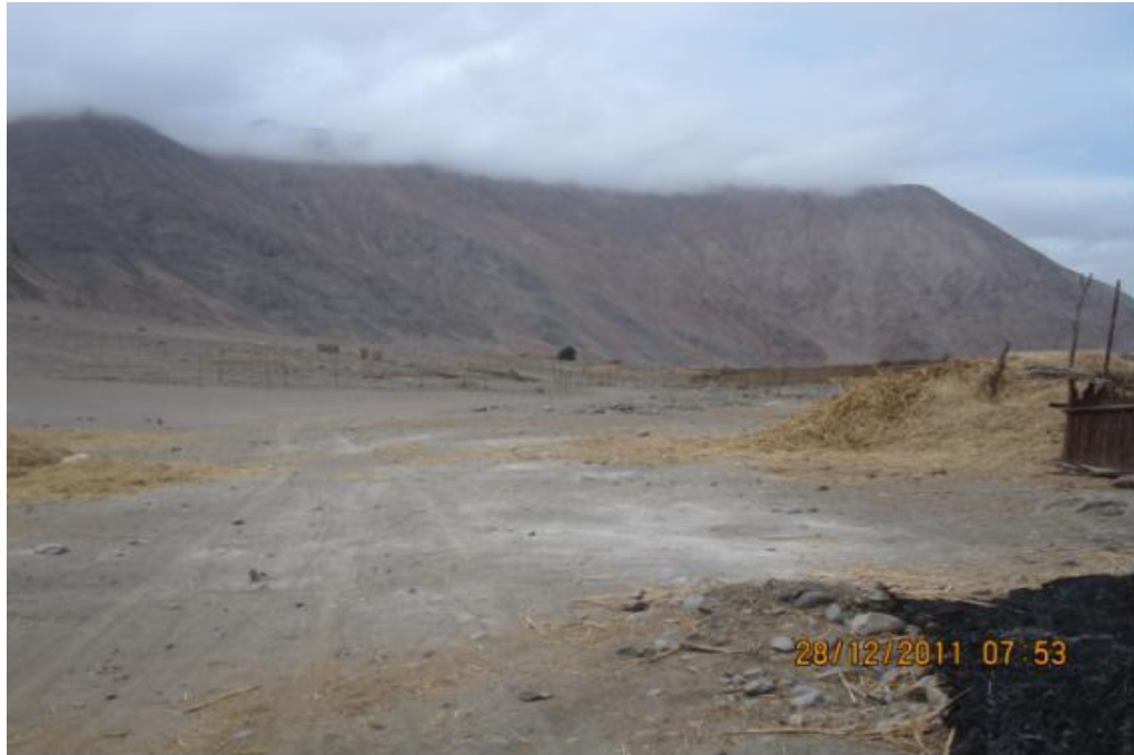
Figura N° 86 Vista hacia atrás del Km 12+000, foto tomada antes de la rehabilitación del camino. (28-02-2011)
