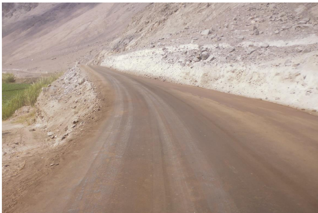
Figura N° 91 Vista hacia atrás del Km 18+200, foto tomada a los 0 meses de haberse rehabilitado el camino. (22-07-2014)
