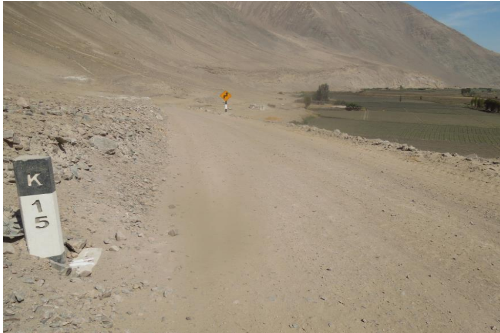
Figura N° 114 Vista hacia atrás del Km 15+000, foto tomada a los 22 meses de haberse rehabilitado el camino. (16-05-2016)
