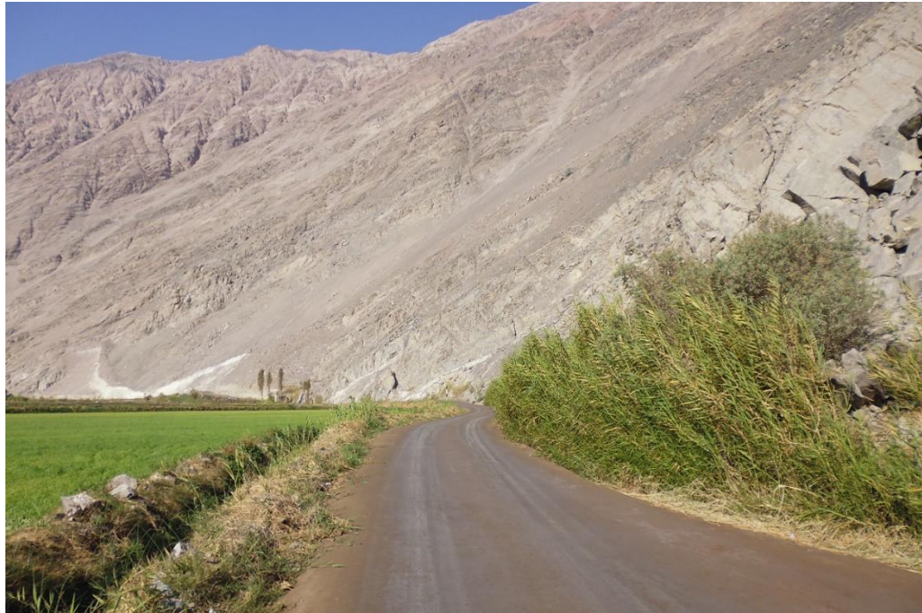
Figura N° 92 Vista hacia atrás del Km 21+600, foto tomada a los 0 meses de haberse rehabilitado el camino. (22-07-2014)
