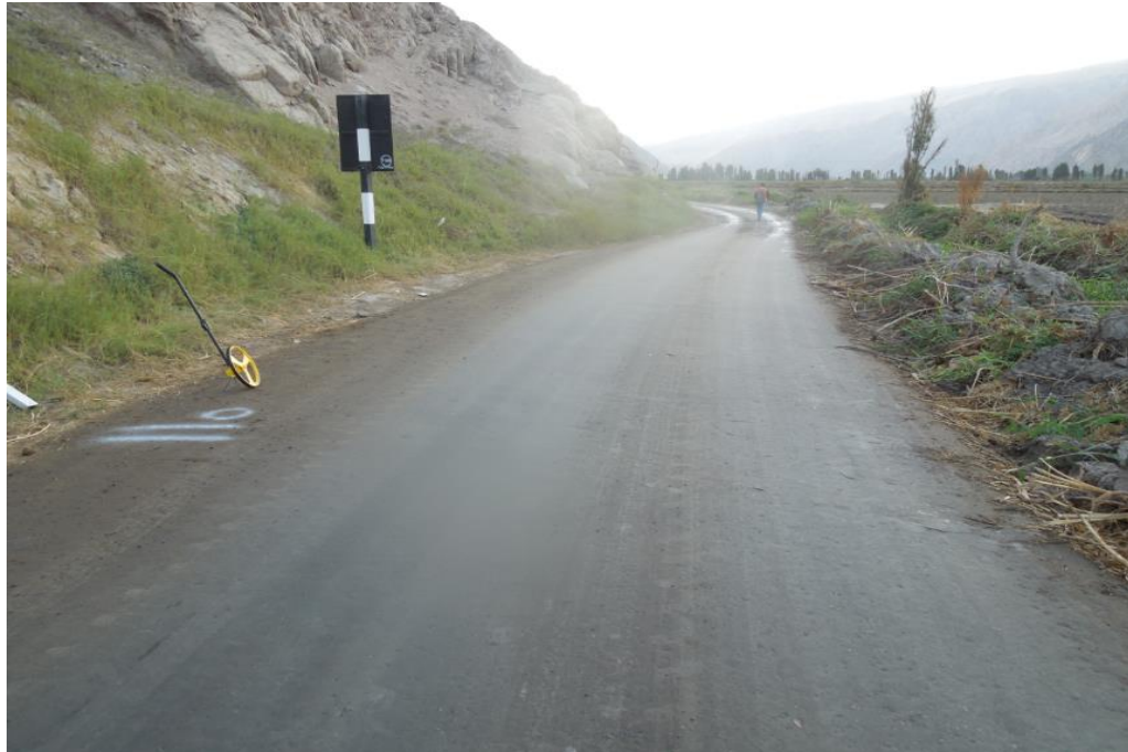
Figura N° 104 Vista hacia atrás del Km 05+000, foto tomada a los 22 meses de haberse rehabilitado el camino. (16-05-2016)
