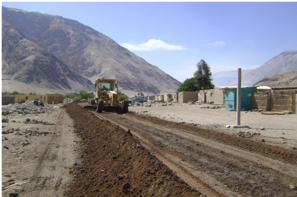
Figura N° 120 Conformación del material granular, el material granular empleado fue previamente mezclado con salmuera en la cantera. Prog.km 24+200.
