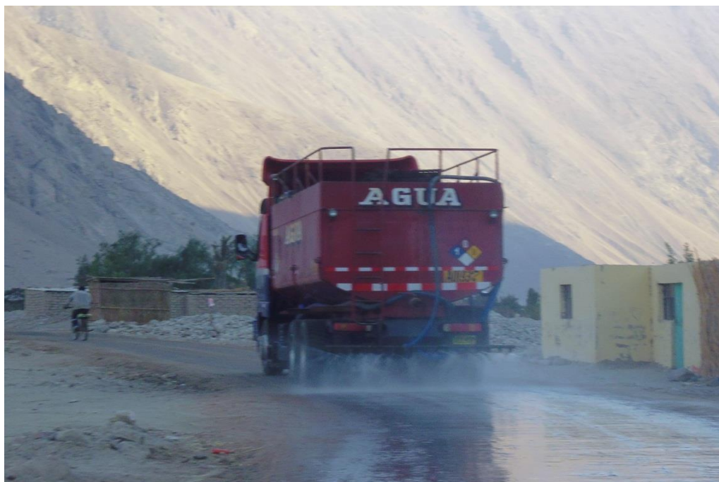
Figura N° 124 Sellado del afirmado estabilizado previamente compactado con salmuera. Prog.km 24+360.
