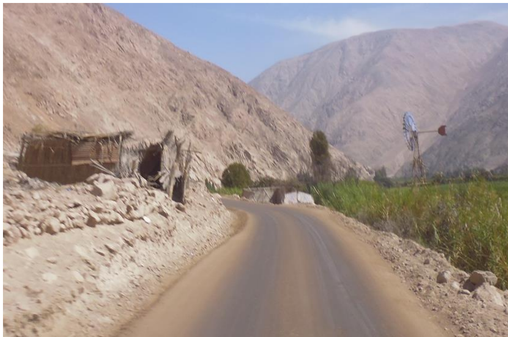
Figura N° 89 Vista hacia atrás del Km 07+700, foto tomada a los 0 meses de haberse rehabilitado el camino. (22-07-2014)
