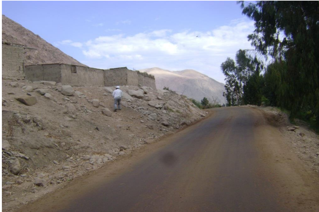
Figura N° 88 Vista hacia atrás del Km 05+400, foto tomada a los 0 meses de haberse rehabilitado el camino. (22-07-2014)
