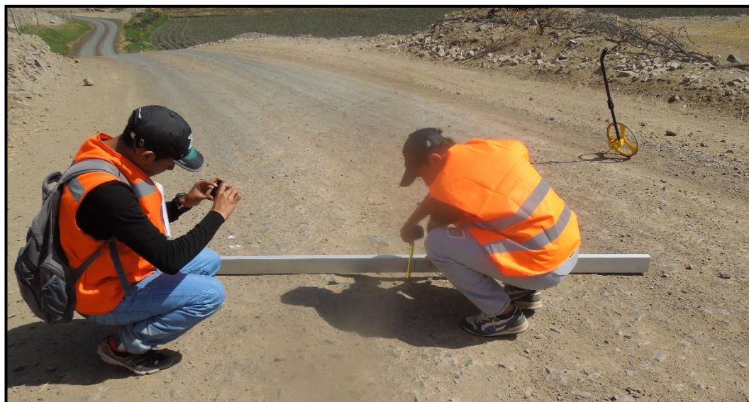
Figura N° 43 Medición de la falla perdida de agregado.
