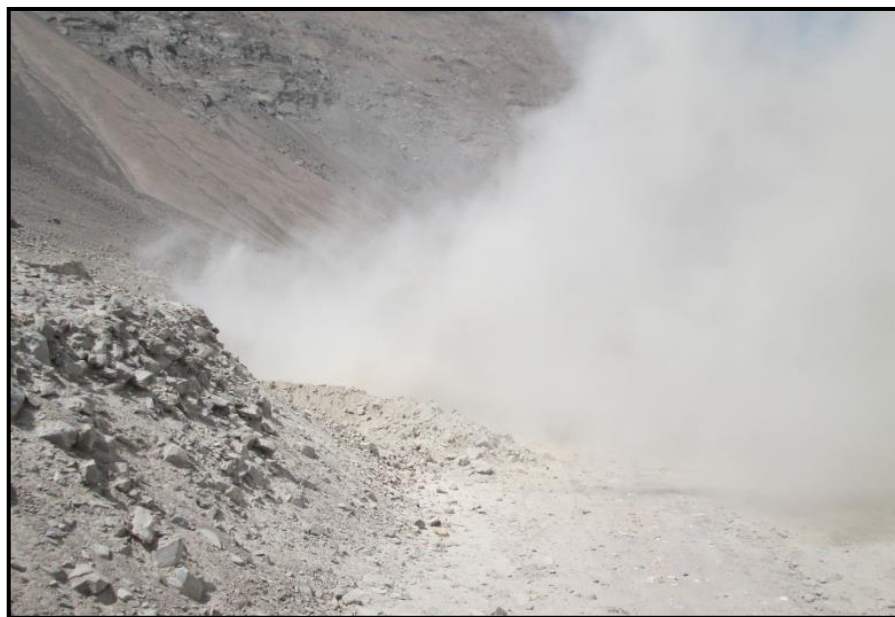
Figura N° 31 Polvo elevado sobre los 2.5m, vista de la carretera San Gregorio – Socso antes de ser estabilizada con Bischofita.
