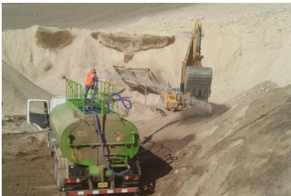
Figura N° 118 Mezcla en cantera del material previamente cubicada con la salmuera. Prog.km 20+200.
