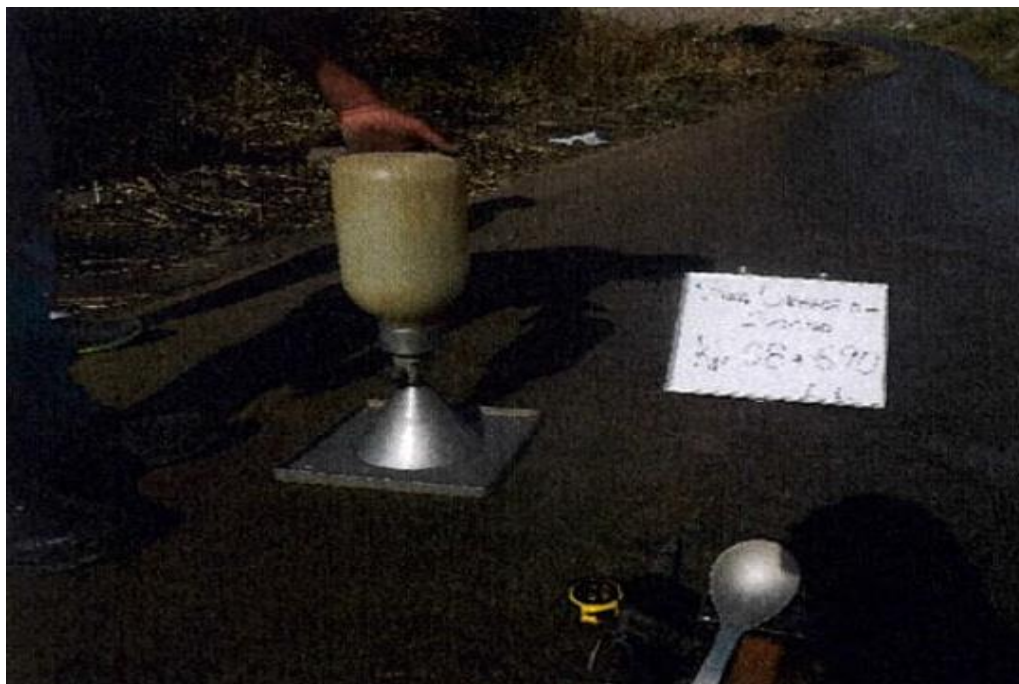
Figura N° 137 Extracción de muestra y ensayo de densidad de campo. Prog.km 08+690, foto tomada a los 14 meses de haberse rehabilitado el camino San Gregorio Socso (02-09-2015)
