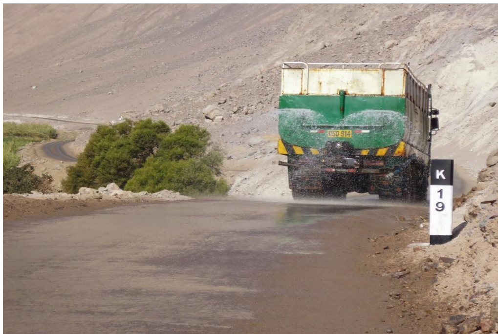
Figura N° 123 Sellado del afirmado estabilizado previamente compactado con salmuera. Prog.km 19+000.
