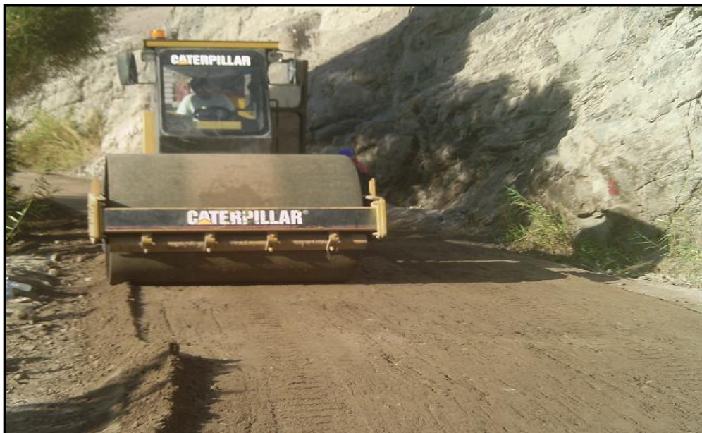
Figura N° 38 Progresiva Km 22+950, compactado del afirmado estabilizado
