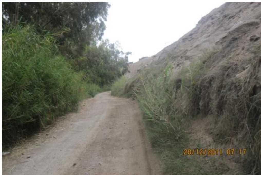
Figura N° 84 Vista hacia adelante del Km 07+100, foto tomada antes de la rehabilitación del camino. (28-12-2011)
