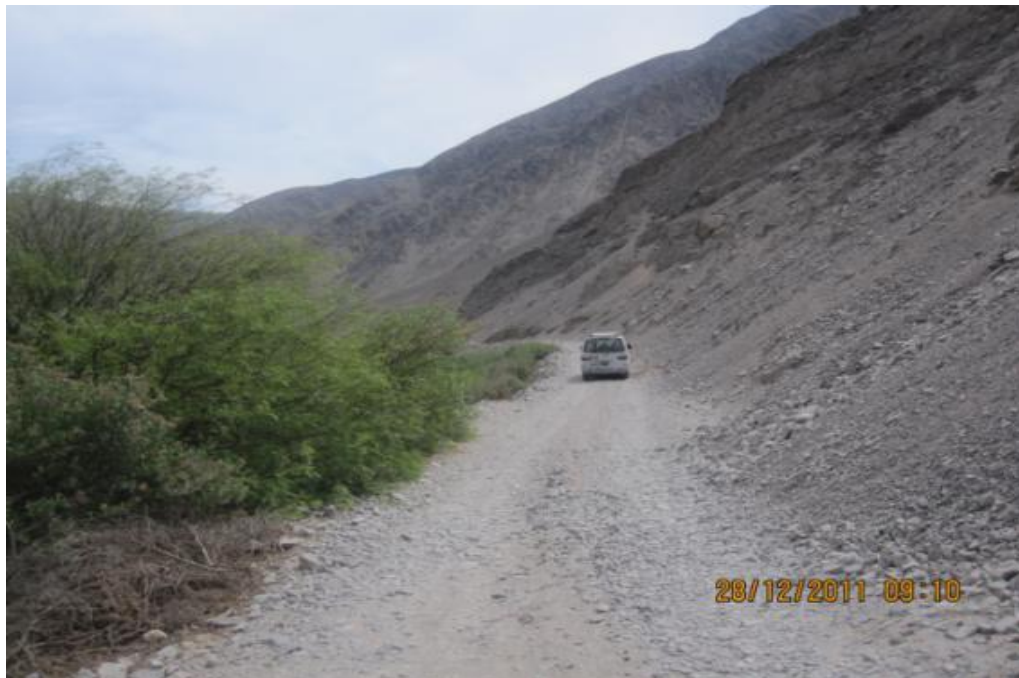
Figura N° 87 Vista hacia adelante del Km 14+200, foto tomada antes de la rehabilitación del camino. (28-12-2011)
