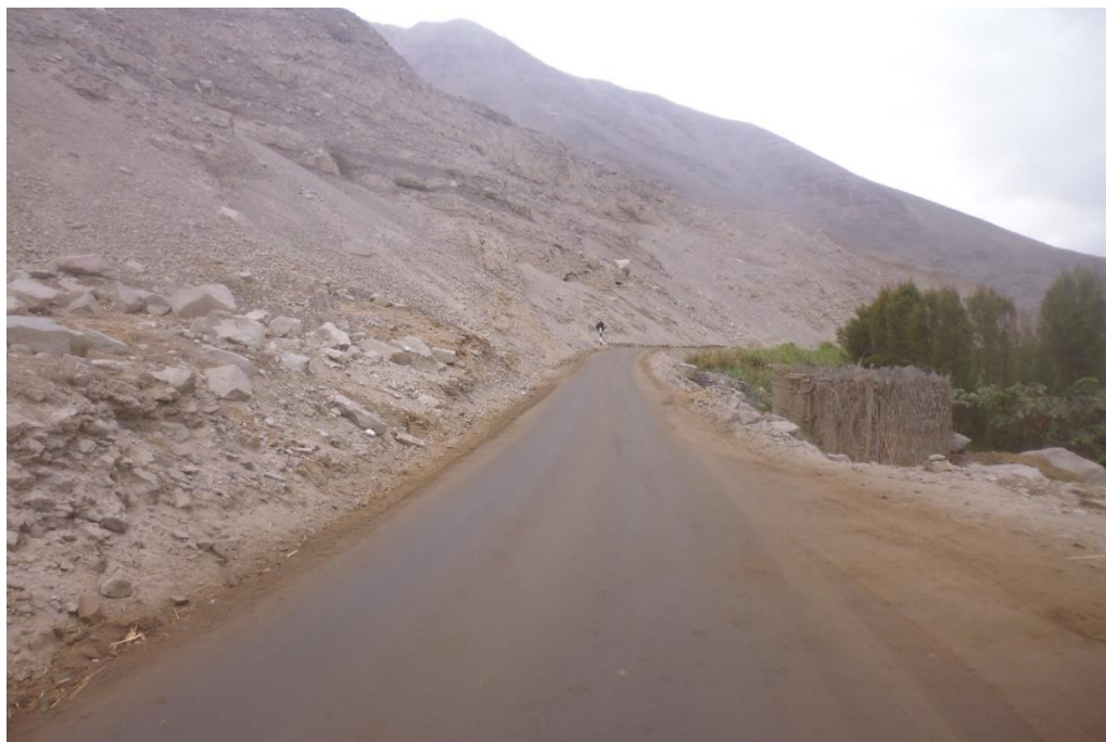
Figura N° 90 Vista hacia atrás del Km 14+230, foto tomada a los 0 meses de haberse rehabilitado el camino. (22-07-2014)
