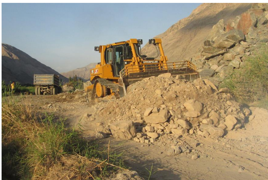
Figura N° 116 Ensanche de la plataforma con un tractor sobre orugas. Prog.km 21+800.
