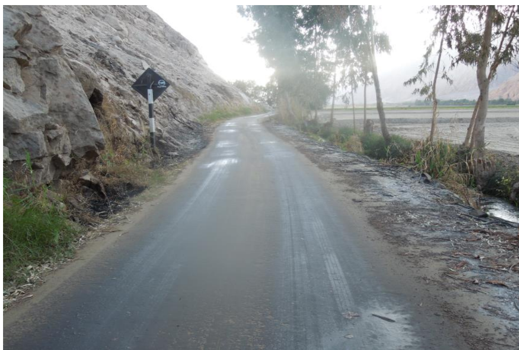
Figura N° 130 Humedad retenida en la superficie por el Cloruro de Magnesio. Prog.km 07+100, foto tomada a los 22 meses de haberse rehabilitado el camino (16-05-2016)
