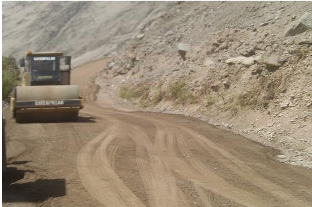
Figura N° 121 Compactado del material granular previamente conformado. Prog.km 21+360.
