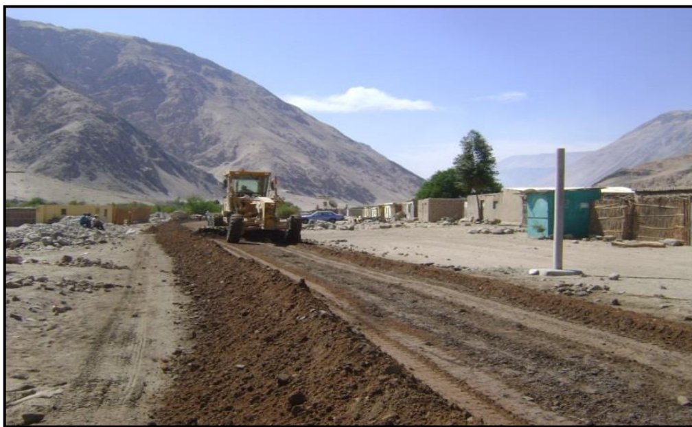
Figura N° 37 Progresiva Km 24+200, conformación y perfilado del material granular
