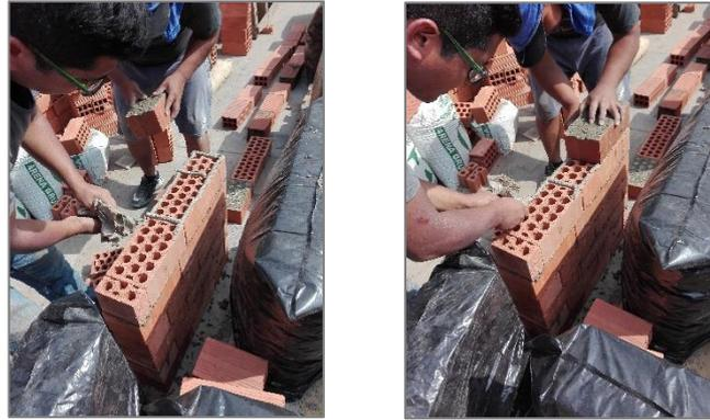
Figura N° 5.21 Construcción de muretes de ladrillos King Kong 18 huecos y mortero polimérico
