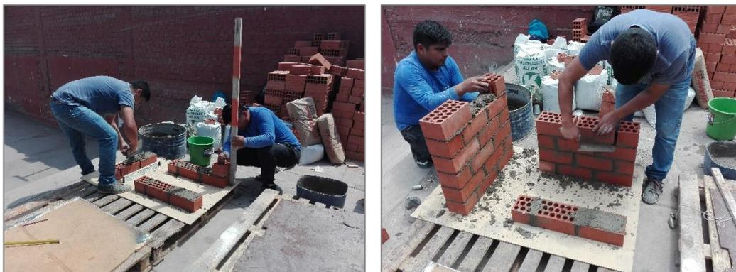
Figura N° 5.19 Asentado de la primera hilada y nivelamiento (izquierda); Colocación de mortero de cemento y asentado de ladrillos (derecha)
