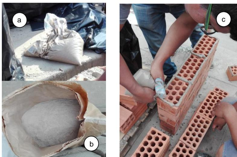
Figura N° 2.21 a) Envase de presentación húmeda del mortero polimérico Pegablock; b) Envase de presentación seca del mortero polimérico Pegablock; c) Aplicación de mortero polimérico Pegablock
