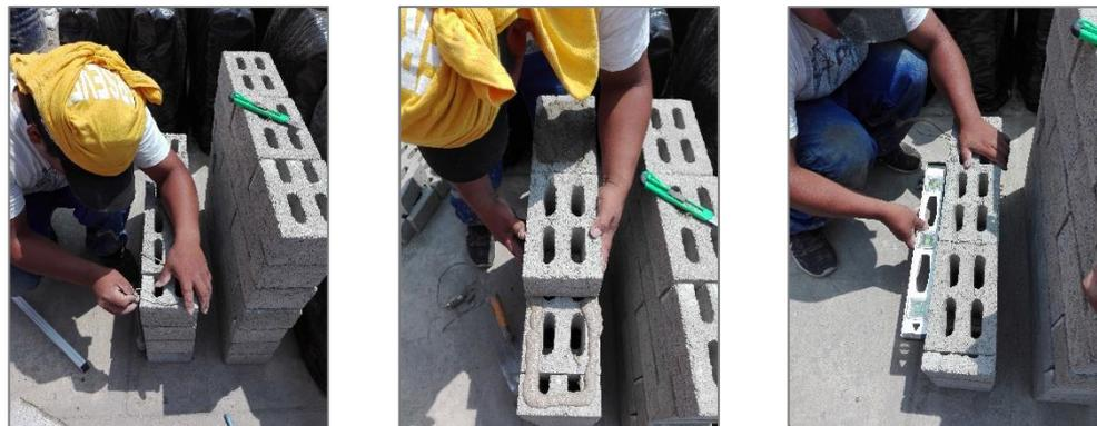
Figura N° 5.23 Construcción de muretes de ladrillos Konkreto y mortero polimérico
