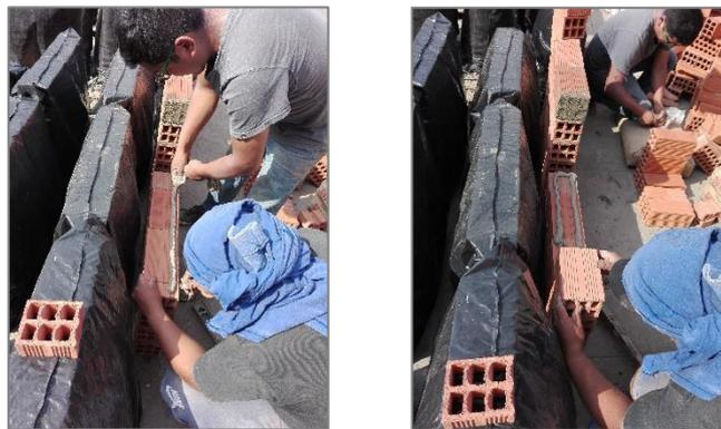
Figura N° 5.22 Construcción de muretes de ladrillos Pandereta Acanalada y mortero polimérico
