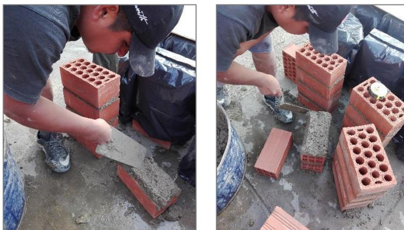
Figura N° 5.1 Colocación de mortero de cemento y asentado de ladrillos
