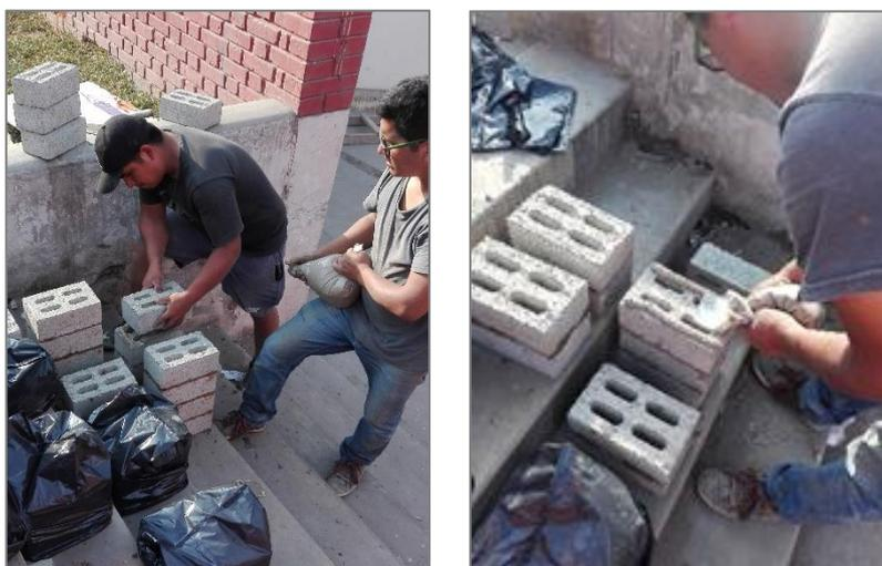
Figura N° 5.3 Construcción de pilas de albañilería (ladrillos Konkreto) mediante la aplicación de mortero polimérico
